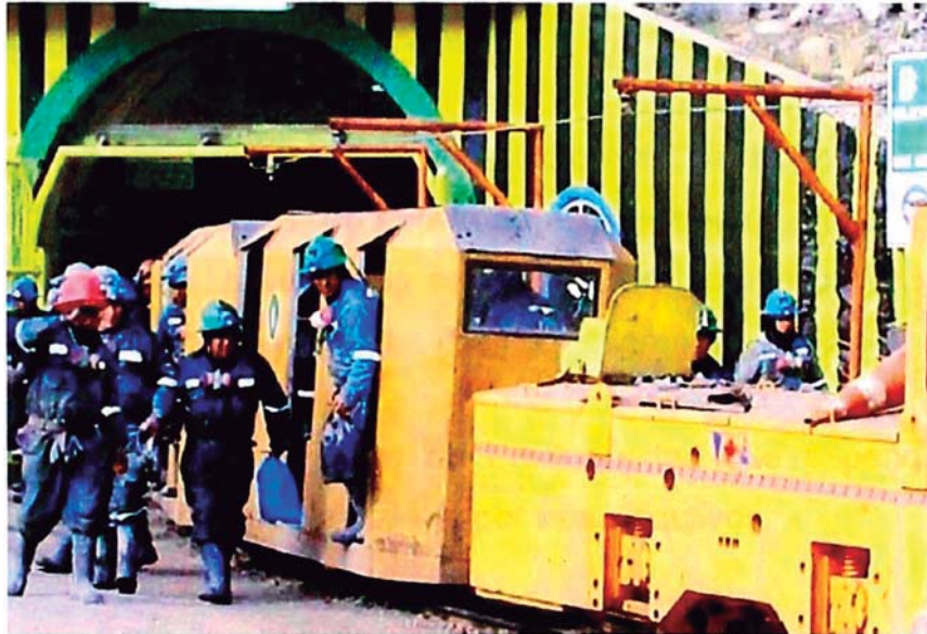
Figura 3. Túnel Principal a 4450msnm
