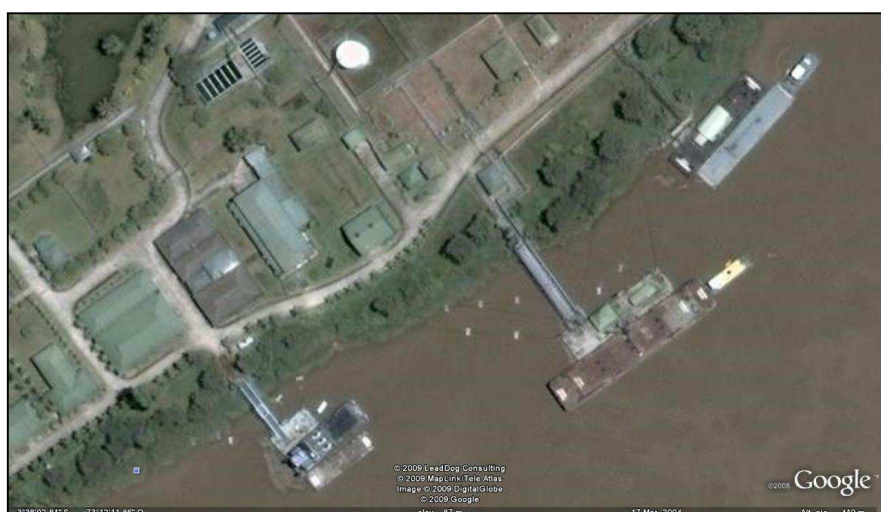
Fig. 2.1 Vista de los Muelles Flotantes en la Refinería.
