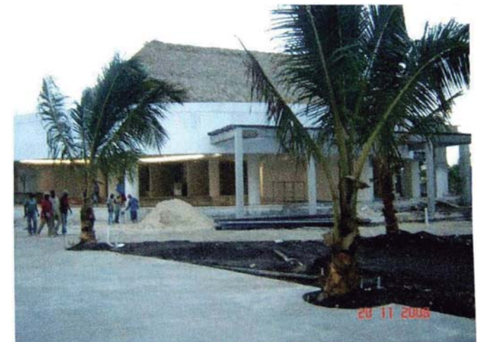
Img 67.- Frontis Sala de Ventas- avance de obra.
