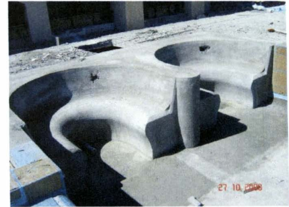
Img. 85 y 86.- proceso Constructivo banca de hidromasajes de la Alberca 3A
