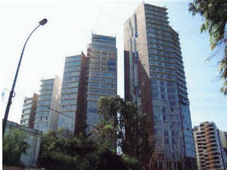
Img. 40.- Fotografía del avance de la obra a nivel peatonal desde la Av. Miroquesada
