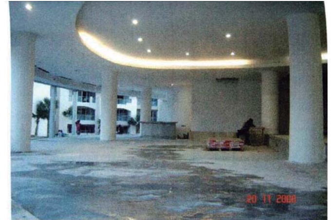
Img. 66.- Vista del Avance de Obra, Nivel Principal Sala de Ventas
