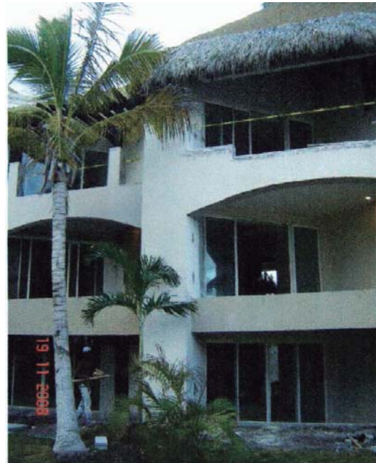
89 Fachada Norte Crujia 1A.
