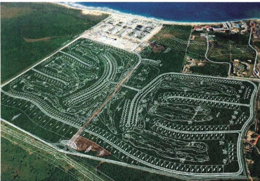
Img. 50.- Vista Área del conjunto en construcción.
