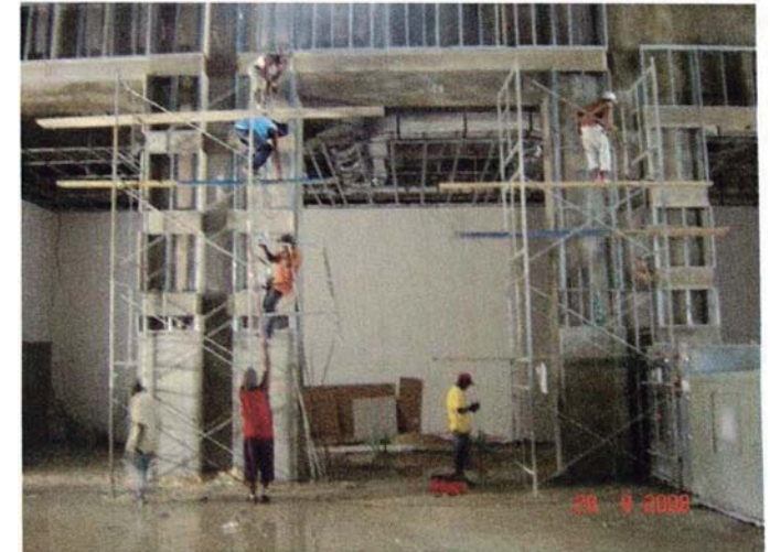
Img. 60.- Proceso constructivo – Lobby de Grupos
