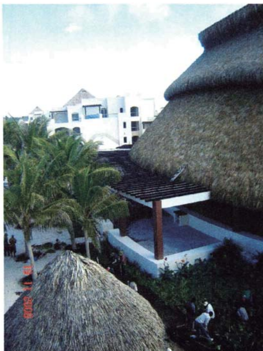
Img. 74.- Fachada Principal El Caribeño.
