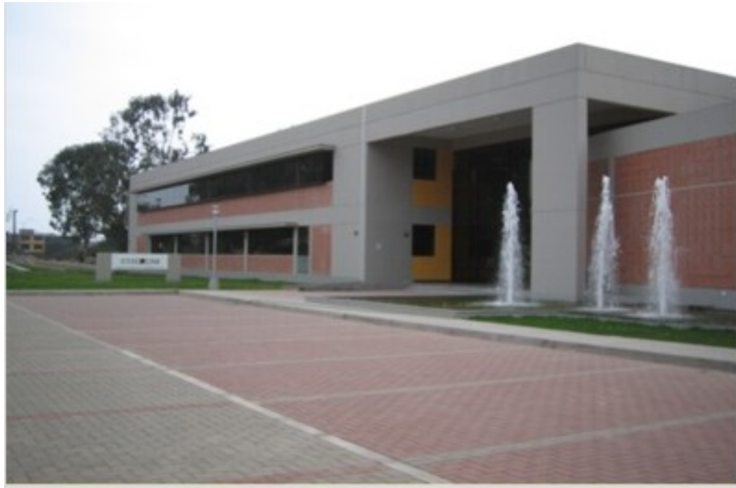
Figura 2.8: Vista del Centro de Tecnologías de la Información y Comunicación CTIC de la UNI, Ubicada entre las facultades de Ciencias y Electrónica
