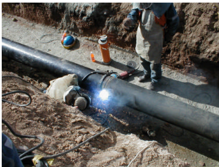
FIGURA 7.3 : SOLDADURA DE TUBERIA
