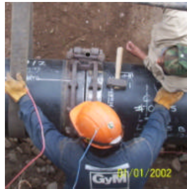
FIGURA 6.2 : ALINEAMIENTO DE TUBERIA CON GRAMPA EXTERNA
