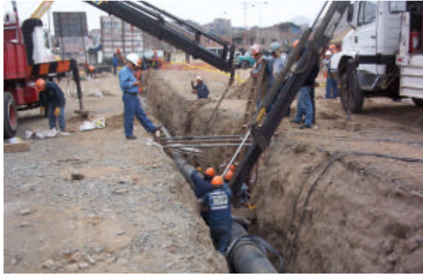
FIGURA 2.6 : TENDIDO DE GASODUCTO TRONCAL
