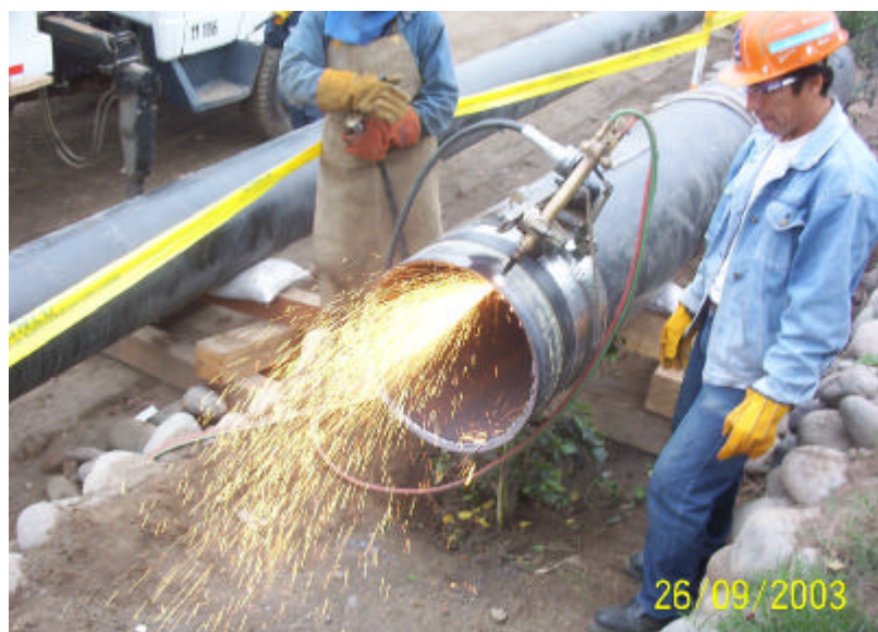
FIGURA 5.40 : CORTE DE TUBERIA CON EQUIPO DE CORTE ORBITAL AUTOMATICO
