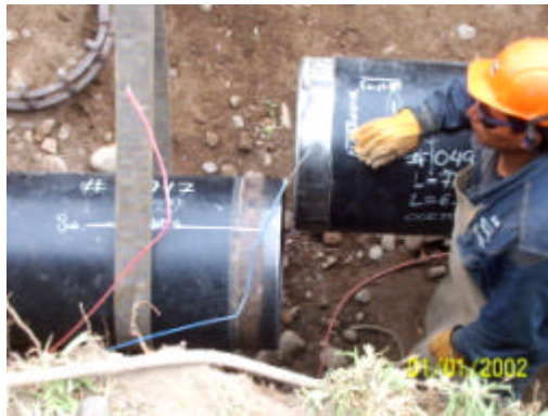
FIGURA 6.2 : ALINEAMIENTO DE TUBERIA CON GRAMPA EXTERNA
