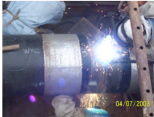
FIGURA 6.3 : INSPECCION DEL PROCESO DE SOLDEO
