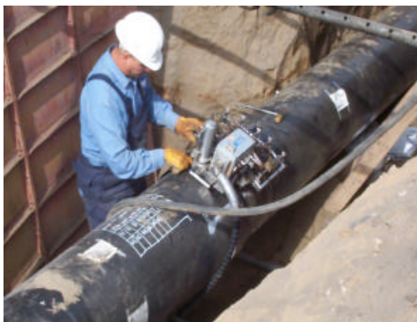
FIGURA 2.7 : INSPECCION DE ULTRASONIDO
