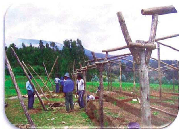
Levantamiento de estructura de invernadero
