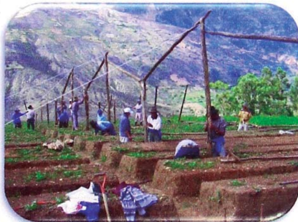
Levantamiento de estructura de invernadero
