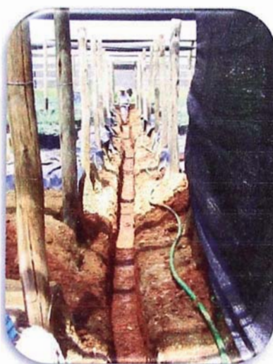
Instalación de tuberías para el sistema de riego por aspersión
