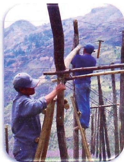
Colocado sistema de alambre como estructura
