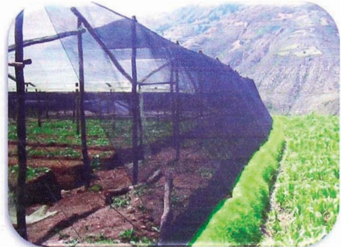
Sistema de malla cortaviento en el perímetro del área
