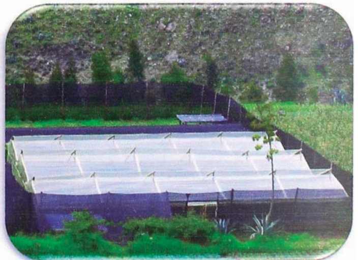
Vista de edificación del invernadero terminado
