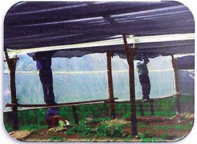
Colocado de malla rashell como cortinas para bajar la temperatura en invernadero
