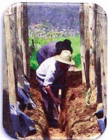
Instalación de tuberías para el sistema de riego por aspersión
