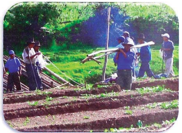
Ubicación de postes para edificar invernadero
