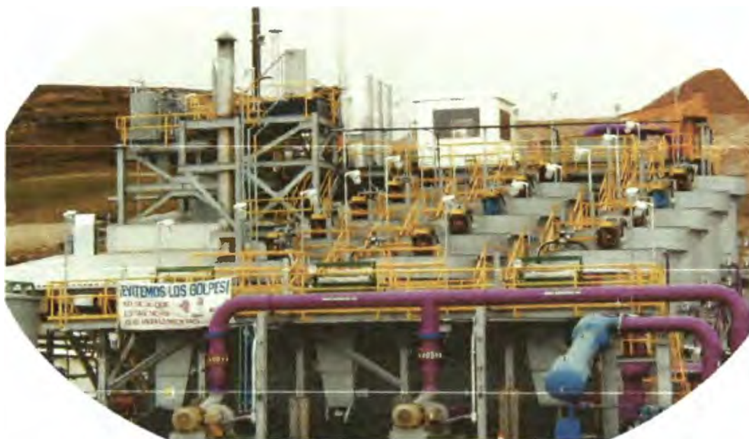
Figura 3.4: Vista de las columnas de carbón de la Planta N° 2
