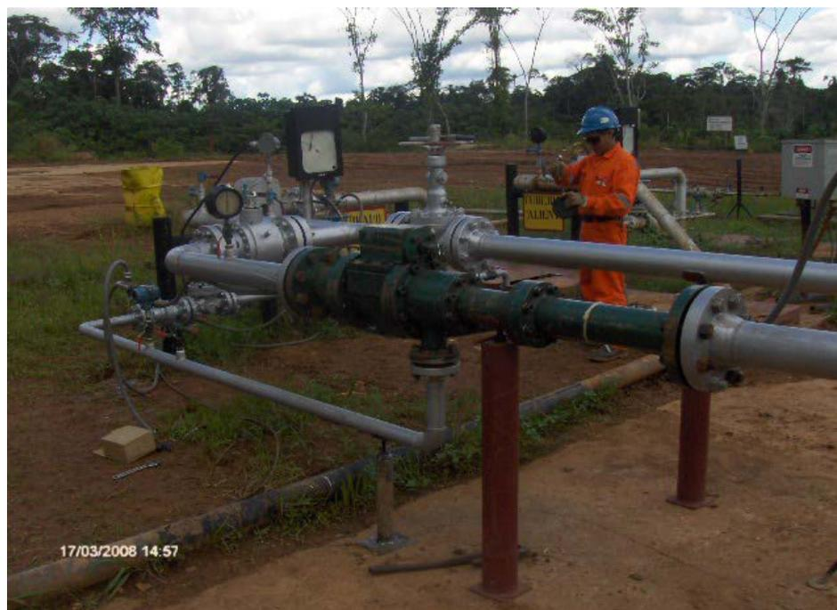
Fotografía del equipo eductor instalado en Pozo SHIV 1603.
