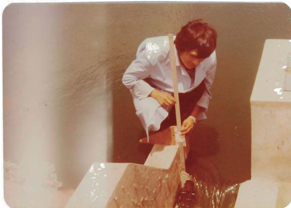
Fig. No. 18' Vertedero Triangular 90^{\circ} y caseta para muestreo en el efluente de la laguna T1.
