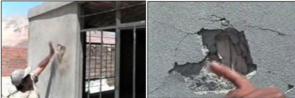
entregados por el Banmat a los damnificados del terremoto del 2,001
