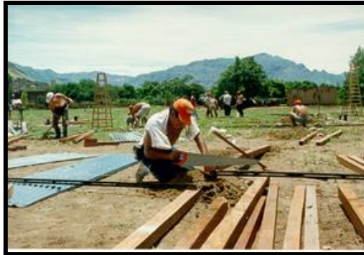
Foto N° 20: Tareas de reconstrucción
