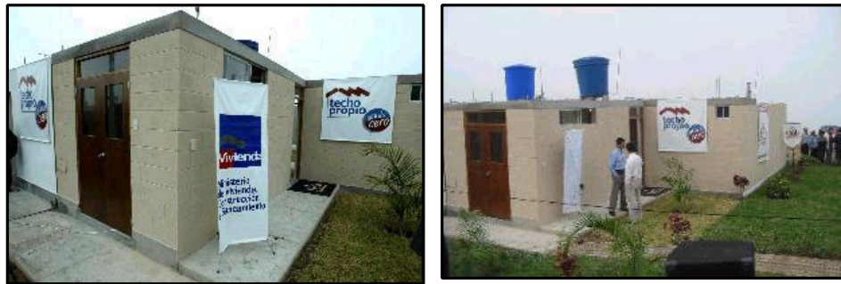
Fotos N° 24 y 25: Proyecto El Mirador - Módulos
