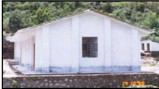
Foto N° 33 : Construcción en base a bloques de concreto
