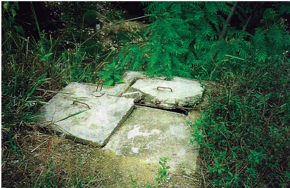
ESTRUCTURA DE CAPTACION ACTUAL DE LA QUEBRADA DE CHALHUAPUQUIO
