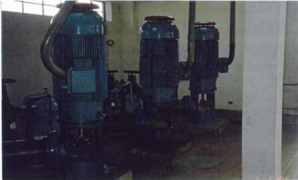
**Figura 4.5.-** muestra el Equipamiento de la Cisterna de Rebombéo CR-1 de 350 m<sup>3</sup> de capacidad. Los equipos que se observan son bombas turbina verticales. Frente a ellas existe un ambiente gemelo donde se instalarán los equipos complementarios. Esta estructura es de un sólo nivel.
