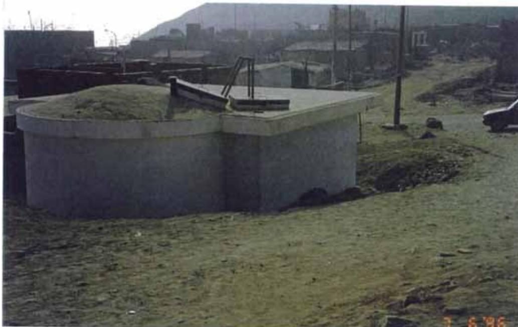
**Figura 4.3.-** muestra el reservorio la cisterna apoyada CB-4 de 50 m<sup>3</sup> de capacidad. Tiene todo el aspecto de las estructuras antes descritas con la diferencia que esta no abastecerá de agua a zona de servicio alguna. La cisterna propiamente ampliará su volumen a 75 m<sup>3</sup>, mientras que los equipos y la caseta se adecuarán para las nuevas condiciones de operación.
