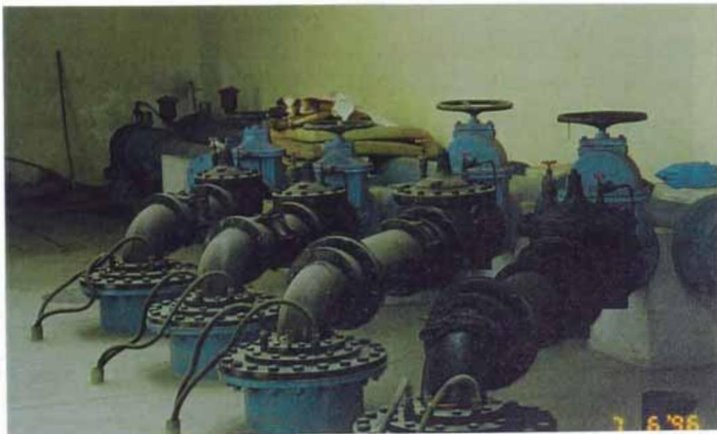
**Figura 4.6-** muestra los ramales de descarga de (04) equipos de bombeo, del tipo vertical sumergible. Las instalaciones que observan se ubican en el segundo nivel de la caseta. Todas ellas descargan a una tubería principal que vuelve a bajar al primer nivel para dirigirse hacia el RC-4. La foto muestra sólo una parte de ese ambiente.
