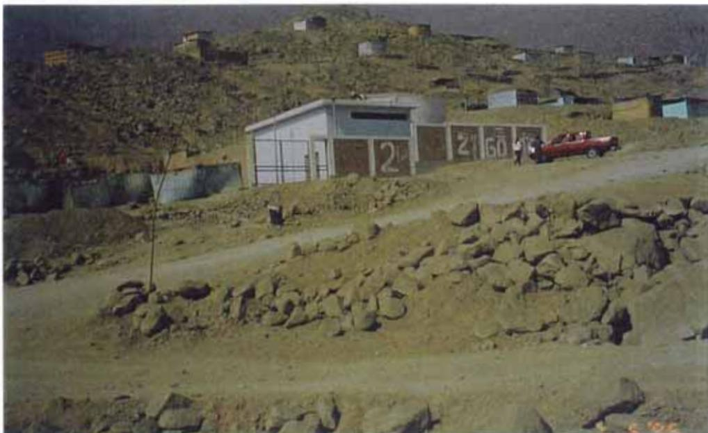
Figura 4.1.- muestra el reservorio apoyado RC-5 de 240 m<sup>3</sup> de capacidad. Inicialmente se visualiza la caseta de bombeo, anexa a ella se ubica el reservorio. Todas estas instalaciones se encuentran protegidas por un cerco perimétrico.
