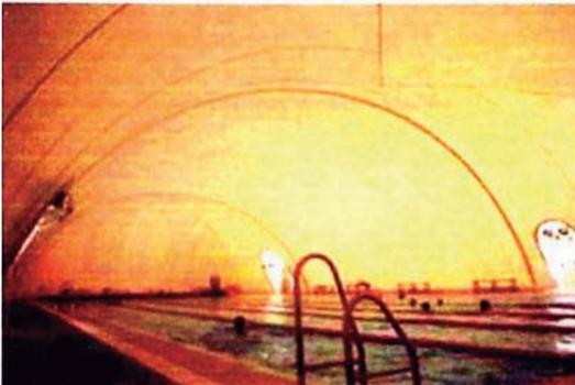
A diferencia de las construcciones tradicionales que descansan sobre sus propios fundamentos, el sistema de anclaje de las cubiertas presostáticas, tiene por función anular la fuerza vertical de tracción debida a lo expuesto anteriormente y a la fuerza de composición por causa de la acción del viento.
