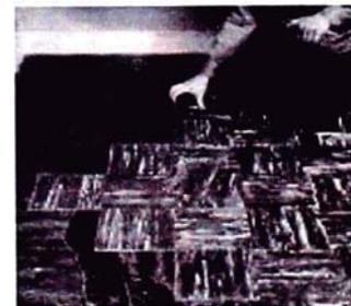
**Fig. 7.14** Para cortar una baldosa, colóquela sobre la baldosa adyacente, y con una tercera baldosa recostada de la pared, usada como regla, efectúe un corte en la segunda baldosa.
