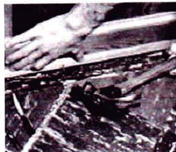
**Fig. 7.15** Quebrar las baldosas es la forma usual de eliminar los sobrantes. Para ello se aprisiona la baldosa entre otras baldosas y se somete a presión fuerte hasta lograr que se quiebre.
