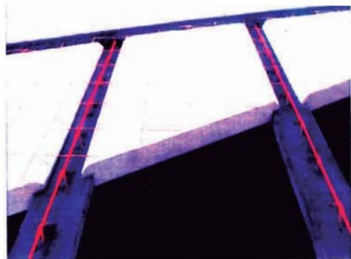
**Fig. 8.9** Bovedilla y caseton de espuma de poliestireno (eps). El casetón de EPS sustituye a los pesados materiales aligerantes usados en sistemas reticulares, proporcionando una verdadera ligereza a la estructura y añadiendo aislamiento térmico y acústico, importantes objetivos concebidos en toda construcción.
