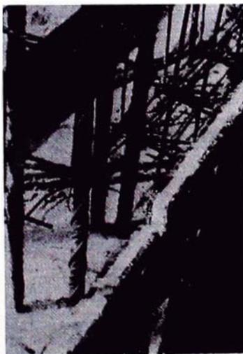
Fig. 8.3 Encofrado con placas de tekpor revestido en ambas caras con virutas de madera.
