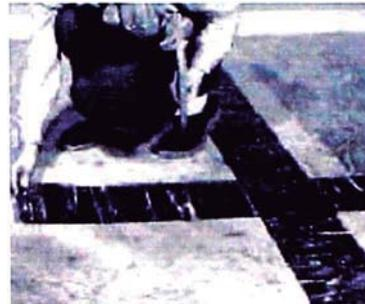
**Fig. 7.12** El suelo base para las losetas debe ser liso y firme. Cualquier irregularidad se verá a través de las losetas, las cuales no se sostienen si la base es de tablas que se mueven. Si esta colocando las losetas sobre un piso de concreto, este no deberá tener pintura. El concreto requiere un tipo especial de adhesivo. Todas las grietas deben ser rellenadas con relleno que endurece al fraguar.
