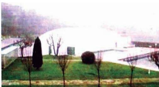
Especialmente para la cubrición de piscinas se ha desarrollado la cubierta presostática cohibentada, la cual se basa en un concepto absolutamente revolucionario: el manto de cobertura está constituido por dos membranas separadas entre si por una cámara de aire.
