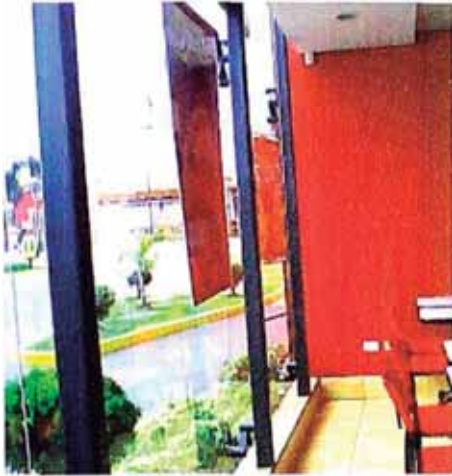
Vista interior del lobby. Se observa la estructura metálica de las mamparas de vidrio.
