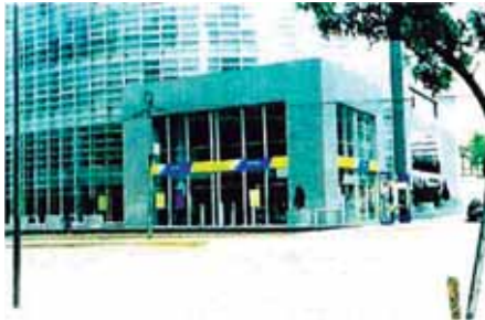
Edificio de Telefónica ubicado en la Av. Benavides. La entrada principal se muestra de manera diferente con respecto al edificio, en cuanto a volumen, materiales, texturas, etc. Esto indica un indicio intencional de parte del diseñador para dar importancia a la entrada al edificio.
