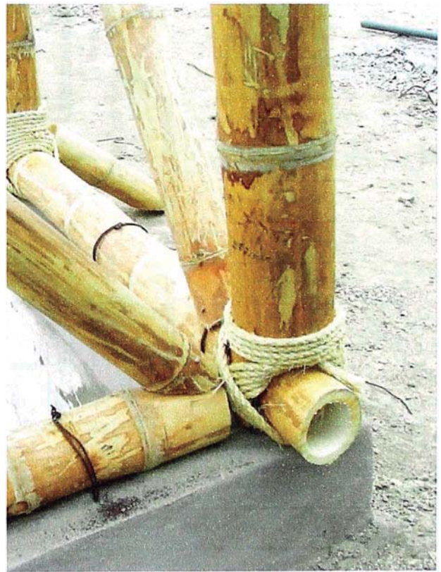
Detalles constructivos del techo de bambú
