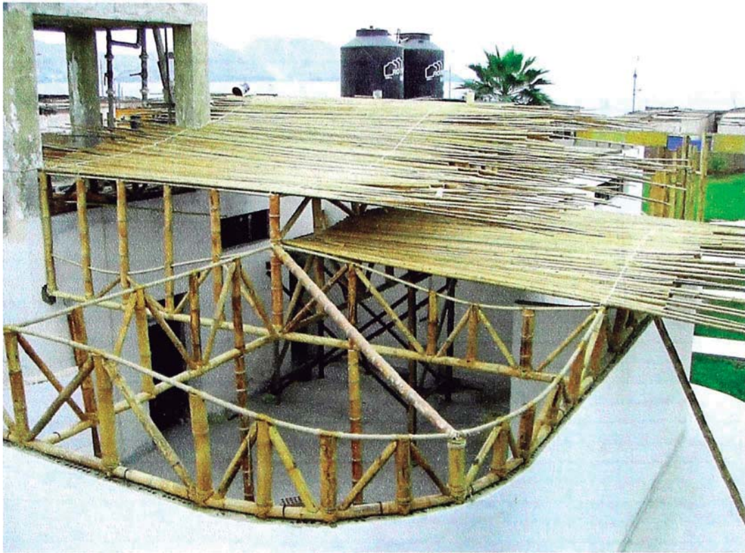
Vista exterior e interior de los primeros elementos de bambú horizontales. Colocando intercalados debido a que el bambú se va adelgazando y evitar la menos cantidad de vacios posibles entre el bambú.
