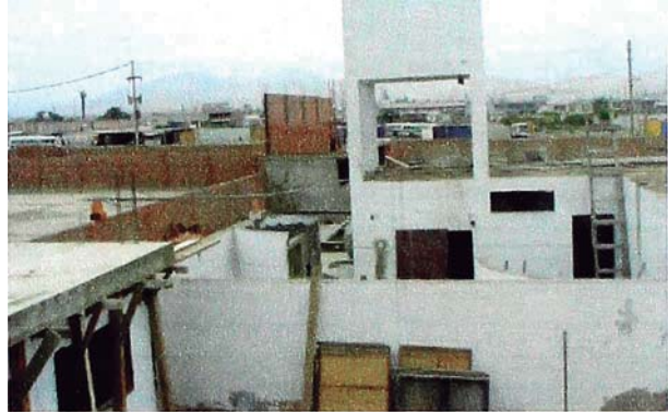
Vistas anteriores a la colocación del techo de bambú
