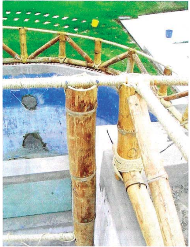
Detalles constructivos del techo de bambú
