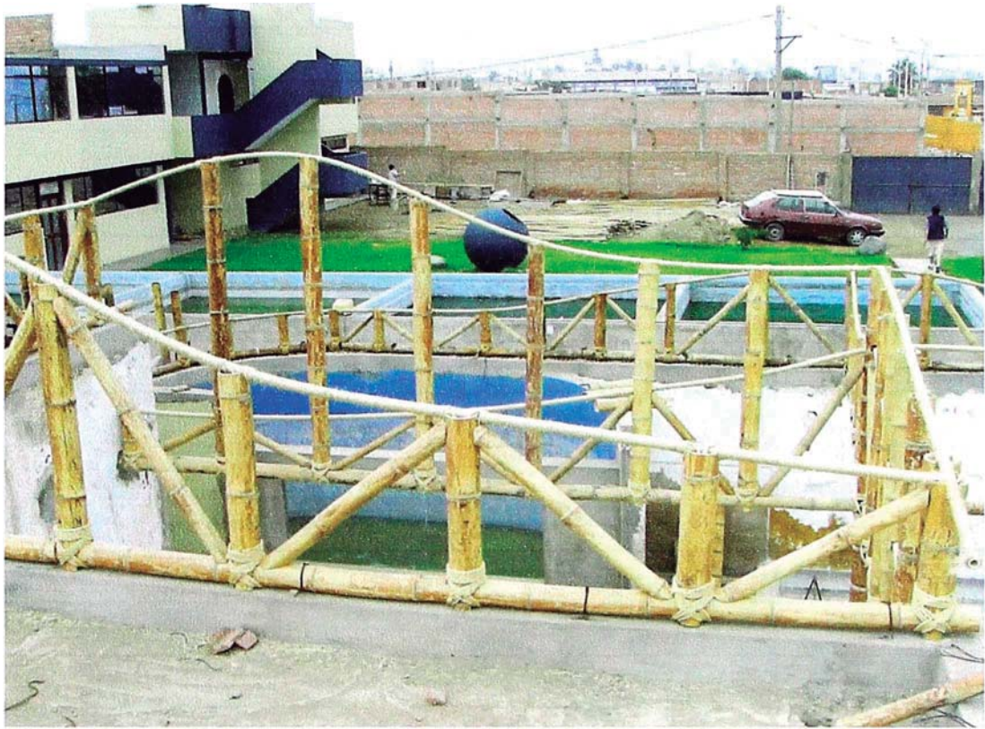
Vista de la colocación de los tubos dándole las formas curvas para la colocación del techo. Abajo el esqueleto de un techo superior con los tubos ya colocados.
