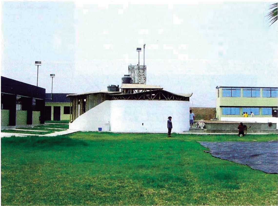
Vistas exteriores mostrando el techo de bambú. observando el entorno, lo cual hace ver el volumen desde todos sus lados.
