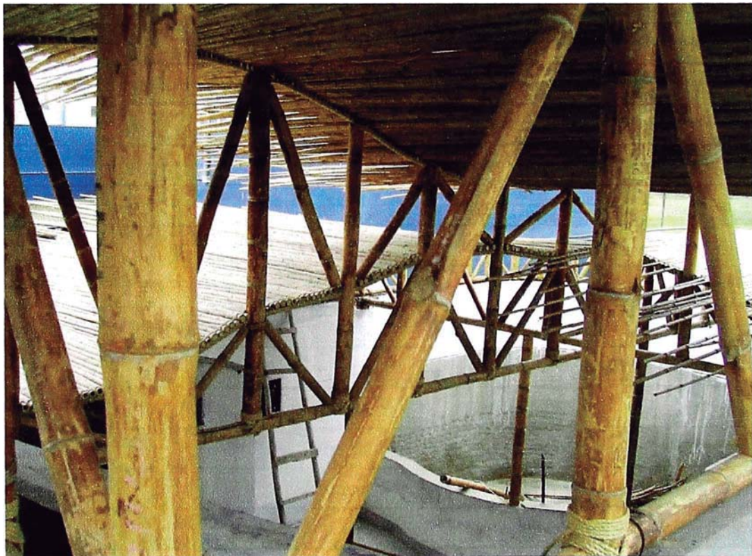
Vista exterior e interior de los primeros elementos de bambú horizontales. Colocando intercalados debido a que el bambú se va adelgazando y evitar la menos cantidad de vacios posibles entre el bambú.
