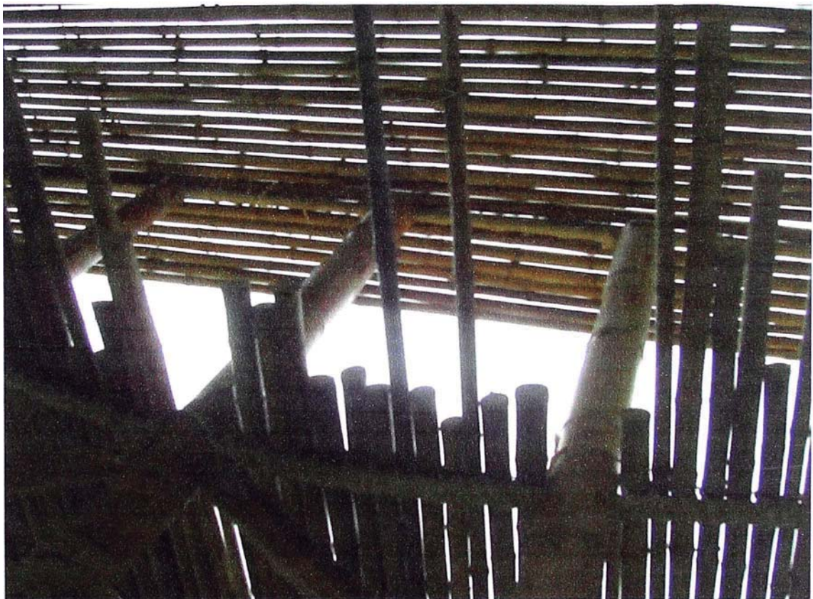
Vista interior y exterior mostrando el bambú dejando sin cortar para darle la forma al final de toda la colocación
