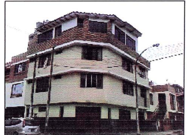
Casa Manco Cápac
