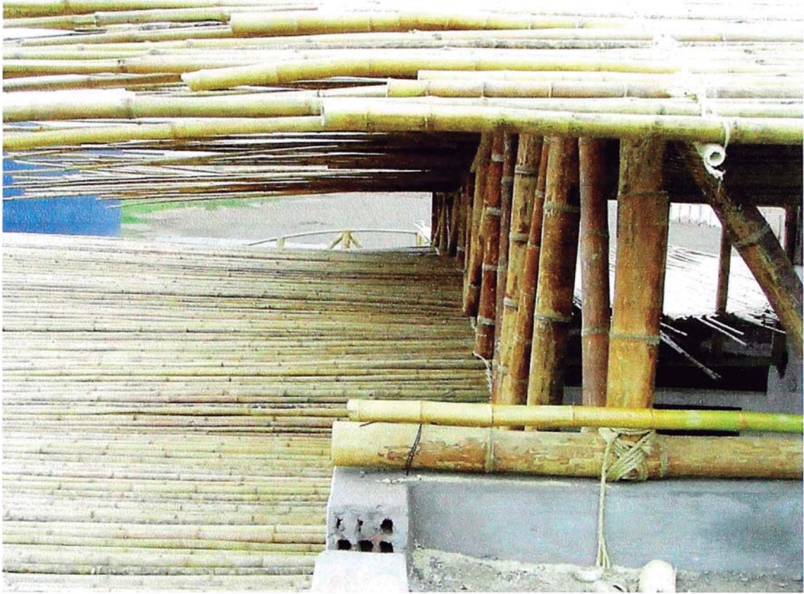
Vista interior y exterior mostrando el bambú dejando sin cortar para darle la forma al final de toda la colocación
