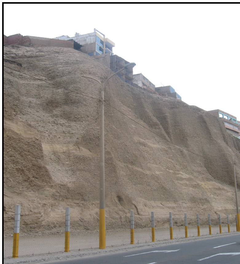
Foto N° 1: Vista de un talud de los acantilados de la Costa Verde (San Miguel), donde se aprecia que está compuesto por material gravoso, intercalado con finos, además se pueden observar las construcciones aledañas al talud.
