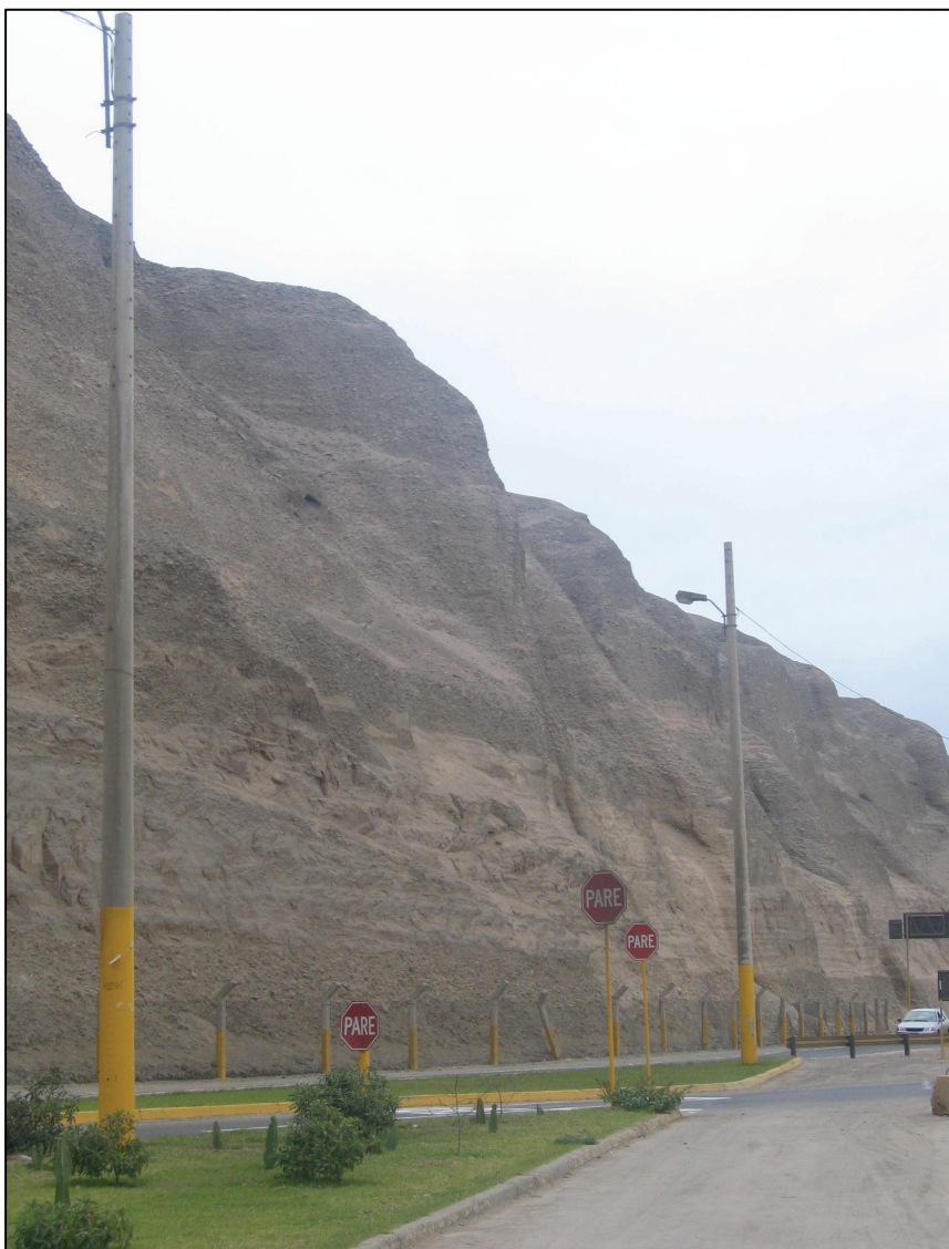
Foto N° 5: Vista panorámica de los taludes que corresponden a la Sección III (distrito de Magdalena del Mar), como se puede apreciar el talud está compuesto por grava, en la parte intermedia se observa un estrato de material fino.
