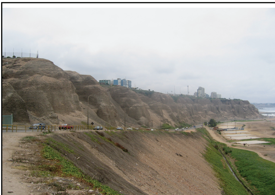
Foto N° 2: Vista panorámica de los taludes ubicados en el distrito de Miraflores.
