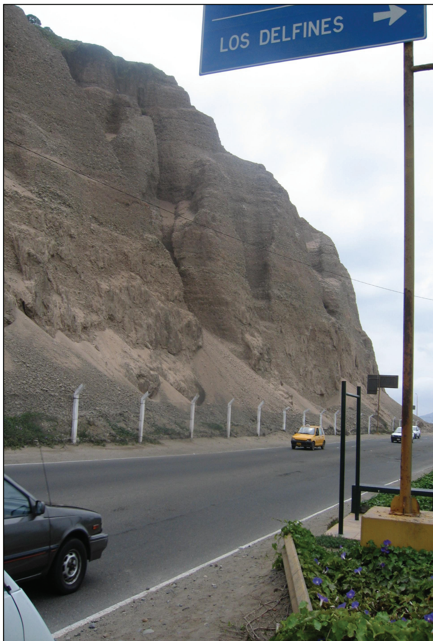
Foto N° 6: Vista panorámica de los taludes que corresponden a la Sección IV (distrito de Miraflores), como se puede apreciar el talud está compuesto en su mayoría por gravas.
