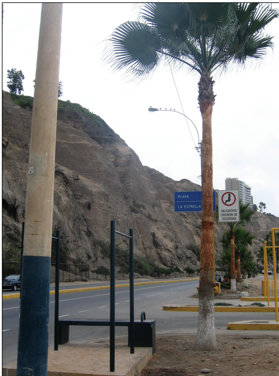
Foto N° 7: Vista panorámica de los taludes que corresponden a la Sección V (distrito de Miraflores), como se puede apreciar el talud está compuesto en su mayoría por gravas. Se observa también la presencia de cárcavas.
