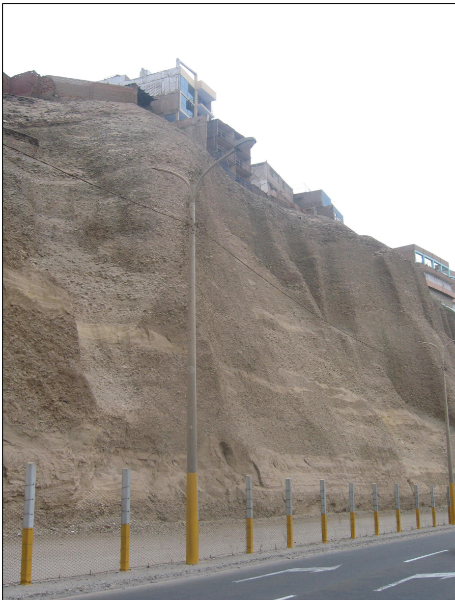
Foto N° 4: Vista panorámica de los taludes que corresponden a la Sección II (distrito de San Miguel), como se puede apreciar el talud está compuesto por grava, intercalado con material fino.
