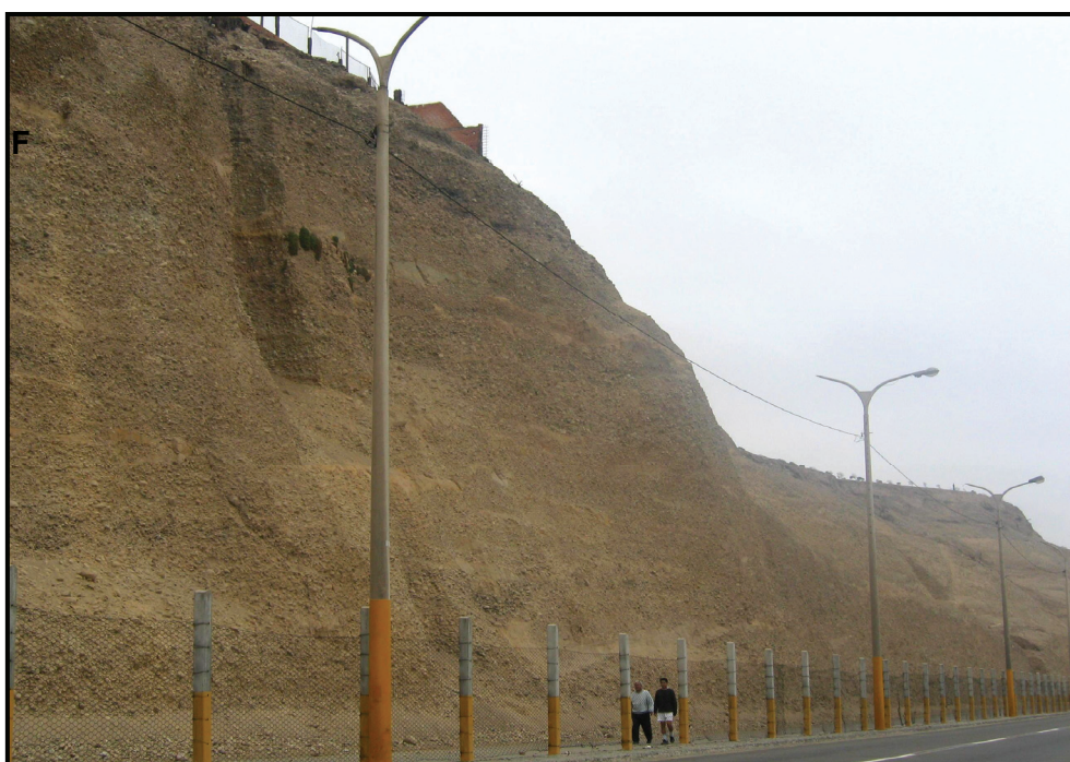
Foto N° 3: Vista panorámica de los taludes que corresponden a la Sección I (distrito de San Miguel), como se puede apreciar el talud está compuesto por grava, intercalada con material fino.
