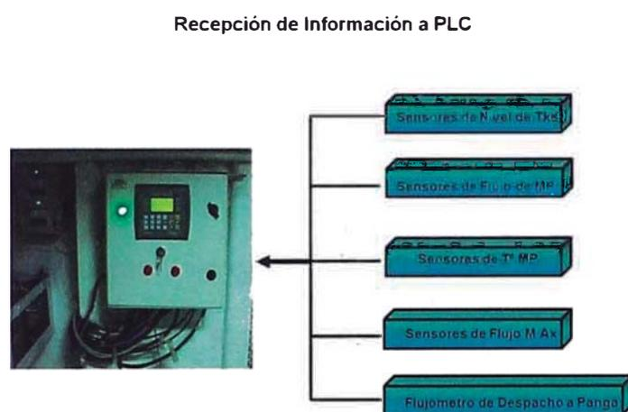
Ilustración 3.20: PLC (Controlador lógico programable) instalado en la sala de máquinas.
