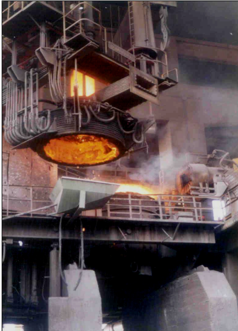
Fig.7.- Horno Cuchara, 40t de capacidad de acero líquido, transformador de 25MVA de potencia
