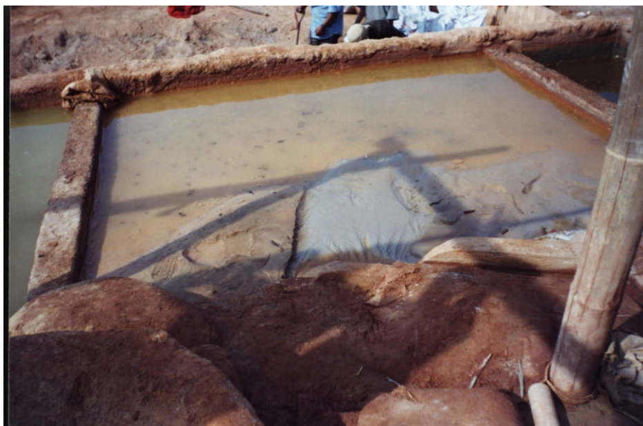
Fotografía N°A3: Poza de Relaves Artesanales
