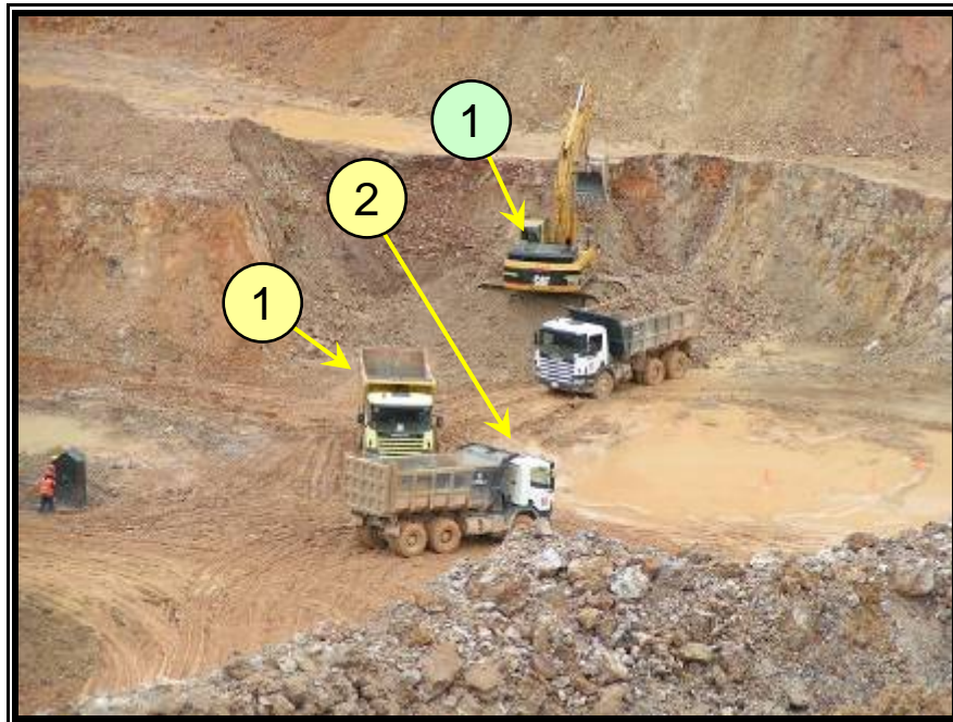
Foto 1.1.1d 01 punto de carga y una cola de 02 camiones en espera.
