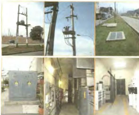
Figura N°2.4. Subestaciones de Distribución MT/BT
