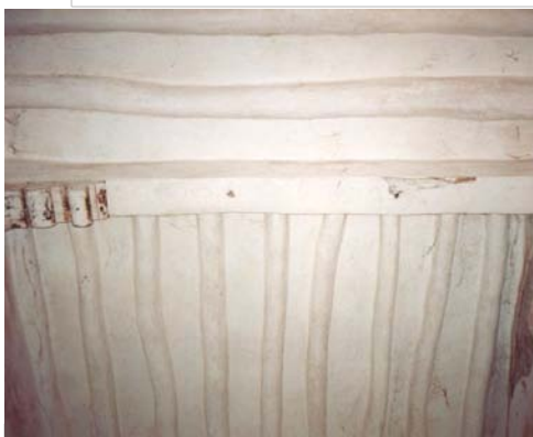
Techo de viguetas de algarrobo en rollizo con viga de algarrobo canteada. Ambientes del segundo nivel en el segundo patio.
