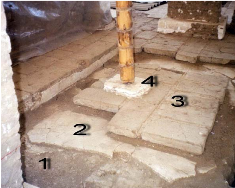
(1) Piso de tierra apisonada original (2)Piso antiguo de cal (3)Piso antiguo de adobe (4)Piso reciente de yeso de Mórrope. Foto: World Monuments Fund. 2007. Annual Report
