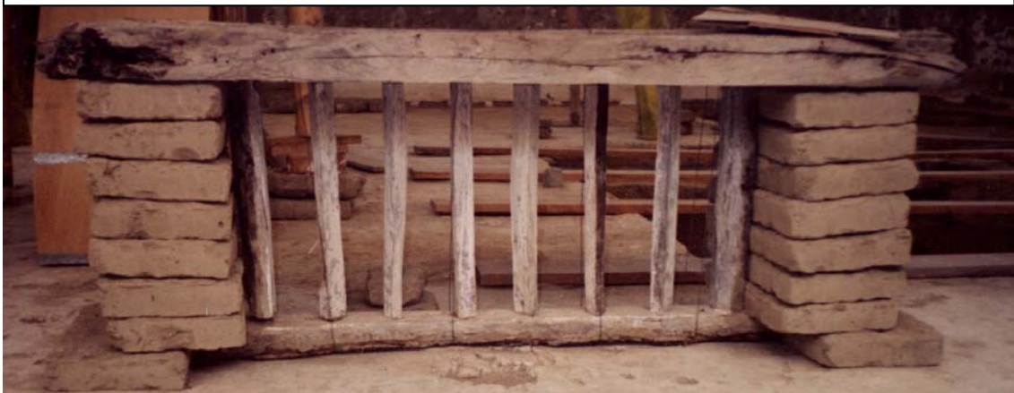
También se usó el algarrobo para la carpintería de los vanos, igualmente muy rústica, de algarrobo canteado con hachuela, casi rollizo, empotrada en dintel y cuartón inferior, con función de reja. Fuente: World Monuments Fund. 2007. Annual Report.
