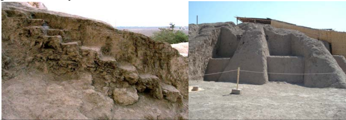
Obsérvense la utilización de las champas de tierra en los diferentes componentes: muros, escalera, contrafuertes. Fotos tomadas por los autores.
