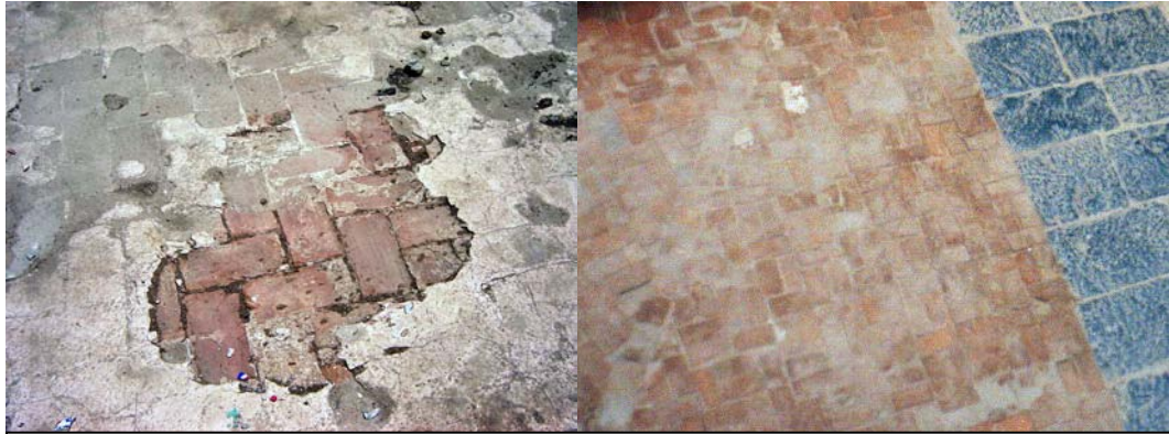
Piso de ladrillo con capa de cal – se usaba poco pero su blancura y pulimento eran señal de lujo y poder - en Casona de Lambayeque. A la derecha pisos de ladrillo y piedra canteada en aparejo ortogonal de la Casona Montjoy en Lambayeque. Fotos de los autores.
