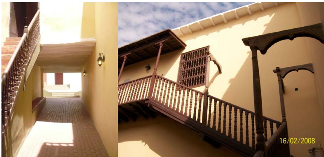
Izq. Corredor hacia el segundo patio, con cubierta de vigas rollizas de algarrobo. Der. Escalera hacia el segundo piso, labrada en madera.
