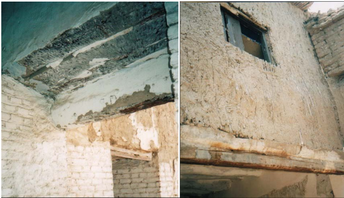
Izq. Dintel de algarrobo en vano de puerta. Der, Muro de quincha en el segundo nivel del
