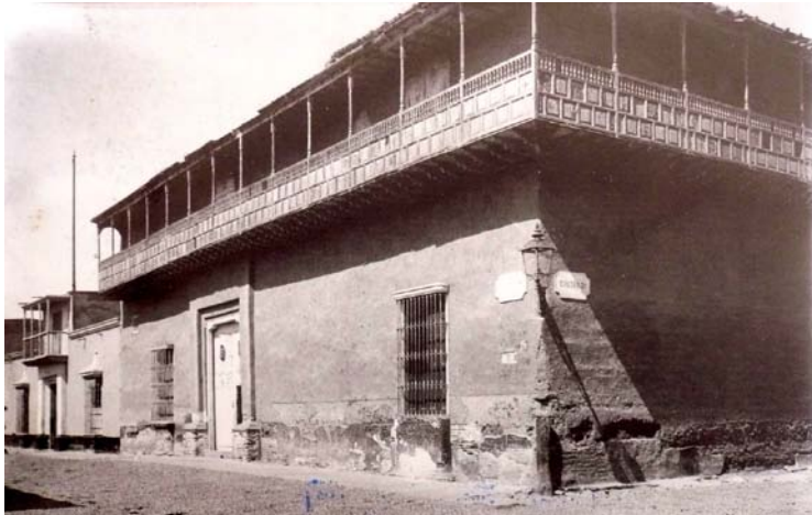
Vista fotográfica de H. Bruning año 1914, donde la casona ostenta otro color en la fachada . Abajo, vista antes de la restauración actual.
