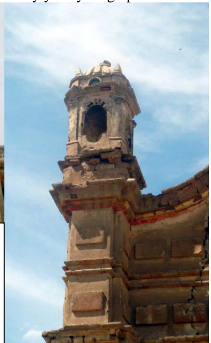
Detalle de la parte superior de la portada, con sus volutas características y de una torrecilla de remate lateral superior. En cada caso los ladrillos se fabricaron de diferente tamaño, diferente espesor y diferente borde, de acuerdo al lugar donde se colocaría. Las cuidadas proporciones y el fino trabajo de albañilería hacen de esta portada-fachada un modelo que resume la técnica constructiva y el estilo arquitectónico. Fotos de los autores.
