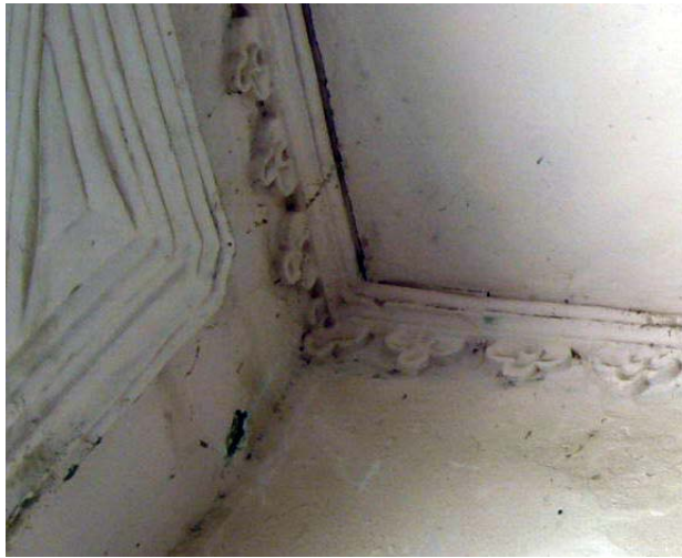
Molduras Geométricas (en el muro de la izquierda) y florales (como cenefa en unión muro techo) de yeso en el zaguán de la Casa Cúneo que está a punto de perderse en Lambayeque. Fotografía de los autores. Año 2010
