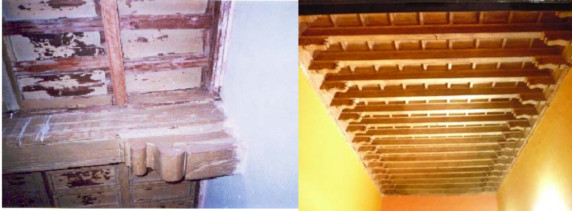
Estructura de vigas labradas apoyadas en ménsulas , recibiendo cuarterones y entablado. Posiblemente luego se colocó un tejido de caña y torta de barro.
