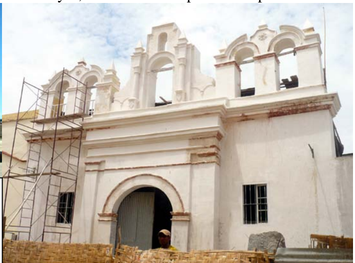
Fachada de la Ramada San Francisco La portada y las molduras y relieves fueron hechos de ladrillo. Actualmente se está terminando su restauración (foto de la derecha).
