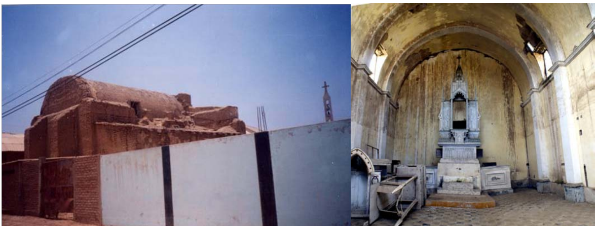
Vista del Sector Altar-presbiterio, único que ha sobrevivido el tiempo, nótese los contrafuertes posteriores y la bóveda de cañón. A la derecha vista interior del mismo sector. Fotos de los autores.
