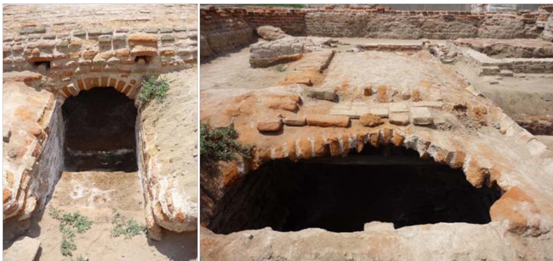
Vista de accesos y techos de pasajes y compartimientos de las criptas. Nótese la presencia de vigas de algarrobo. Fotos de los autores
