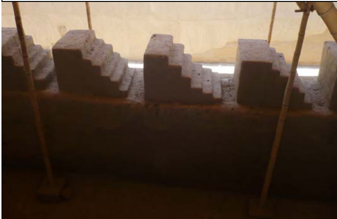
Planta Hipotética de Huaca Las Ventanas. Fotos: muro de sector jerárquico con ornamentación escalonada en adobe y cámaras rellenas pequeñas en plataformas inferiores perimetrales de la huaca. Fuente: Shimada, 1985. Fotos tomadas por los autores
