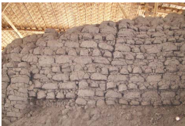
Sector en Huaca Norte: adobes plano-convexos en bloques o paneles modulares macizos. Foto tomada por los autores
