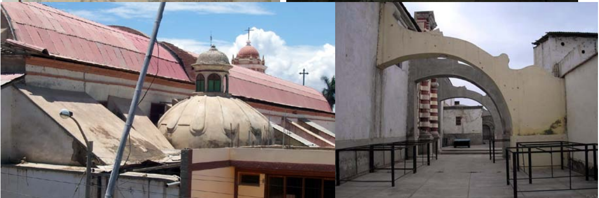
Vista de los contrafuertes y los arbotantes de refuerzo. Foto de los autores
