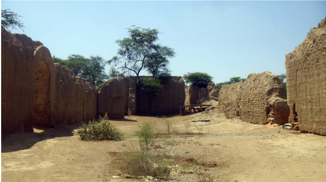
Vista del Interior desde el Ingreso principal hacia el presbiterio (sur), Notese que una de las portadas laterales (Oeste), ha caído y solo queda el arranque de los pilares de ladrillo a ambos lados del vano. No hay huellas de piso reconocible. Foto de los autores
