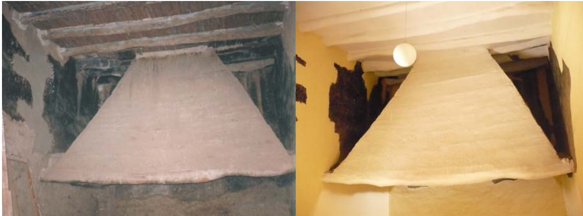
Vistas fotográficas de la campana para evacuación de humos de la cocina, antes y después de la restauración.. Elaborada en quincha, al igual que el techo, sus estructuras de troncos de algarrobo se empotran en las paredes de adobe. El ducto final en el techo remata en una teatina.
