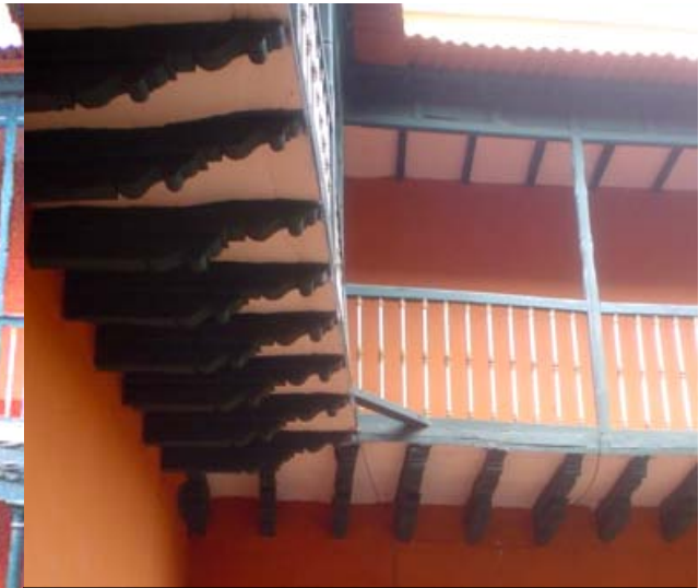
Vista fotográfica y dibujo de elevación de las galerías del primer y segundo nivel. Detalle de los canes labrados en madera.
