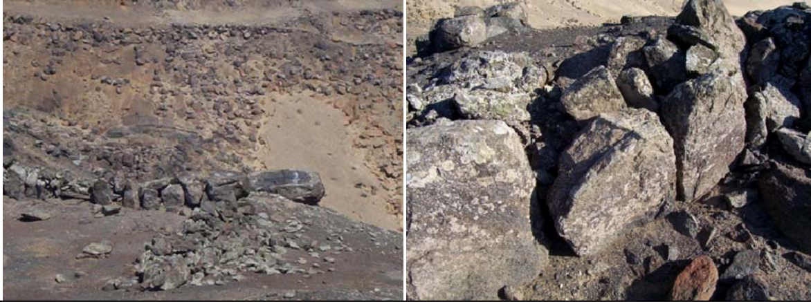
Obsérvese la técnica constructiva: ortostatos con pachillas y relleno de gravilla. Fotos tomadas por los autores.
