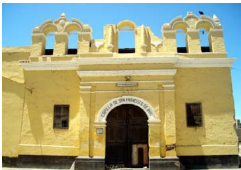
Fachada de la Ramada San Francisco La portada y las molduras y relieves fueron hechos de ladrillo. Actualmente se está terminando su restauración (foto de la derecha).
