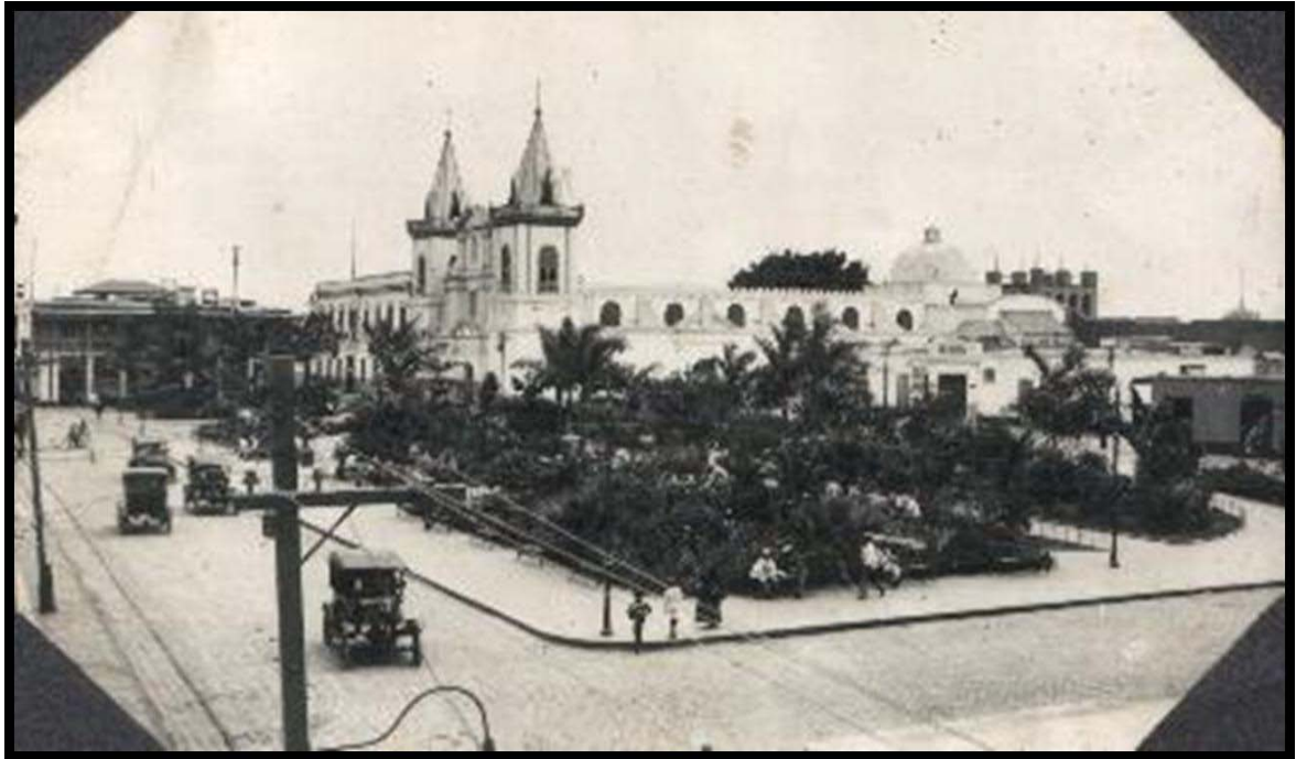
Vista antigua de la volumetría de la Iglesia Matriz de Chiclayo. Se observa la composición basilical de tres naves (que a la vez constituye el sistema estructural de apoyo y transmisión de cargas), transepto y crucero sobreelevado con remate de cúpula. Es posible también identificar la presencia de contrafuertes que contribuyen al apoyo de la nave principal central que es más alta.
