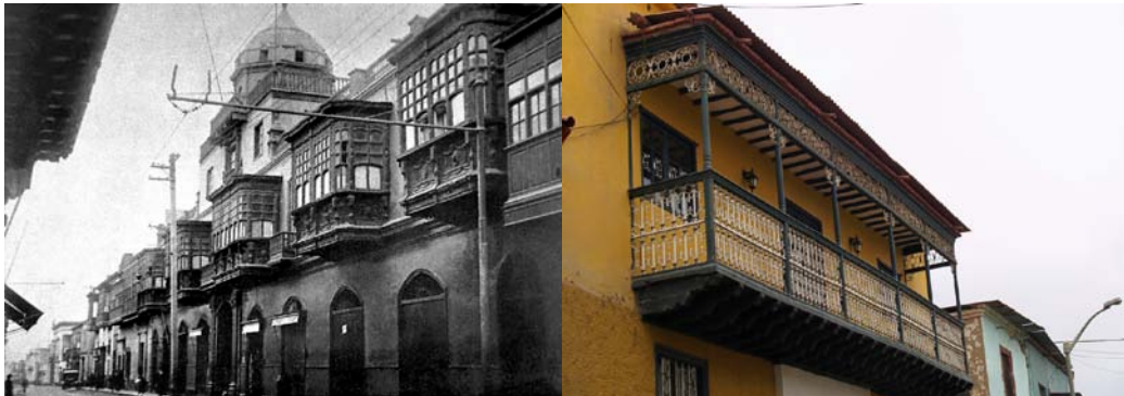
Balcones virreinales emblemáticos: De Cajón o cerrado, en la Casa Osambela en Lima en antigua foto de comienzos del siglo XX a la izquierda; Abierto o Llano en la Casa Descalzi en Lambayeque a la derecha. Foto de los autores.
