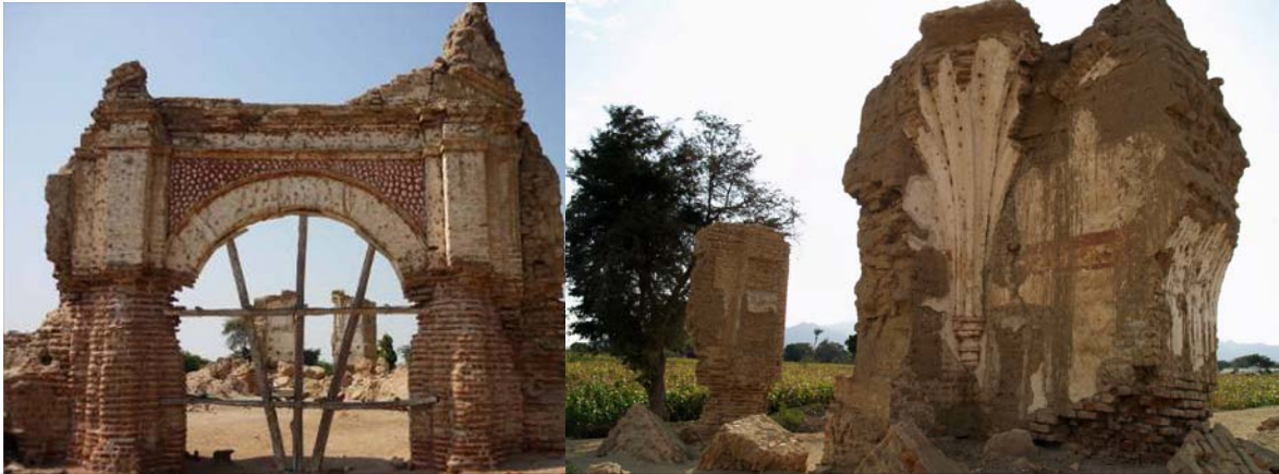
Vista del arco de la portada de ingreso y a la derecha esquina de nacimiento de arquerías y de una bóveda de crucería, nótese las nervaduras en forma de abanico que forman luego las diagonales y ornamentos de la bóveda. Foto de los autores
