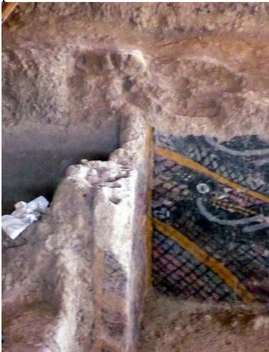
Muro con pintura mural. Estructurado con troncos de algarrobo. Es posible notar las improntas en la parte superior del muro. A la derecha, zócalo como ornamento y refuerzo de pilares de algarrobo. Fotos tomadas por los autores.
