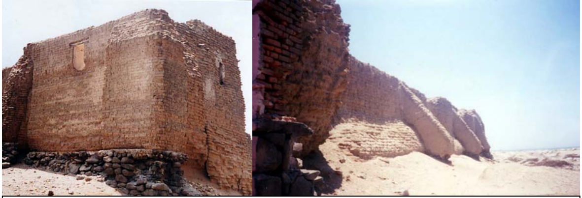
Vistas exteriores del lado derecho de la nave. Izq. Se observa la conformación de los muros posteriores del templo: bases de piedra grande y muros de adobe. Der. Se aprecian los contrafuertes de dos tipos: los típicos de conformación unitaria colocados cada cierto tramo a lo largo de la nave, y, el refuerzo corrido en la parte baja de los muros, con sección de un cuarto de caña. Ambos de adobe.
