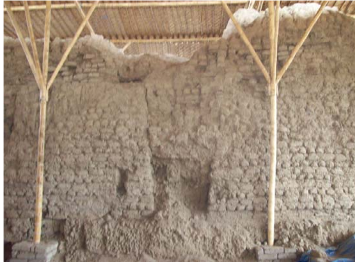
Bloques de adobes con juntas inclinadas. Huaca Norte. Foto tomada por los autores.
