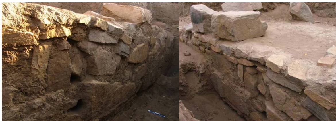
Zarpán-Sector 3: piedra y barro. Nótese la utilización de lascas de piedra de los cerros de la zona donde hay abundancia de calizas fáciles de extraer con forma de lascas. Estas piedras son de dureza media, sin embargo para los efectos constructivos son muy trabajables y de resistencia suficiente.
