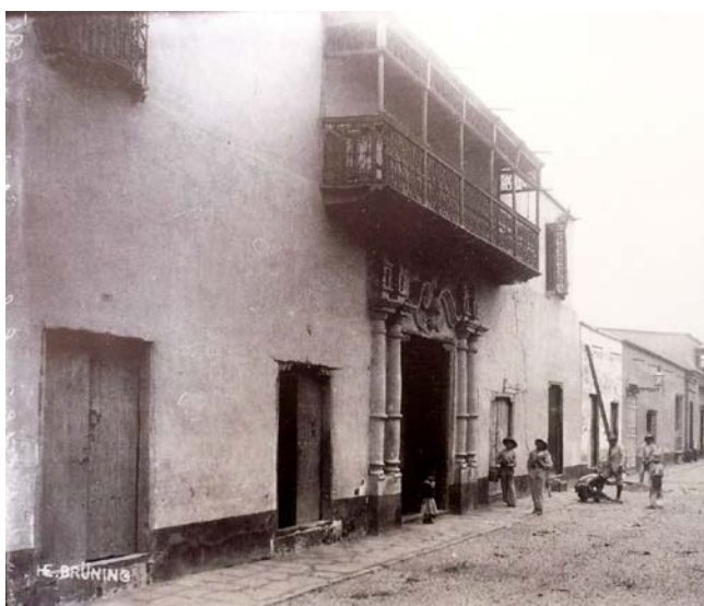
Foto de H.H.Bruning del año 1916, donde la casona Cúneo aún cuneta con el balcón completo, se aprecia el antepecho de hierro forjado y la estructuración con columnas, apoyo y cubierta de madera. Der. Vista actual de la casona, en muy mal estado de conservación.
