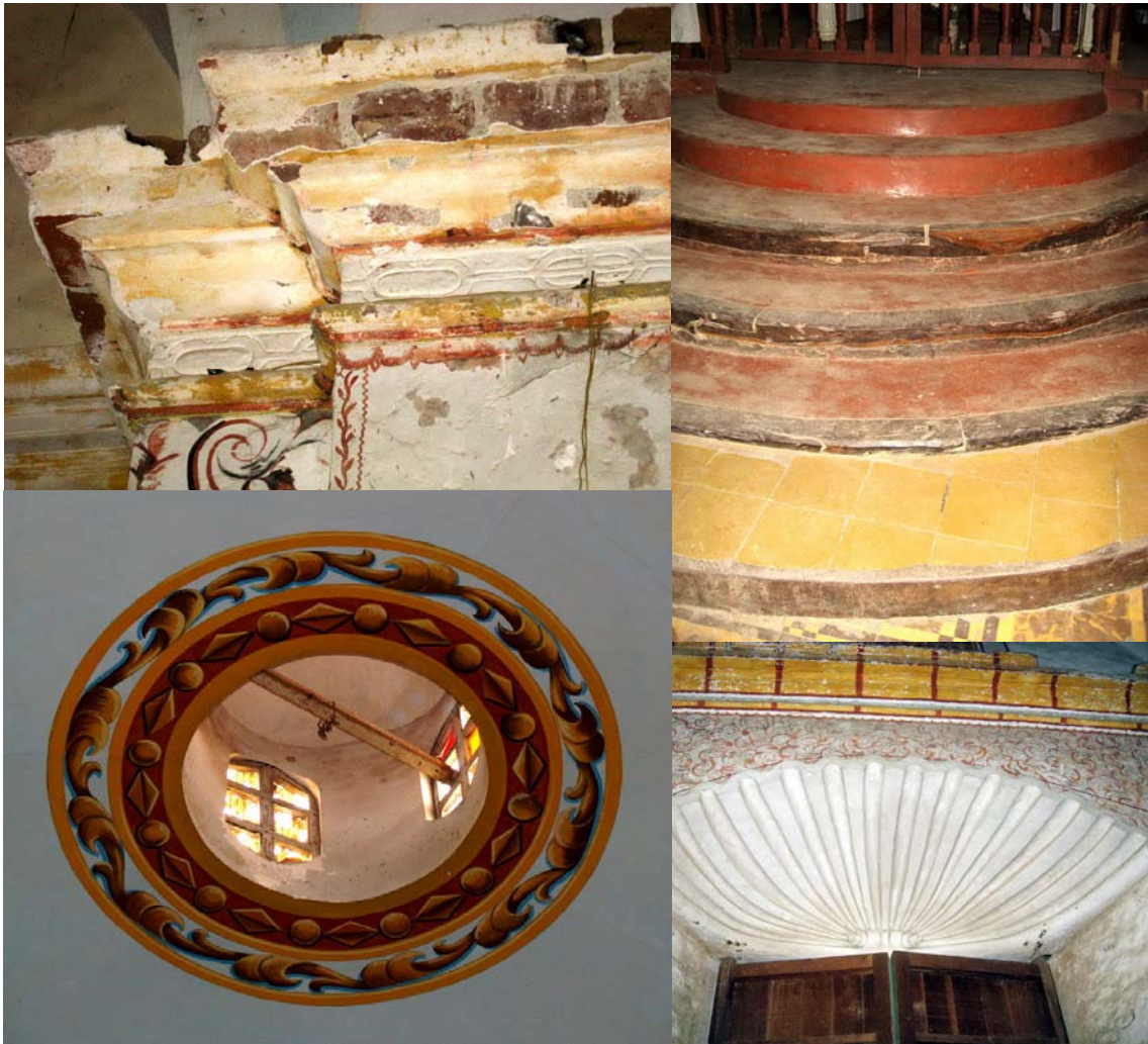
Arriba, a la izq. Molduras de yeso y ladrillos especiales en remates de pilarea y muros interiores, sobre el enlucido pintura mural de gran factura y cromatismo. Arriba a la der. Escalera al altar mayor con reminiscencias piramidales (ver capilla doctrinal adyacente) Abajo a la izq. Óculo y linterna en techo del crucero, Abajo a la der. Moldura de yeso en forma de venera o concha sobre uno de los accesos a la iglesia mas pintura mural sobre un enlucido de cal y yeso. Fotos de los autores
