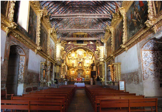
Sistema constructivo de techo de par y nudillo, En este caso muy ornamentado. Interior de la Iglesia de San Pedro de Andahuaylillas en Cuzco.
