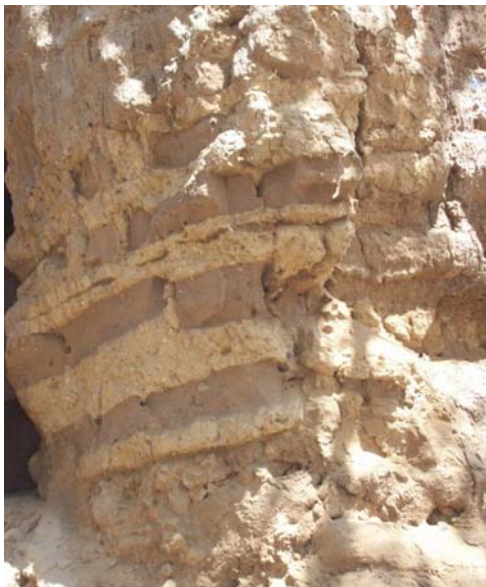
Huaca El Oro, muro construido con adobes y mortero de gran espesor. Foto por los autores.
