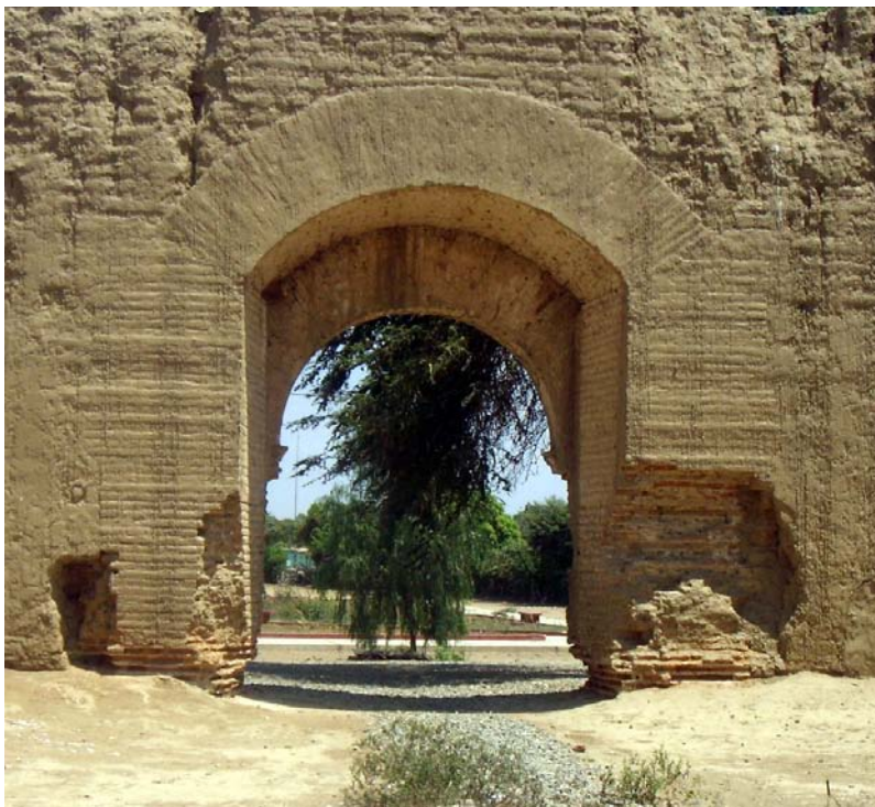
Vista del Interior desde el Ingreso principal hacia el presbiterio (sur), Notese que una de las portadas laterales (Oeste), ha caído y solo queda el arranque de los pilares de ladrillo a ambos lados del vano. No hay huellas de piso reconocible. Foto de los autores
