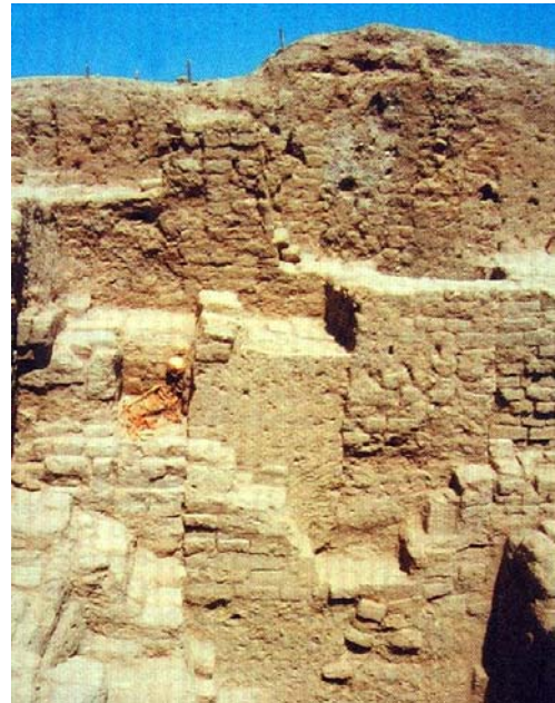
Paneles modulares claramente mostrados en las pirámides de Sipán. Fuente Museo de Sipán
