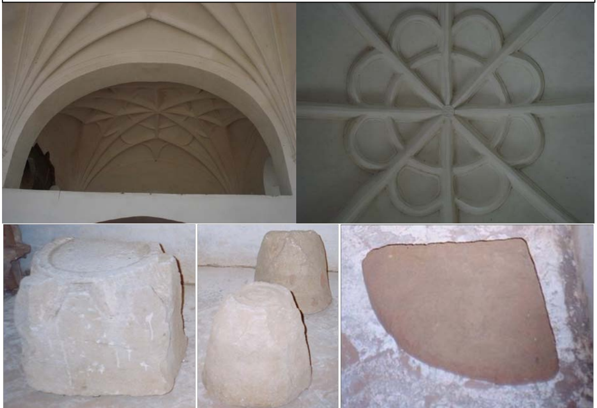
Ladrillos para Centro de Bóvedas llamados "llaves" hechos específicamente para cada luz, peralte y curva de bóveda. A la derecha ladrillo ornamental curvo, para pilastras.
