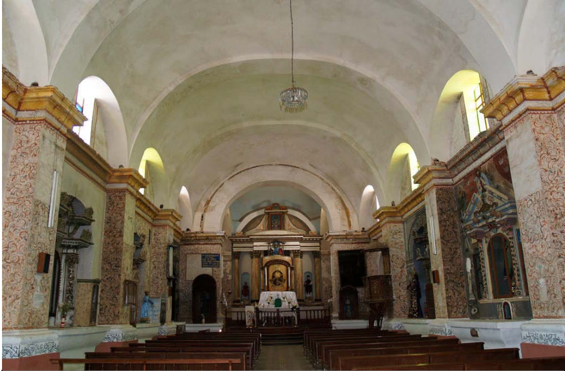
Arriba, vista del interior de la Iglesia de Mórrope desde el ingreso principal; Nótese la nave única con gruesos muros de adobe y retablos empotrados en ellos, los pilares, la arquería y las bóvedas vaídas o de doble curvatura son de ladrillo. Abajo vista del ingreso principal y sobre este, el coro. Toda la Iglesia, salvo los techos están profusamente decorados con pintura mural sobre un enlucido de cal y yeso. Fotos de los autores 2010
