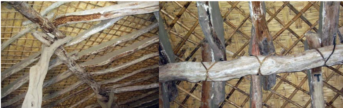
El algarrobo se usó en columnas de horcón, vigas madres y vigas secundarias, en madera rolliza, al natural, sobre el techo un entramado diagonal cuadrado de cañas amarradas, sobre el que se colocaba esteras y luego la consabida torta de barro. Fuente: WMF 2007. Annual Report.
