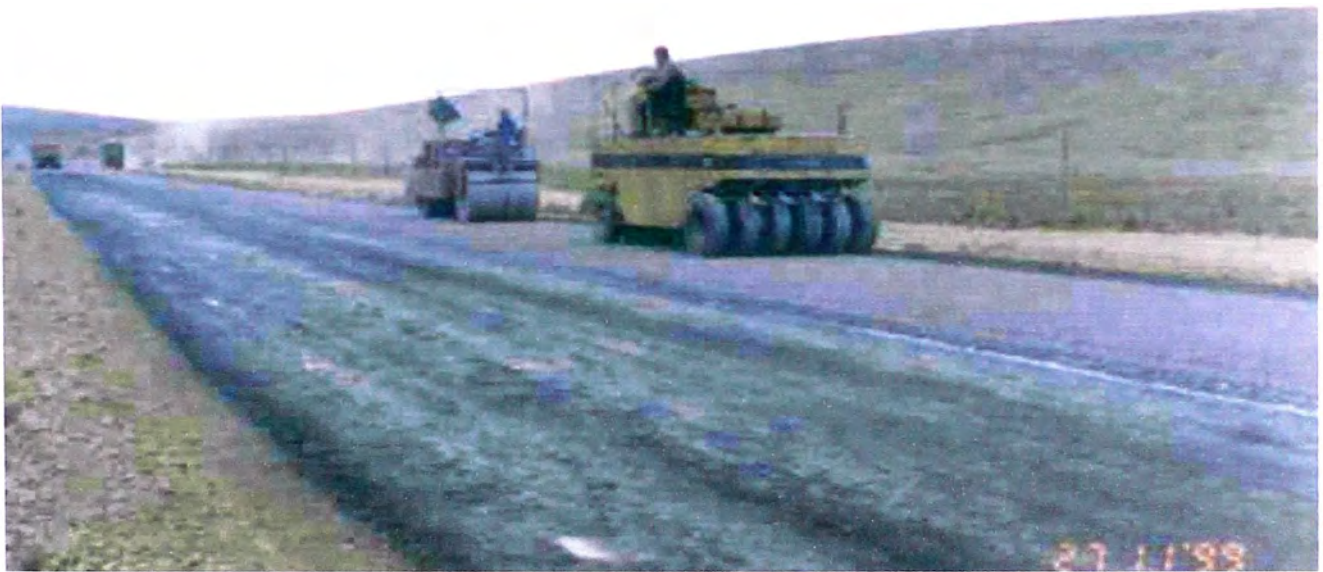
Fotografía VIII-16.- Con el rodillo neumático se logra el mejor acomodo de las partículas del árido, reduciendo el porcentaje de vacíos.
