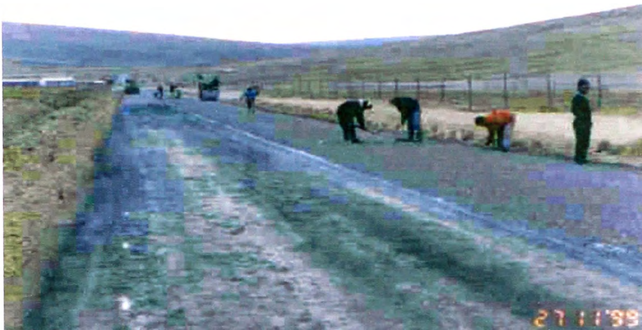
Fotografía VIII-14.- A medida que progresa el esparcido de grava, se va realizando el “resane” o correctivo necesario, utilizando rastrillos.
