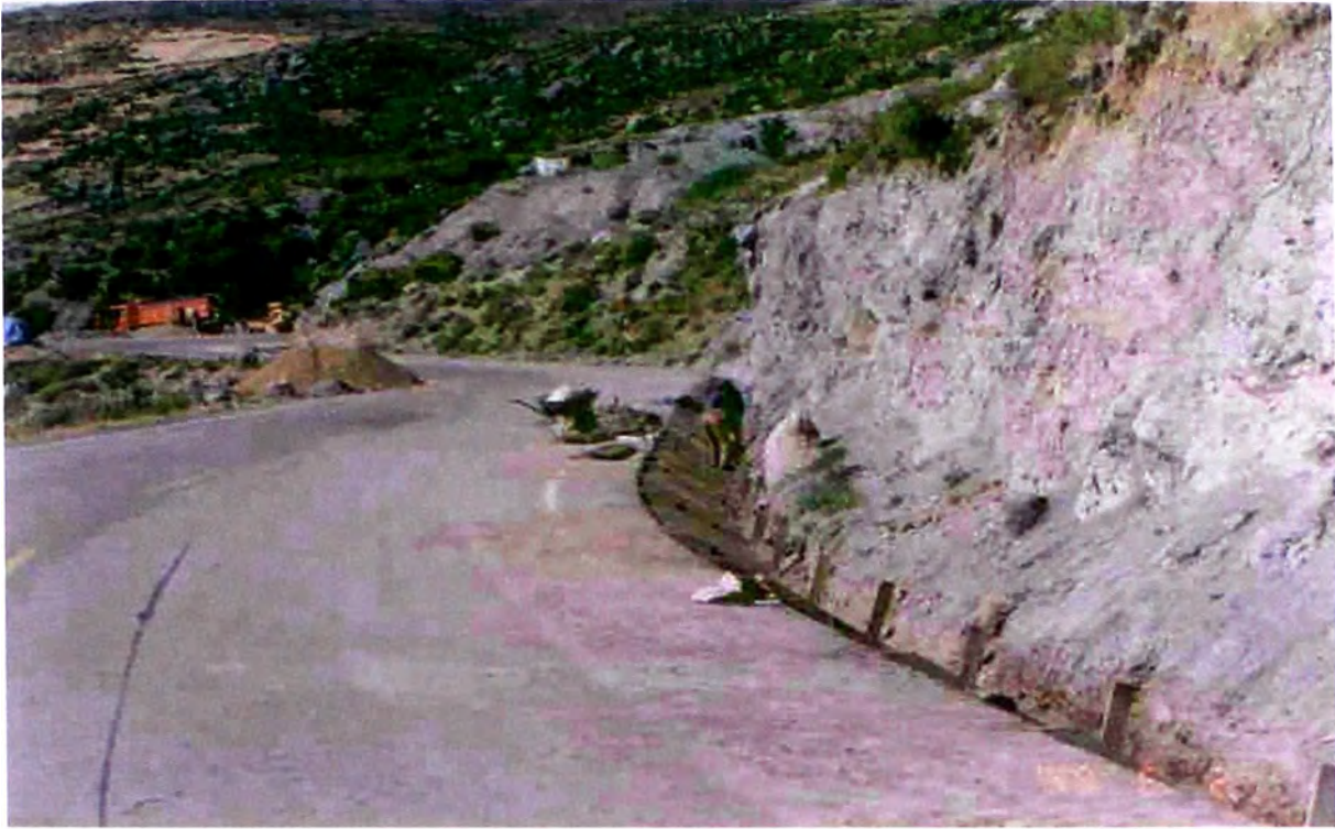
Fotografía VII-3.- Se colocan las cerchas, verificando la coincidencia con la rasante.
