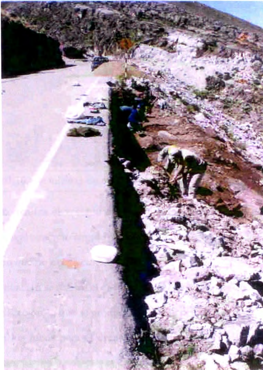
Fotografía VII-9.- Se trabaja en la excavación para la construcción del muro del sector.
