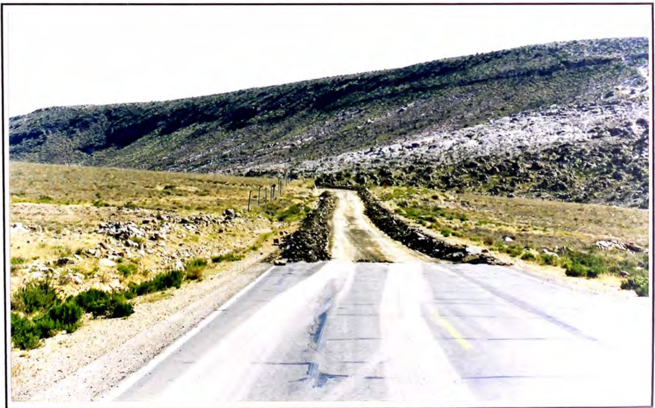
Se ha ejecutado el escarificado y corte de la carpeta asfáltica.
