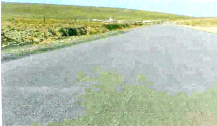
Fotografía VIII-19.- Vista panorámica de un tramo concluido a nivel de Tratamiento Superficial Bicapa.
