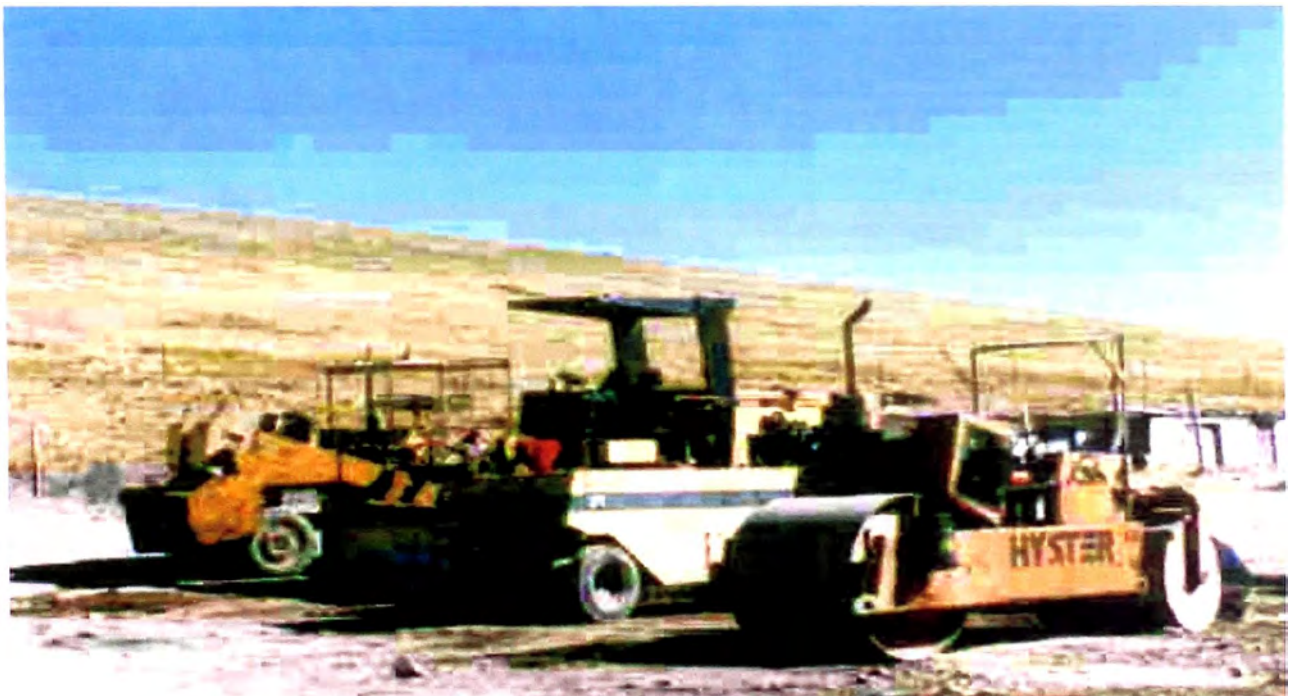
Fotografía VIII-6.- Equipos para el Asfaltado: Rodillo Tándem, Rodillo Neumático y Esparcidora de Agregados.
