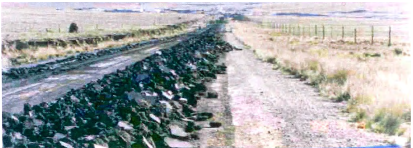
Fotografía VI-1.- Se observa la carpeta asfáltica ya removida.
