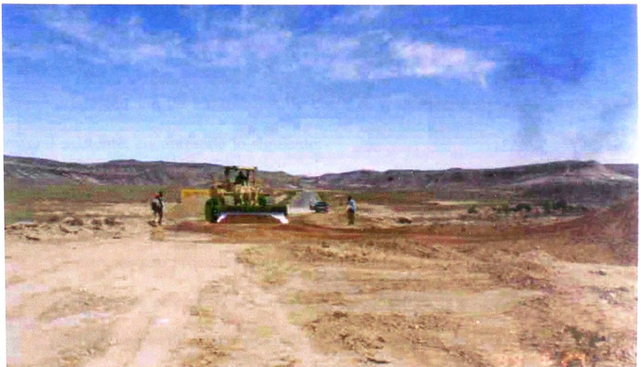
Fotografía VI-2.- A medida que progresa el corte del pavimento existente (base + sub-base), el material es acumulado lateralmente a la vía.
