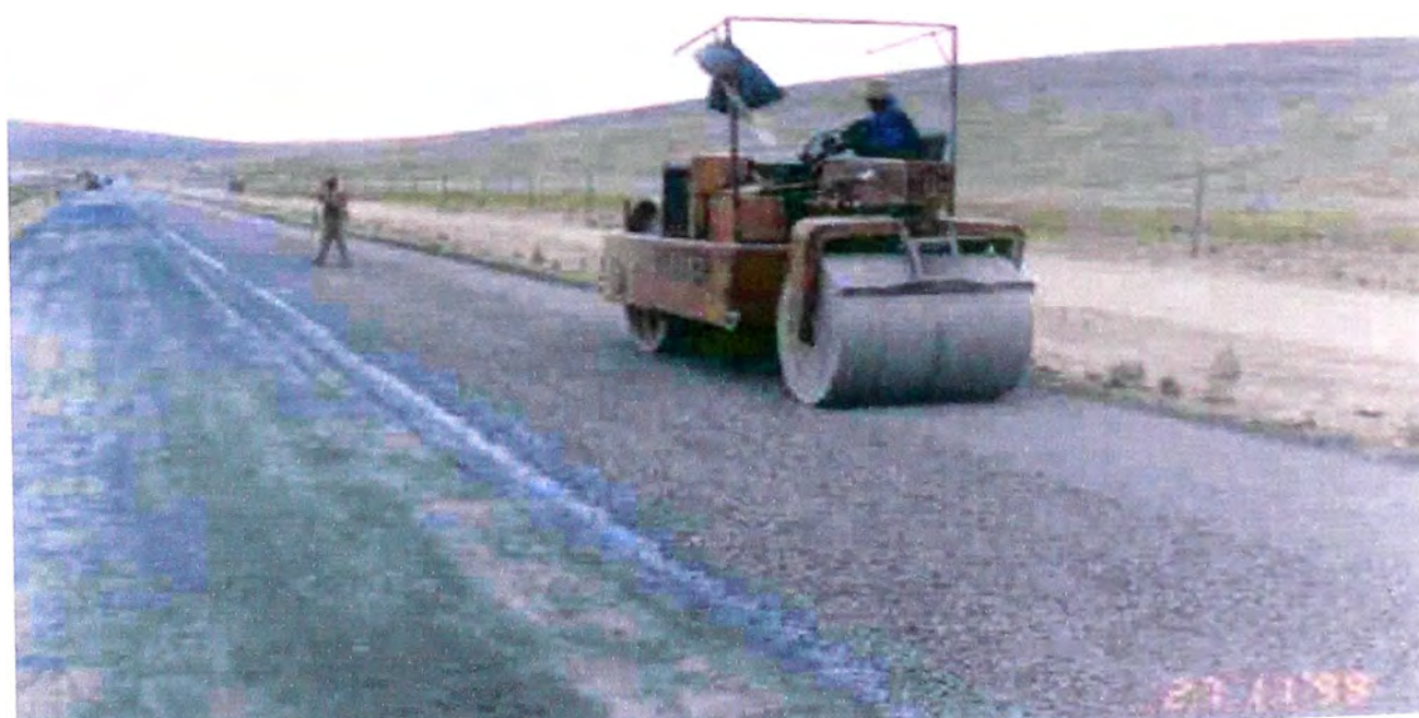
Fotografía VIII-15.- El rodillo tándem es utilizado para lograr la trabazón inicial del agregado con el líquido asfáltico.
