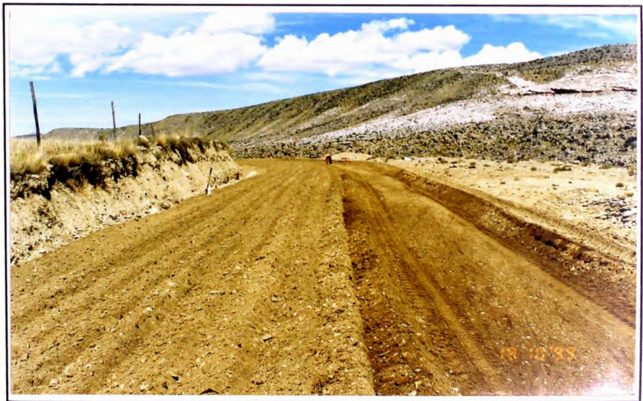
Material colocado en pista. Se realiza el batido antes de proceder a conformar la capa de base.
