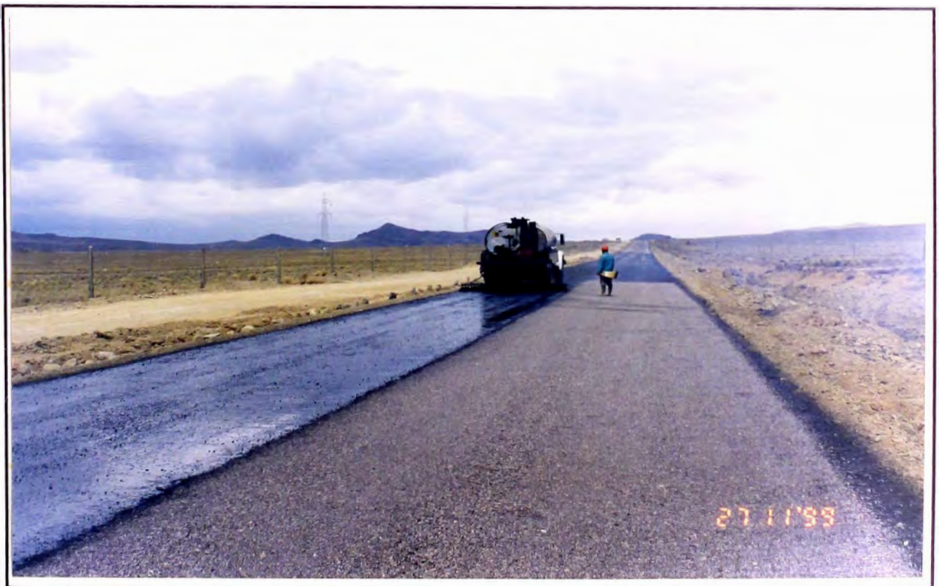
Arriba: Se efectúa el rayado para delimitar el ancho para el tratamiento superficial. Bajo: Se ejecuta el tratamiento superficial primera capa.
