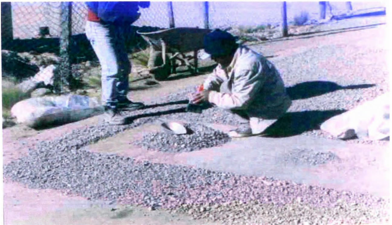
Fotografía VIII-10.- Se recoge el material para determinar la cantidad de grava aplicada durante el esparcido de prueba.
