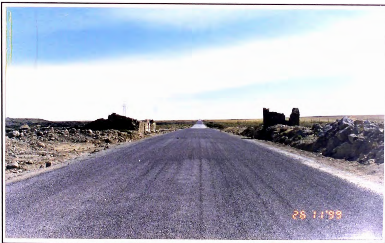
Arriba: Equipo mecánico listo para iniciar el tratamiento superficial primera capa. Abajo: Vista del tramo con primera capa concluida.
