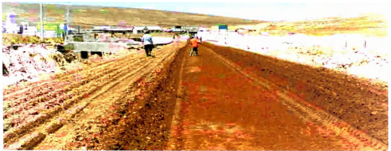
Fotografía VIII-1.- La motoniveladora realiza el batido del material, llevándolo alternadamente hacia uno y otro lado de la vía.
