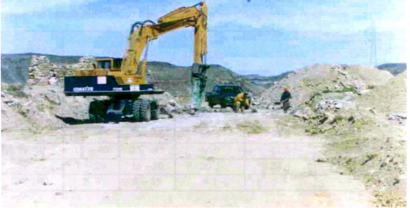
Fotografía VI-3.- Utilizando la excavadora con martillo neumático se realiza la extracción de roca en sectores puntuales de la vía.
