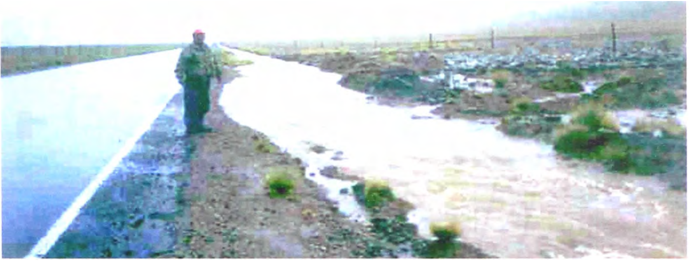
Fotografía III-1.- Con fecha 23-Feb-99 ocurre la precipitación más intensa y las cunetas sin revestir se ven superadas por los flujos superficiales.
