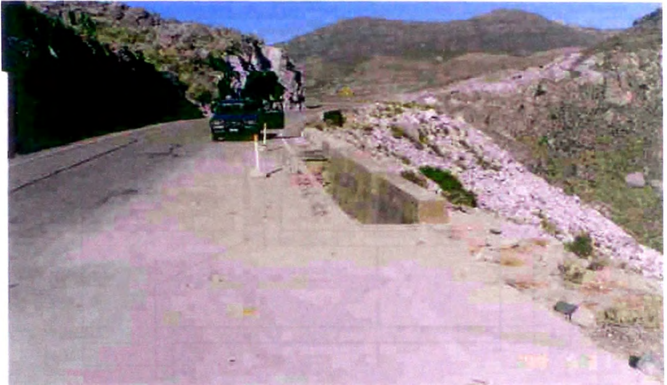
Fotografía VII-11.- Muro de Sosténimiento ya concluido, quedando por ejecutar el relleno estructural en el respaldo.
