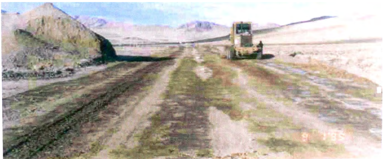
Fotografía VI-5.- La motoniveladora realiza el perfilado de la nueva subrasante sobre terreno natural.
