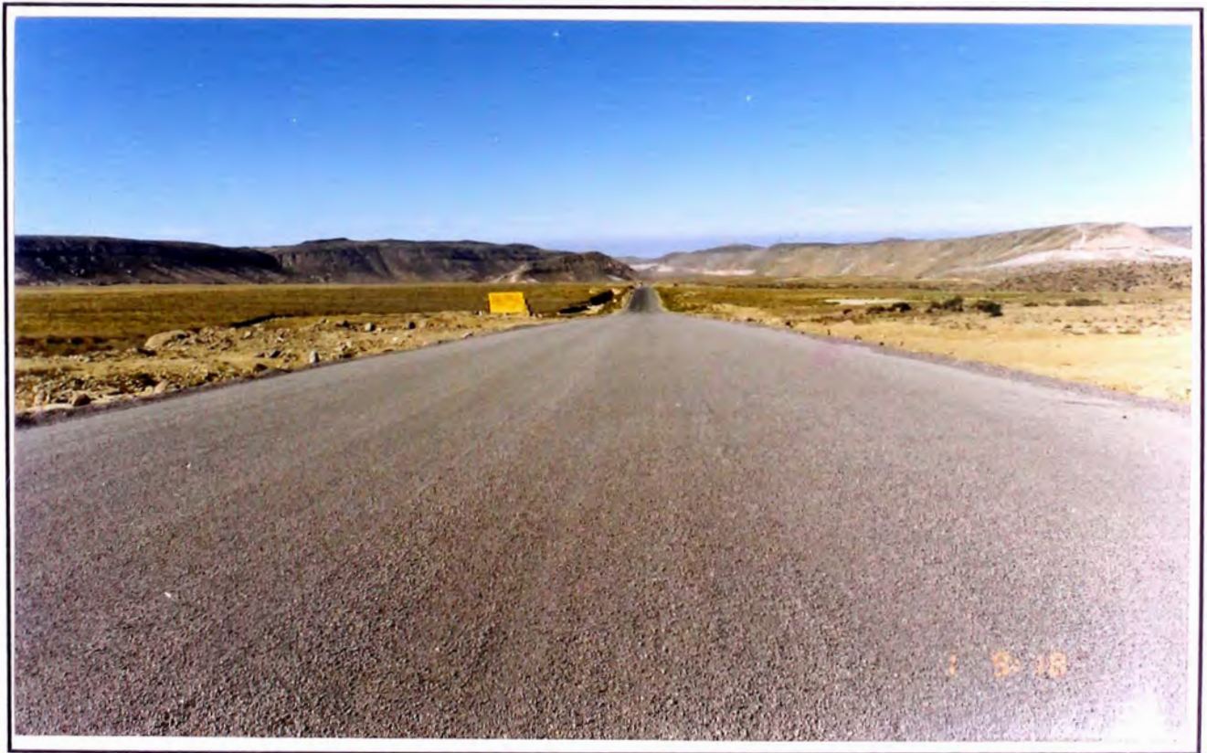
Arriba: Vista del tramo con parte del carril izquierdo imprimado.
