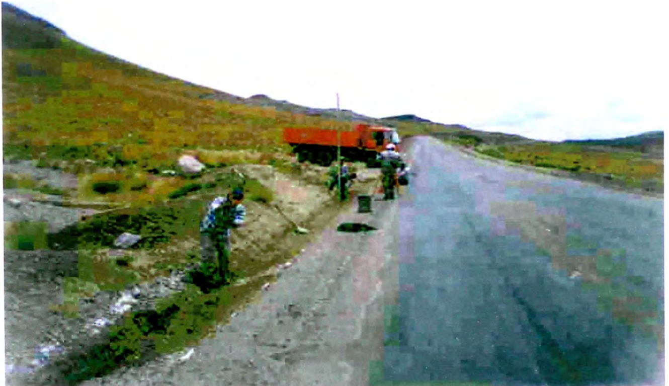
Fotografía VII-2.- Se efectúan controles alimétricos de la excavación.
