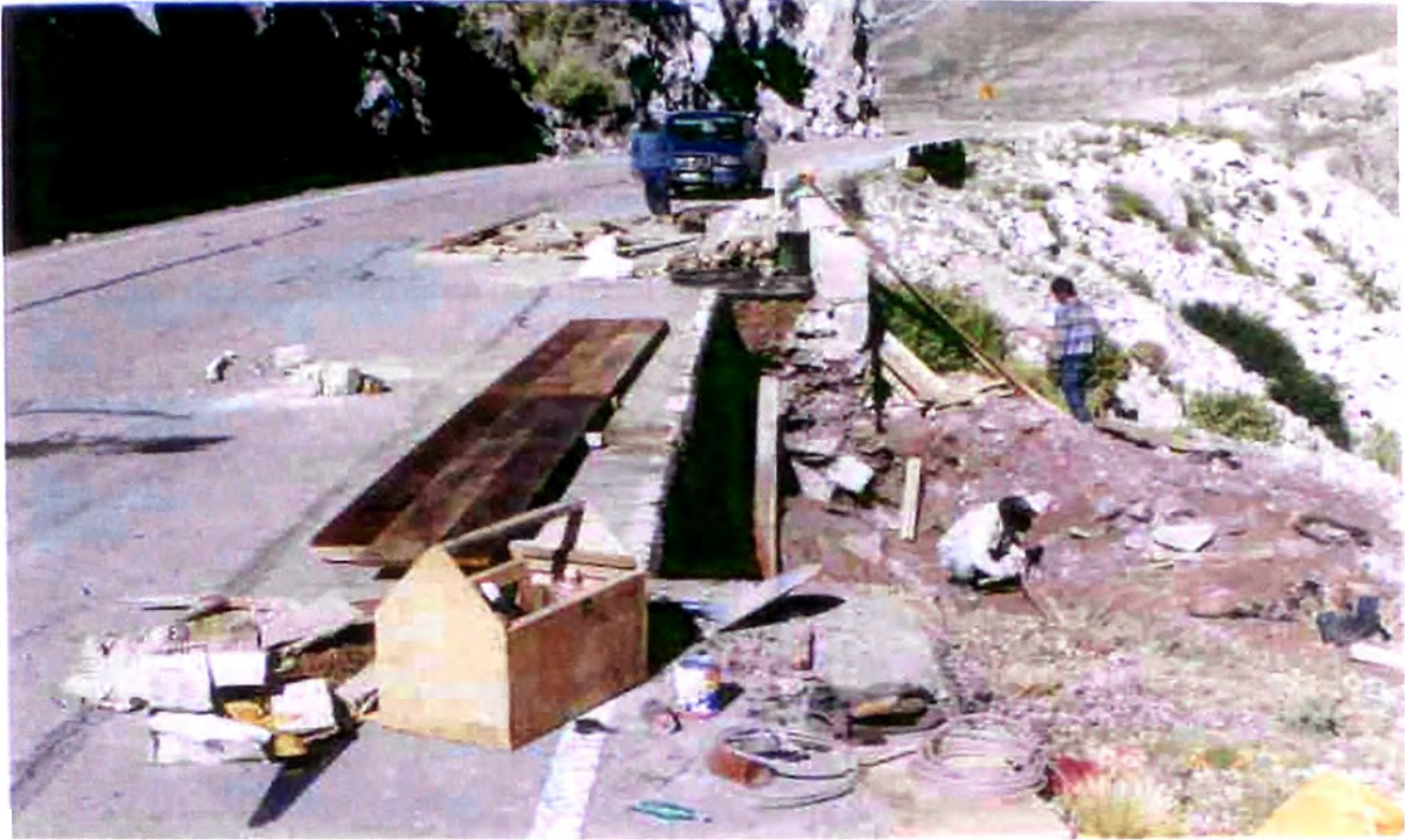
Fotografía VII-10.- Se inicia el encofrado de la cimentación.
