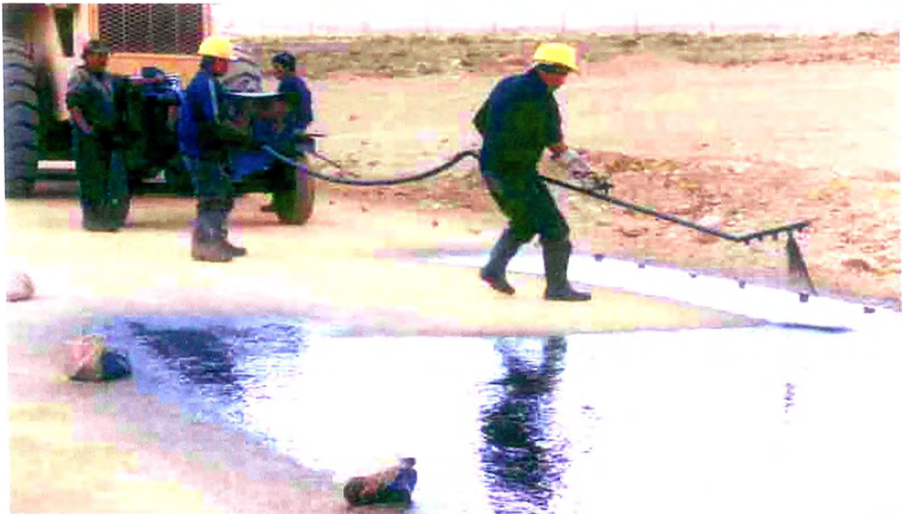
Fotografía VIII-4.- Se ejecuta la imprimación utilizando una cocina asfáltica.
