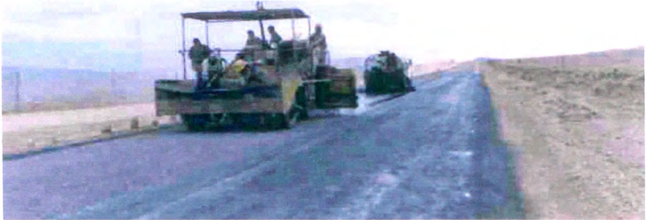
Fotografía VIII-12.- Se inicia el Tratamiento Superficial. Es importante que la grava sea esparcida lo mas pronto se riegue el líquido asfáltico para favorecer la adherencia entre la grava y el RC-250.
