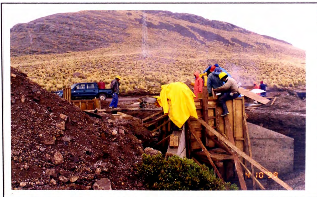
Se trabaja en el encofrado de losa superior y parapetos de la alcantarilla.
