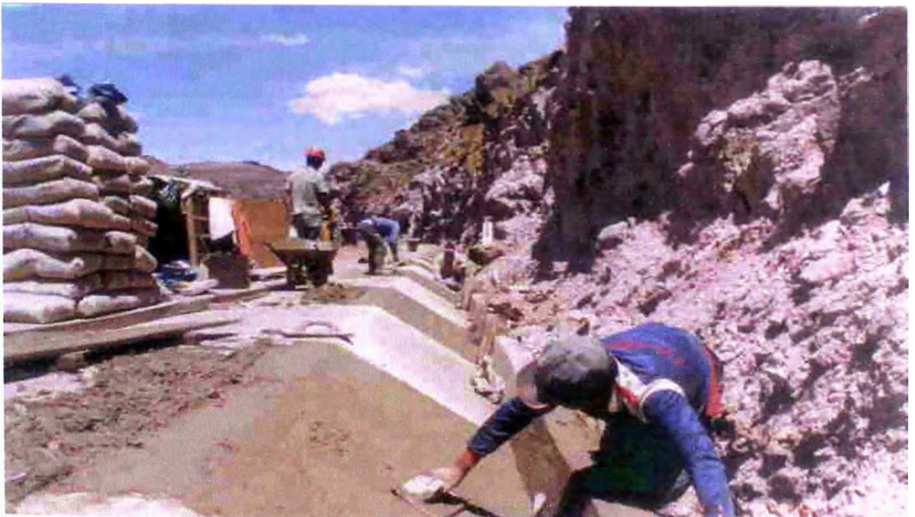
Fotografía VII-7.- Se ejecuta la construcción del paño faltante.
