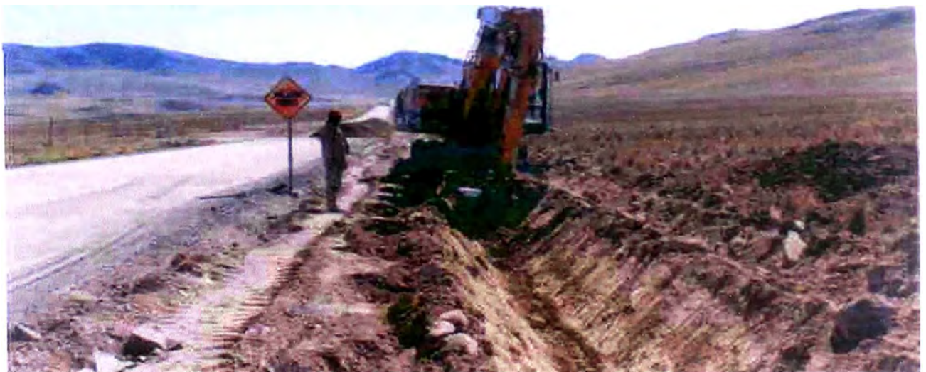
Fotografía VII-14.- Se ejecuta la excavación de zanja de drenaje, utilizando una excavadora Neumática con cucharón trapezoidal.
