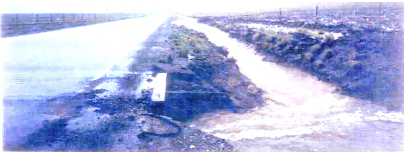
Fotografía III-2.- Se observa que la sección hidráulica de las alcantarillas existentes es suficiente para las solicitudes del servicio.
