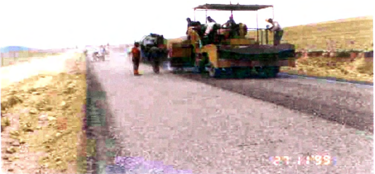
Fotografía VIII-17.- Se completa el tratamiento superficial primera en el otro carril.
