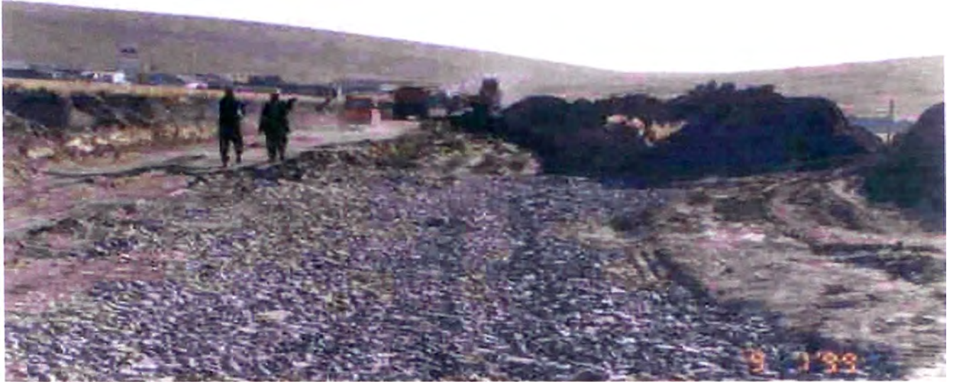
Fotografía VI-4.- Se observa la ejecución de un “ mejoramiento profundo ”, colocando material granular tipo “ over ”, por capas.
