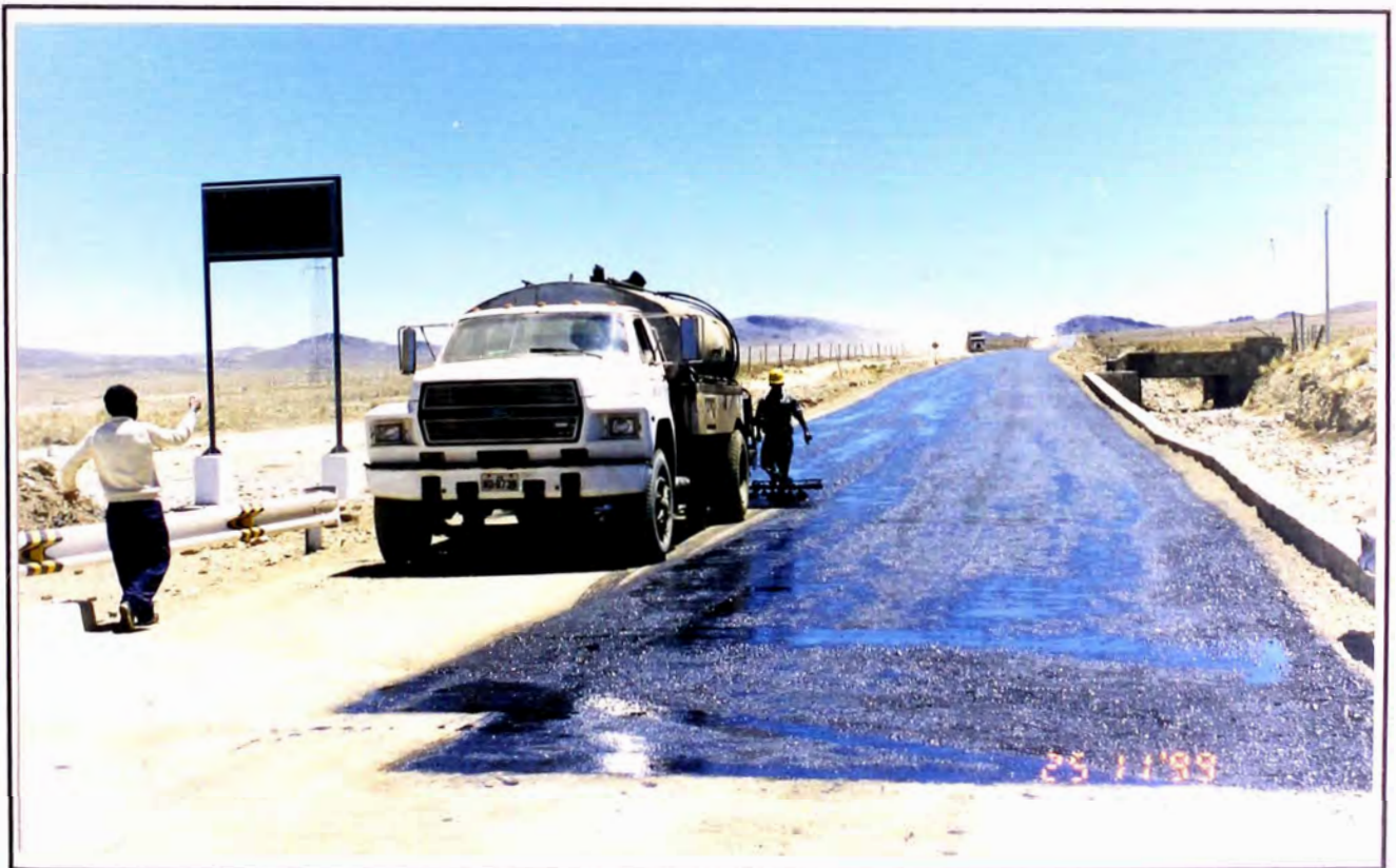
Se ejecuta la imprimación bituminosa, con una mezcla de asfalto líquido RC-250 + 30% de Kerosene, equivalente a un MC-30.
