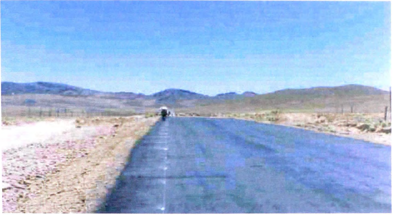
Figura VIII-11.- Se efectúa el rayado de los límites para el tratamiento superficial.
