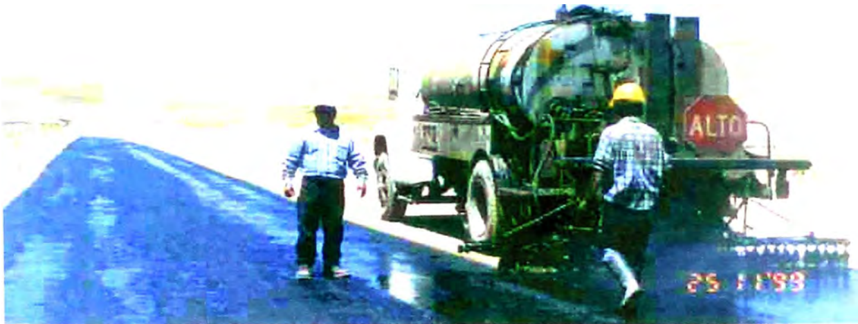
Fotografía VIII-5.- Riego de material bituminoso utilizando un camión imprimador de 1800 galones de capacidad.
