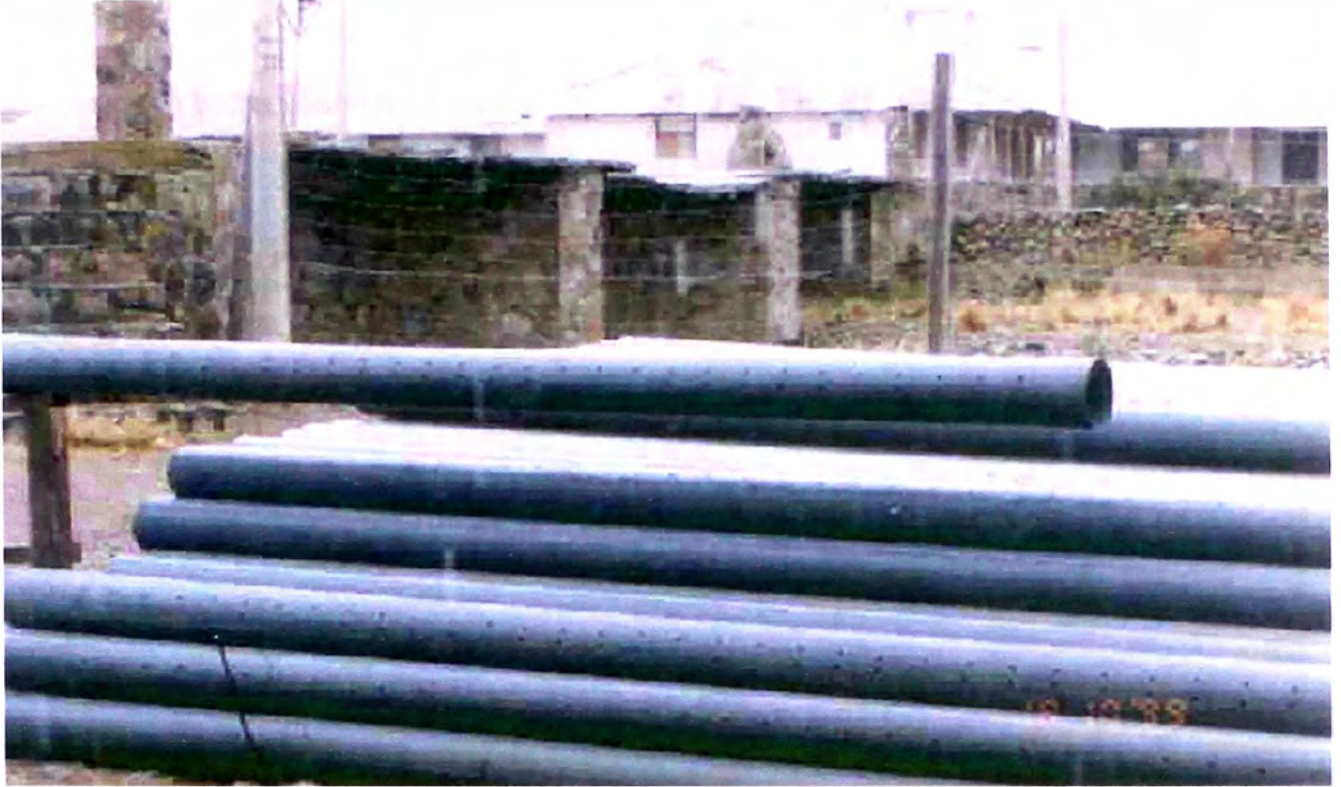
Fotografía VII-12.- Los tubos se perforan en banco, de acuerdo al diseño recomendado.
