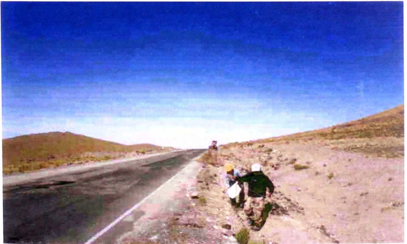
Fotografía VII-1.- Se realiza el trazo del borde interior de la cuneta.
