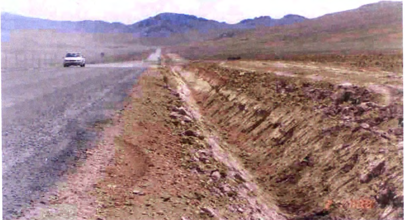
Fotografía VII-15.- Zanja de drenaje concluida.
