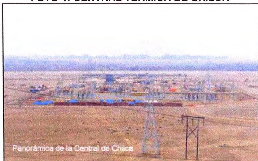
FOTO 1: CENTRAL TÉRMICA DE CHILCA
