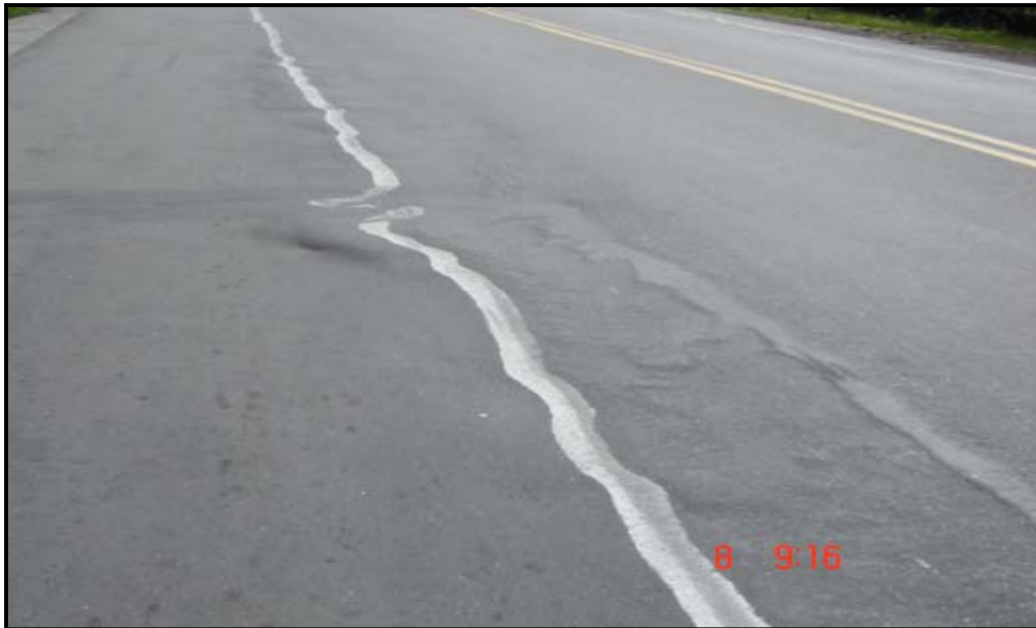
Fotografía 7.1: Falla por ondulación
