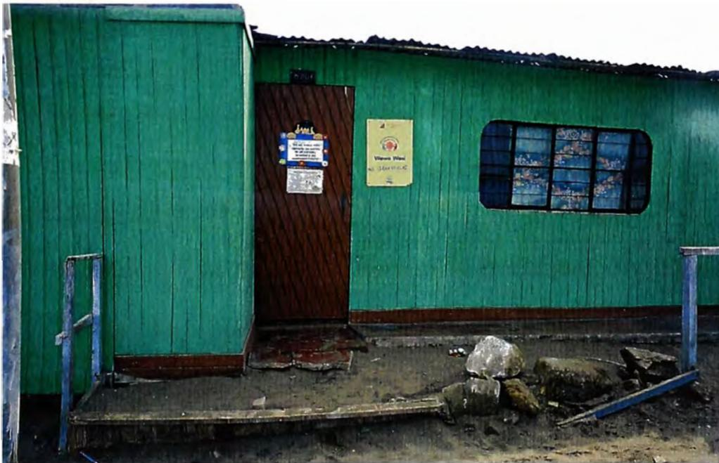
**FIGURA N°4. Viviendas sobre base de concreto pobre.**
