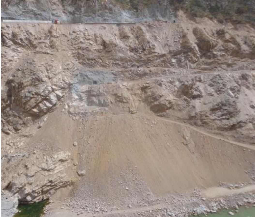
Figura N° 15 Excavación inicial del estribo izquierdo de la Presa (Fuente: Propia)
