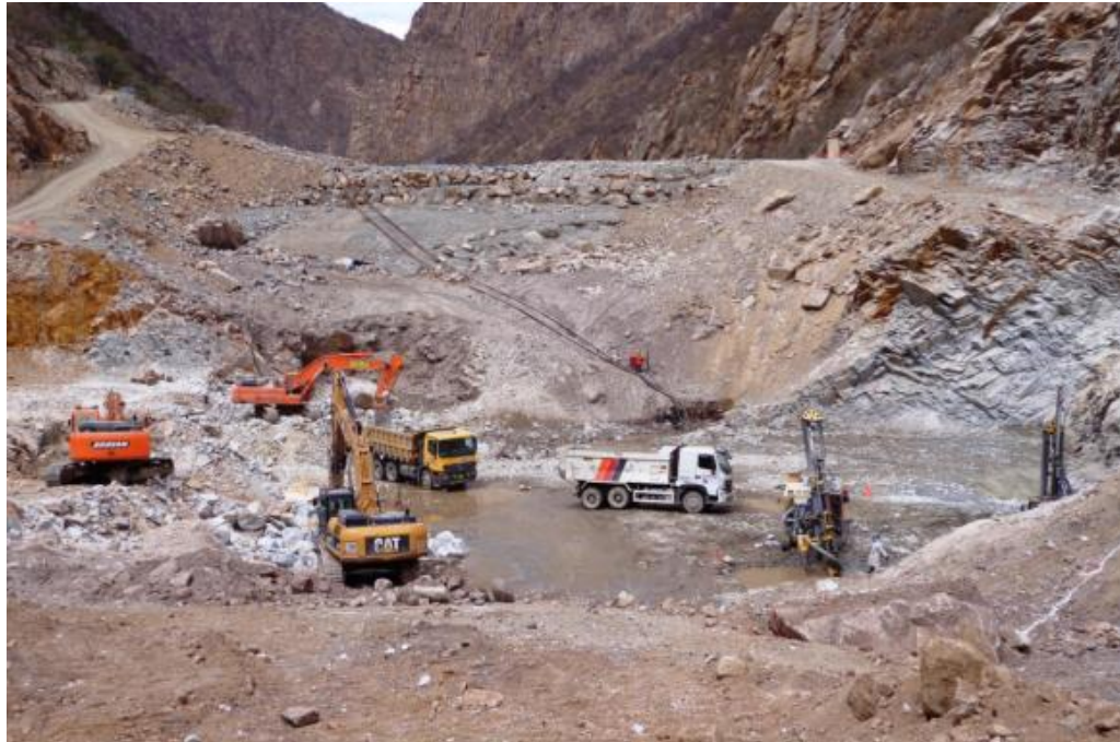
Figura N° 17 Excavación inicial del fondo de Presa (Fuente: Propia)
