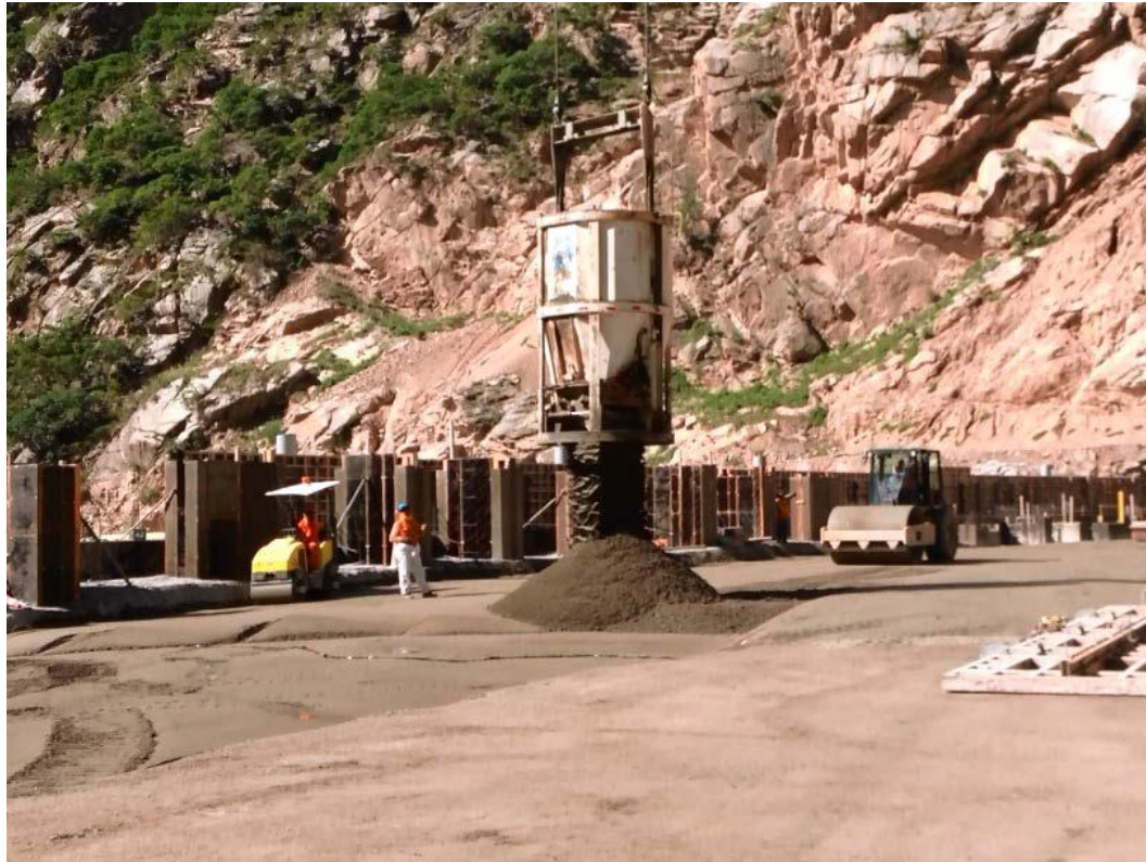
Figura N° 19 Colocación del CCR con Blondin (Fuente: Propia)
