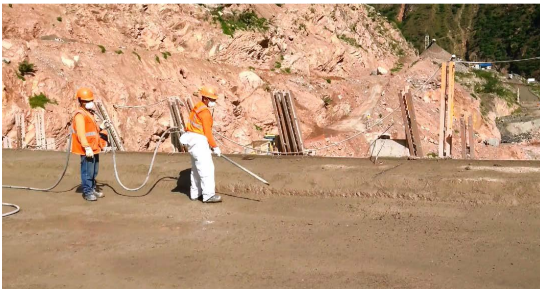
Figura N° 30 Limpieza de la superficie con aire húmedo (Fuente: Propia)
