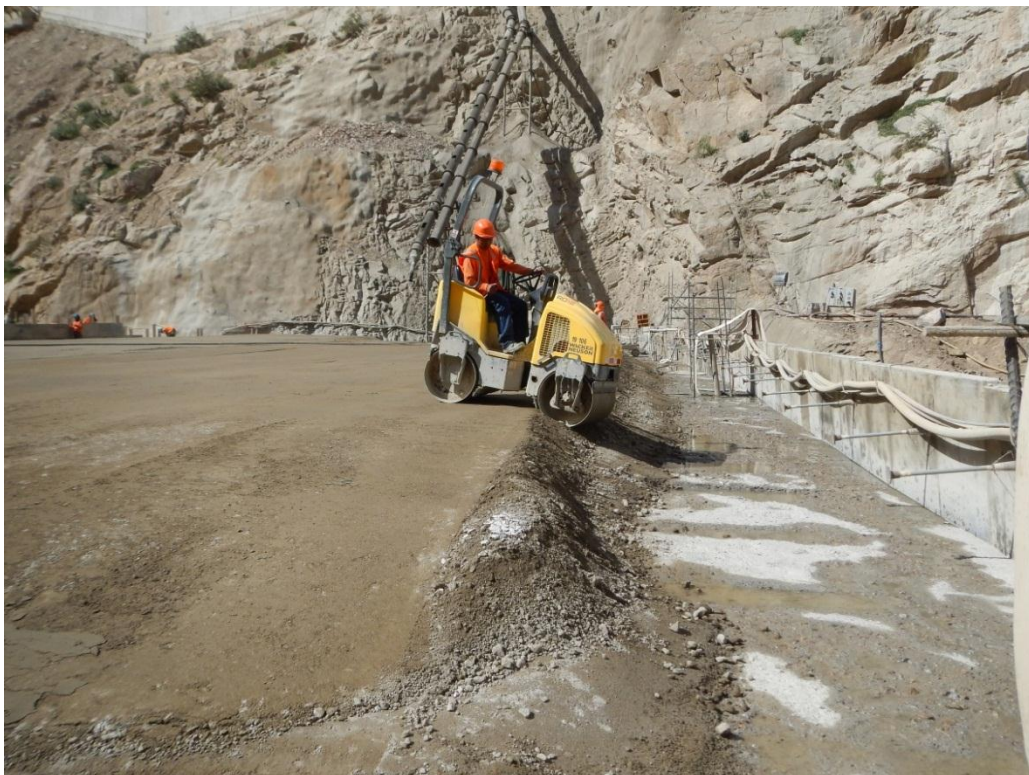
Figura N° 26 Rodillo Tandem compactando CCR (Fuente: Propia)
