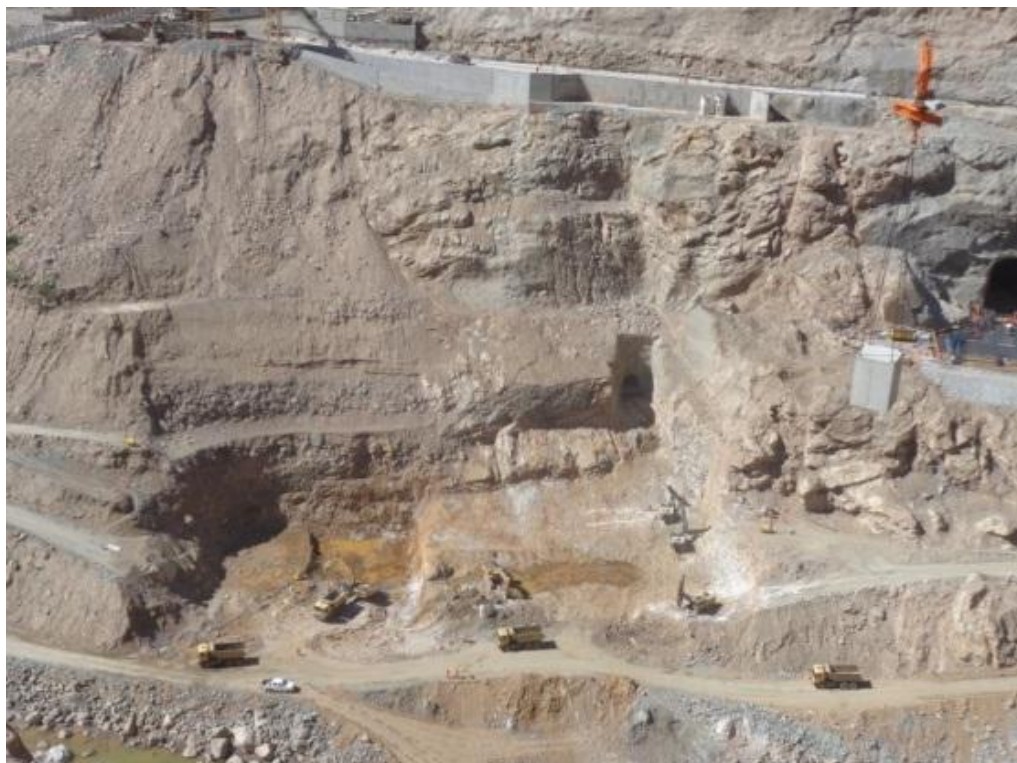
Figura N° 14 Excavación final del estribo derecho de la Presa (Fuente: Propia)
