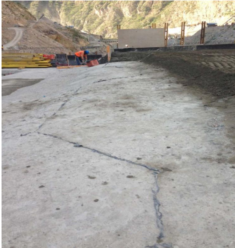
Figura N° 29 Junta de contracción (Fuente: Propia)
