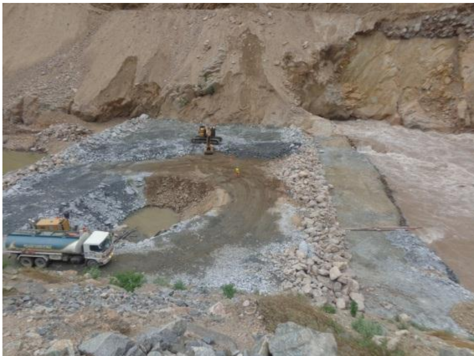
Figura N° 12 Construcción de Ataguías Aguas Abajo (Fuente: Propia)
