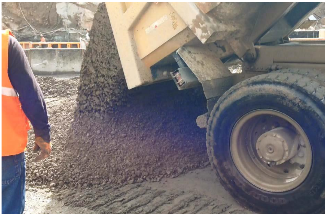
Figura N° 22 Camión Volquete colocando CCR (Fuente: Propia)
