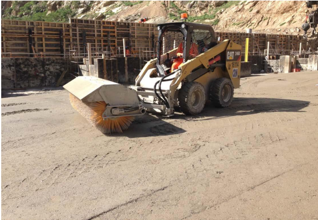
Figura N° 31 Limpieza de la superficie con minicargador con cepillo mecánico (Fuente: Propia)
