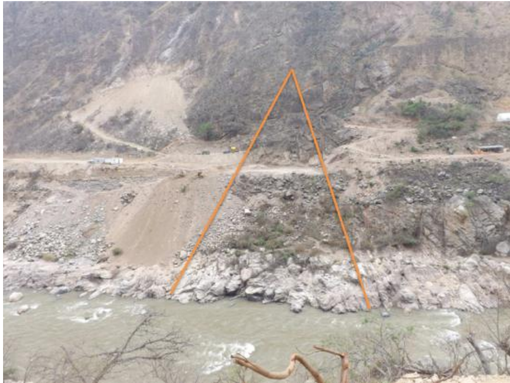
Figura N° 13 Estribo derecho de la Presa antes de excavar (Fuente: CRM)
