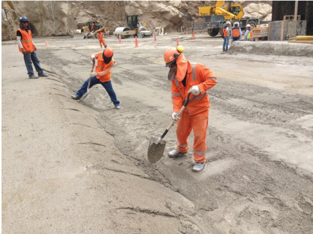
Figura N° 27 Zona de junta entre CVC y CCR (Fuente: Propia)
