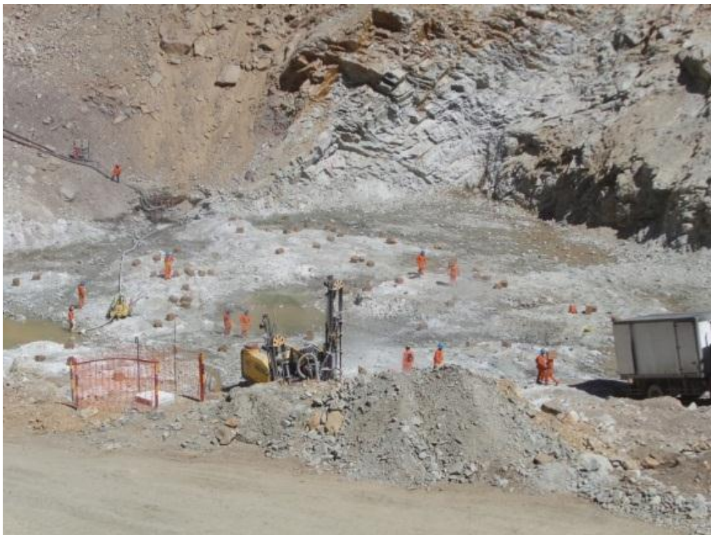
Figura N° 18 Excavación final del fondo de Presa (Fuente: Propia)
