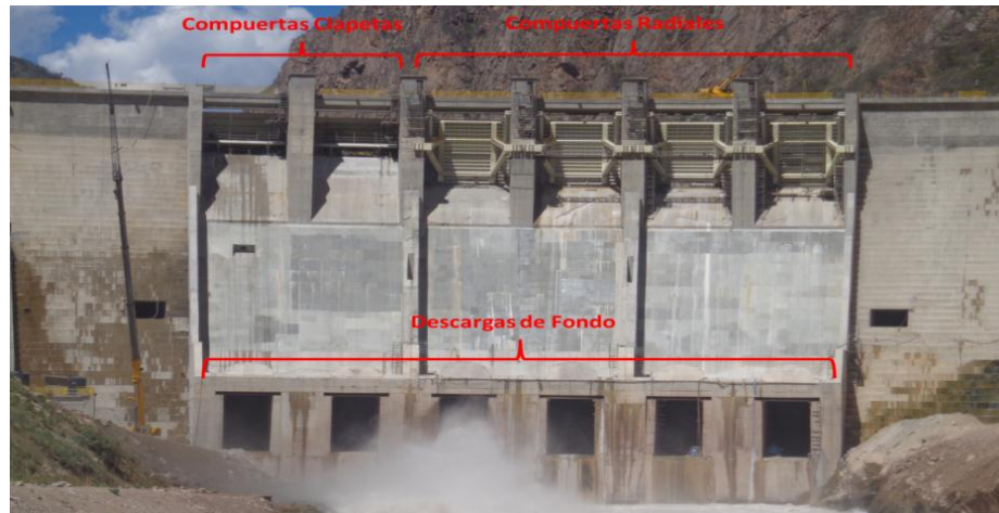
Figura N° 5.9 Vista desde aguas abajo – Sistema de Descarga (Fuente: Propia)
