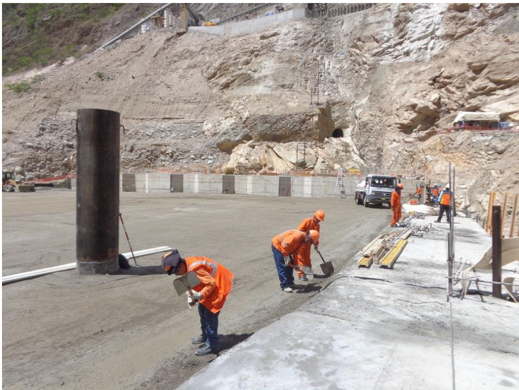
Figura N° 24 Extendiendo complementario manual del CCR (Fuente: Propia)
