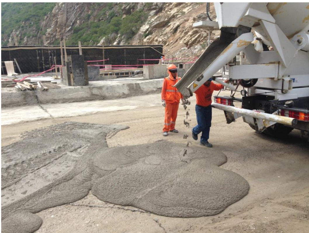
Figura N° 32 Aplicación de mortero de pega (Fuente: Propia)
