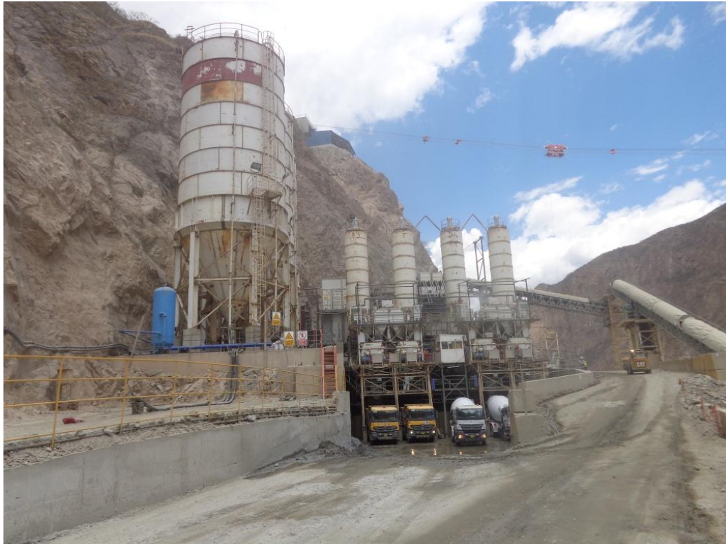
Figura N° 21 Camión Volquete alimentado desde la PCP (Fuente: Propia)
