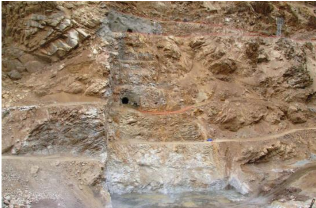
Figura N° 16 Excavación final del estribo izquierdo de la Presa (Fuente: Propia)
