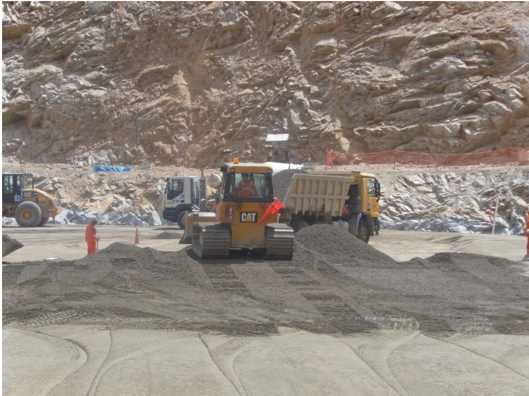
Figura N° 23 Tractor D5 extendiendo CCR (Fuente: Propia)
