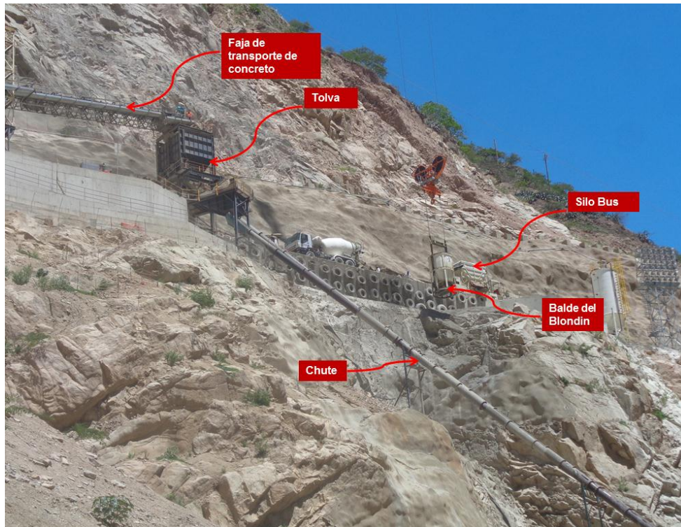
Figura N° 5.8 Elementos del Vaciado con Blondin (Fuente: Propia)
