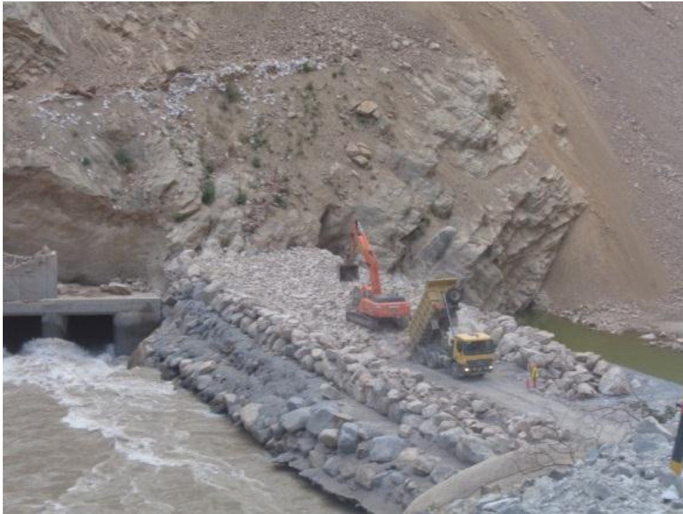
Figura N° 11 Construcción de Ataguías Aguas Arriba (Fuente: Propia)
