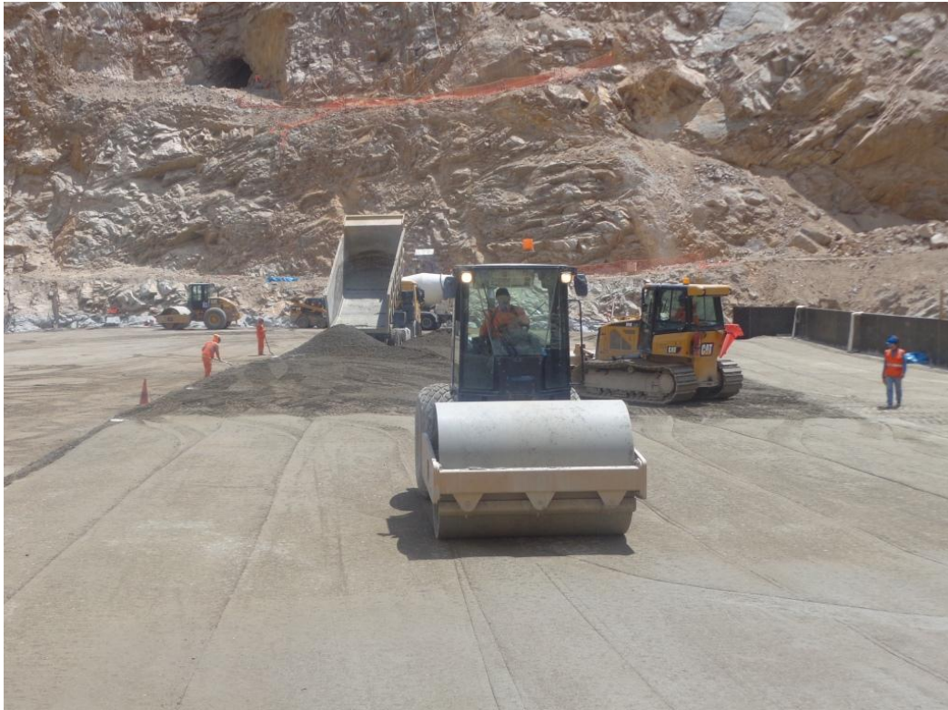
Figura N° 25 Rodillo liso de 10 t compactando CCR (Fuente: Propia)
