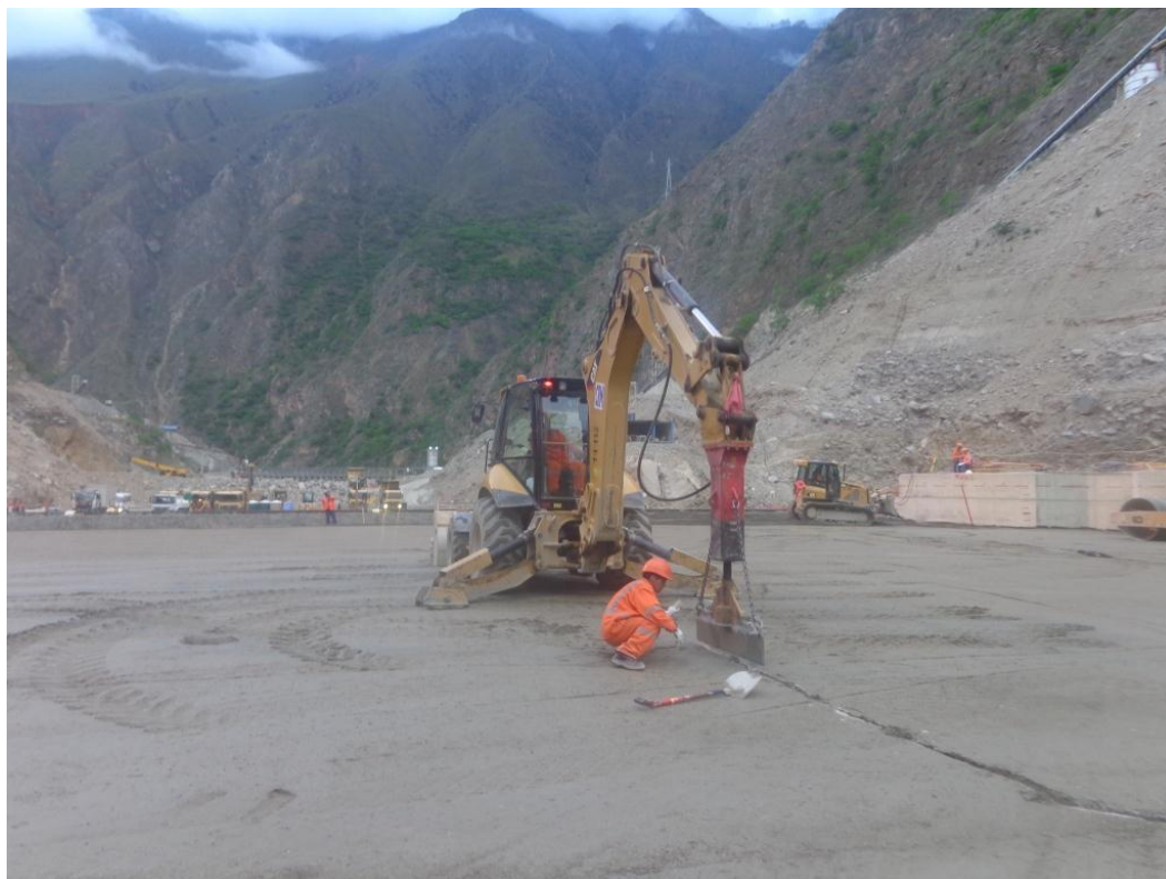
Figura N° 28 Retroexcavadora realizando la junta de contracción (Fuente: Propia)
