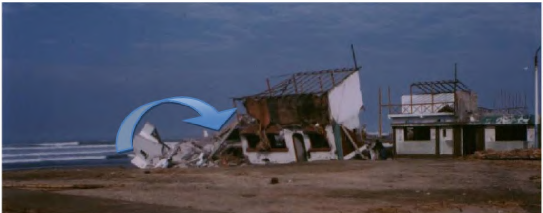
F4.1.9 Licuación de suelos y deficiencias constructivas. Obsérvese la vivienda de la derecha que no presenta daños en la fachada pero si la marca de agua al nivel inferior de las ventanas. La Punta, Camaná.
