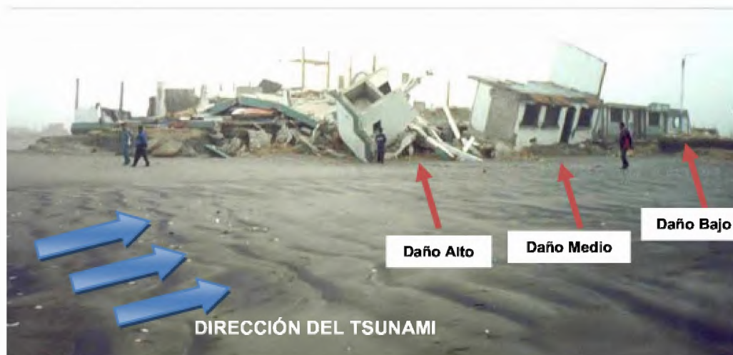
F4.1.11 Dirección de las olas. Se observa que la primera vivienda de la derecha recibe el impacto directo y protege a las viviendas posteriores.
