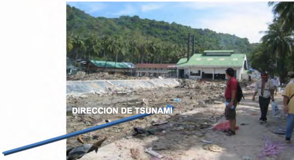
F4.2.5 Planta de Tratamiento de Aguas Residuales en las islas Phi Phi, Krabi. Obsérvese el recorrido directo del tsunami hacia las edificaciones posteriores atravesando el primer nivel por los espacios libres sin generar mayor daño a la parte estructural. Run-up 10.0m
