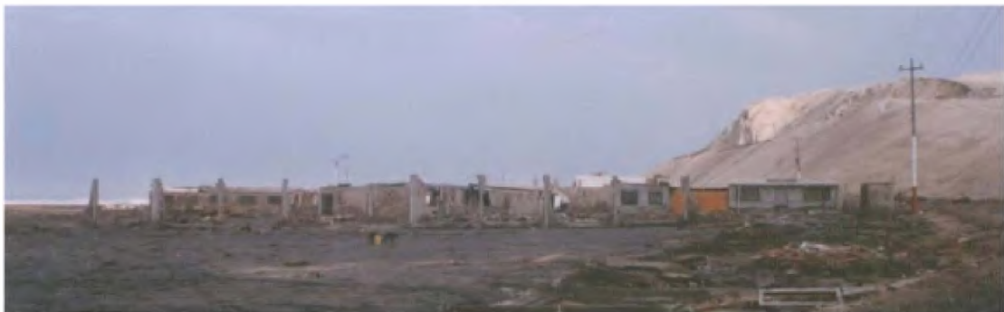
F4.1.5 Viviendas de un nivel de bloques de cemento en Los Cerrillos, Camaná
