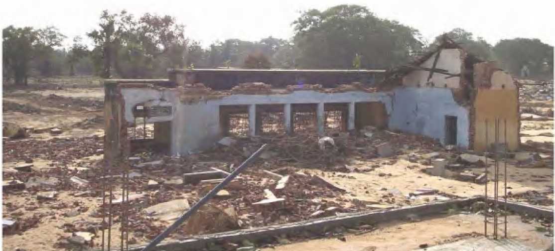
F4.2.15 Distrito de Kalmunai en la provincia Este de Sri Lanka. Vivienda de material de ladrillo de baja calidad con graves daños, excepto el lado con espacios abiertos que permitieron reducir la presión ejercida sobre el muro.
