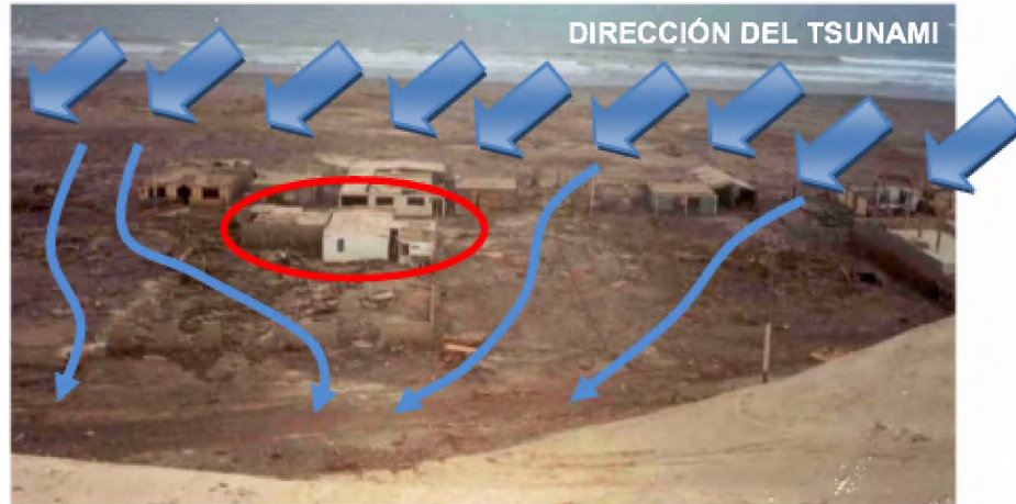
F4.1.14 Impacto de olas en viviendas.
