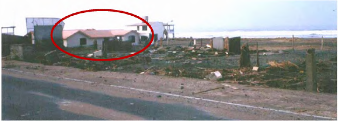
F4.1.8 Ingreso del tsunami hasta la carretera, sin embargo una vivienda protegida detrás de otra no presenta mayores daños.
