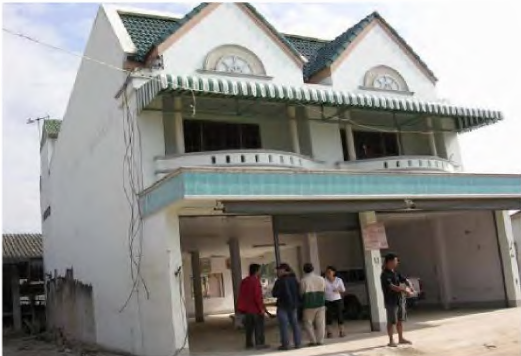
F4.2.9 Vivienda en Ban-Nam-Kem, Phang Nga. Tailandia. Se aprecia la estructura sin daños y los espacios libres en el primer nivel que permiten el paso de las aguas a través del predio.
