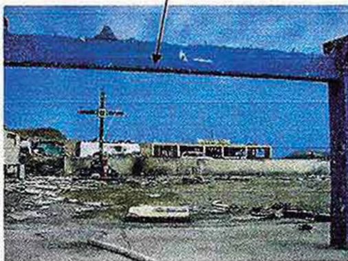
Fig. 8. Atracadero artesanal 5m de altura. Techo arrasado por la ola.
