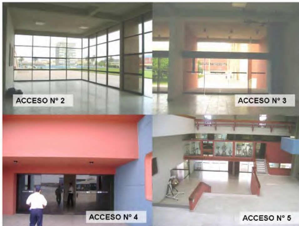
F6.1.4 Accesos al Edificio Grau. Vista interior: Accesos N°2, N°3 y N°5. Vista Exterior: Acceso N°4.
