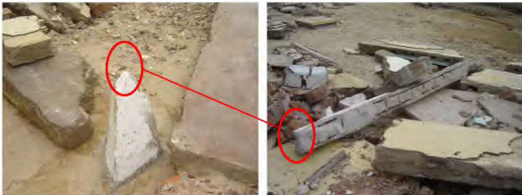
F4.3.9. La forma triangular de la columna contribuye al flujo libre alrededor del elemento, sin embargo se requiere mayor refuerzo en la base para evitar el volteo.
