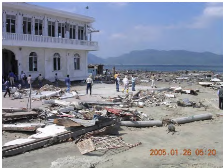
F4.2.10 Hotel sin daño considerable y ubicado a pocos metros de la playa
