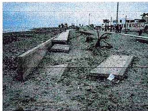
Fig. 12. Rotura de seguro superior de la puerta debido a la fuerza de empuje de las olas. (Izq). Arrastre y socavación de veredas del malecón. (Der).
