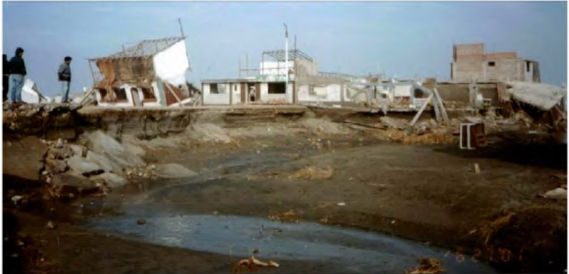
F4.1.10 Efectos de erosión por regresión de olas. Obsérvese las viviendas de la imagen anterior.
