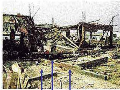
Fig. 7. restaurante turístico daños por tsunami
