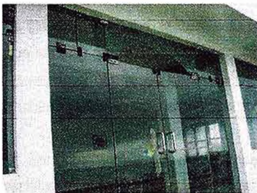
Fig. 12. Rotura de seguro superior de la puerta debido a la fuerza de empuje de las olas. (Izq). Arrastre y socavación de veredas del malecón. (Der).
