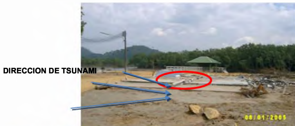
F4.2.5 Planta de Tratamiento de Aguas Residuales en las islas Phi Phi, Krabi. Obsérvese el recorrido directo del tsunami hacia las edificaciones posteriores atravesando el primer nivel por los espacios libres sin generar mayor daño a la parte estructural. Run-up 10.0m
