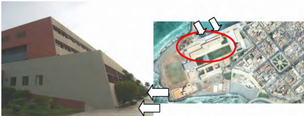
F6.1.1; F6.1.2 Edificio Grau de la Escuela Naval en La Punta - Callao. Posee las características en forma, orientación, arquitectura y estructuración que lo posibilitan como una edificación tsunami resistente. Fuente: Elaboración propia
