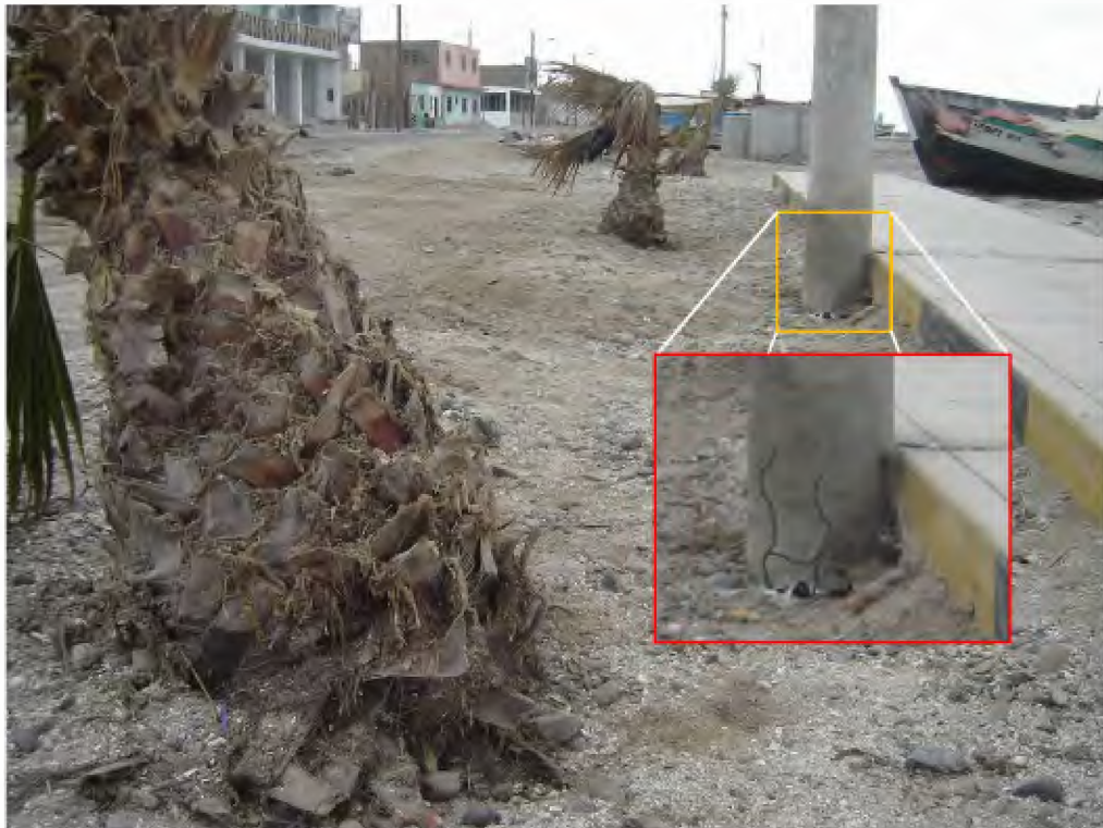
F4.3.7. El poste muestra el esfuerzo realizado producto del arrastre del tsunami, el cual también puede observarse en la inclinación de las palmeras.
