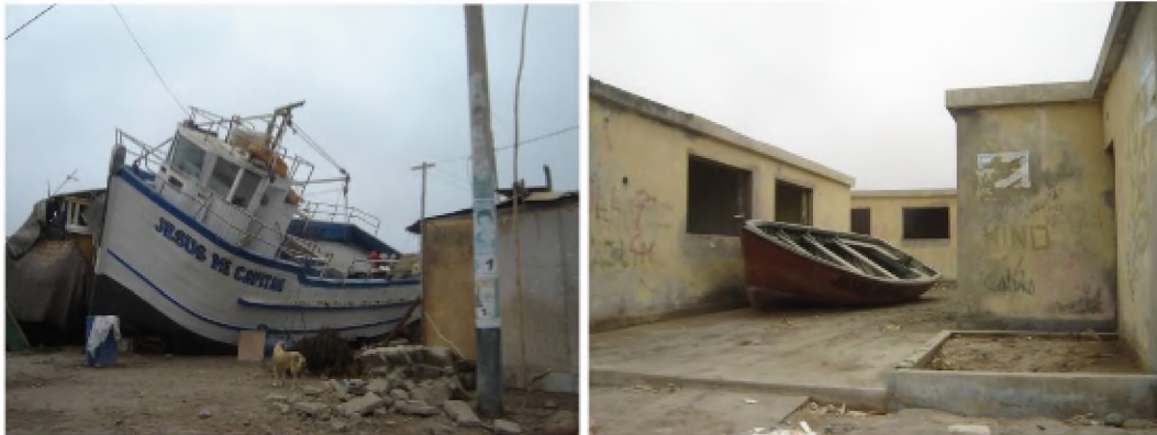
F4.3.11. Impacto de elementos y escombros en viviendas.
