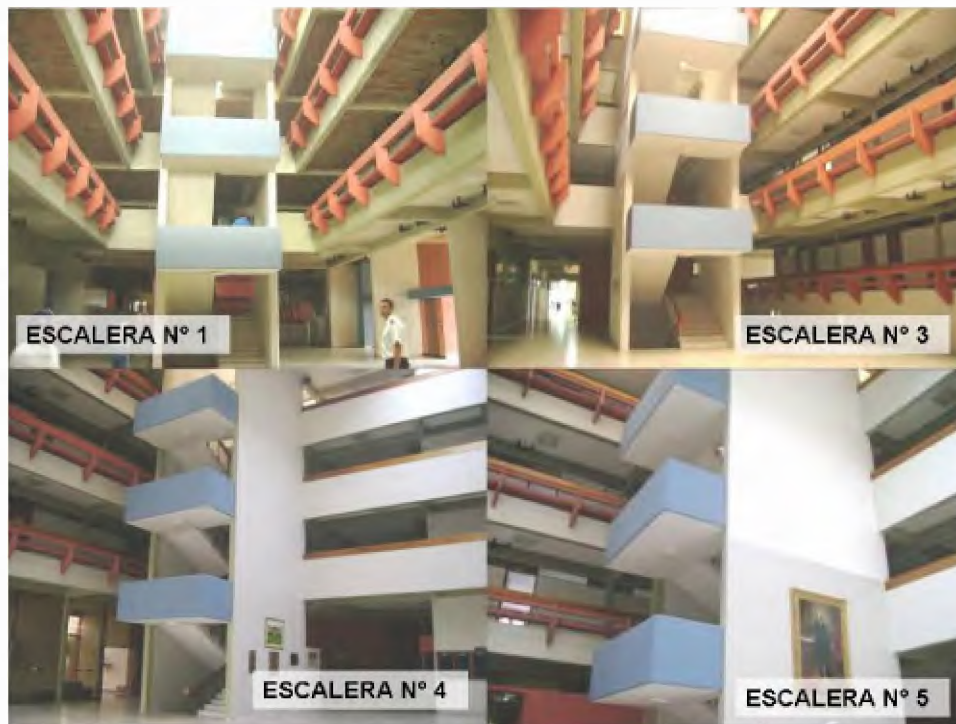
F6.1.5 Escaleras interiores. Ancho: 1.20m. Descanso a mitad de tramos y barandas.
