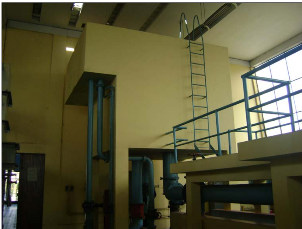
Fotografía 12.- Tanque Elevado (UNI)
