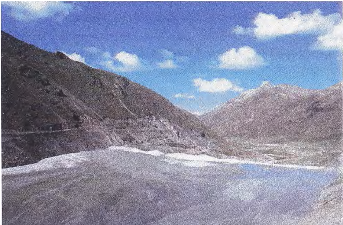
Fig. 10.- Depósito de Relaves de Chinchán
