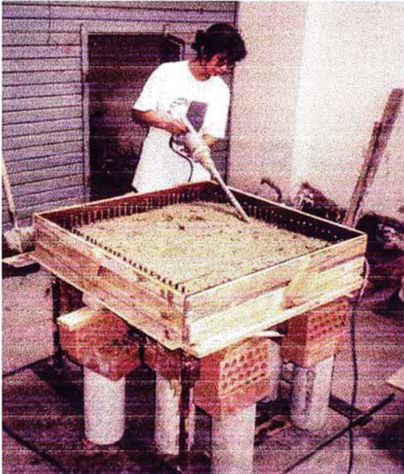
Foto N° 02.- Construcción de la losa
