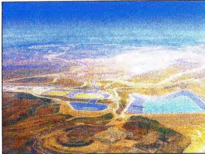
Pozas de solución de la Planta Yanacocha Norte
