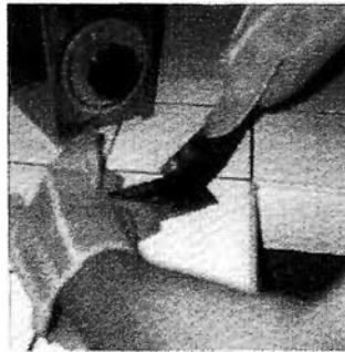
Foto 6 Eliminando el exceso de asfalto con ayuda de una espátula caliente
