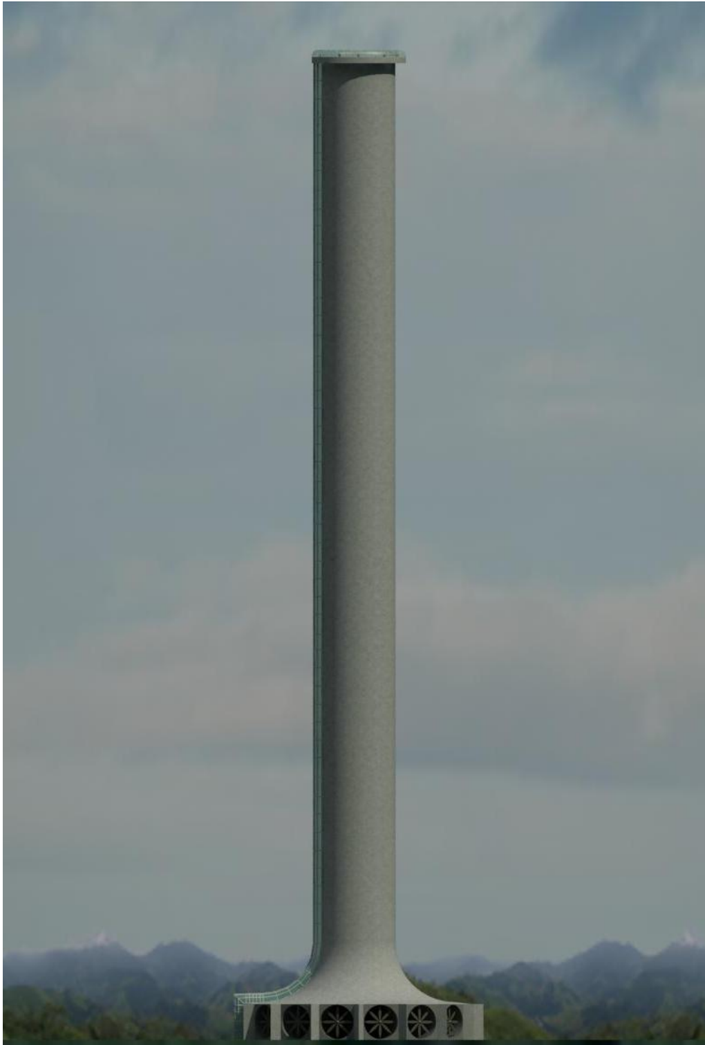
VISTA DE LA ESTRUCTURA PRINCIPAL
