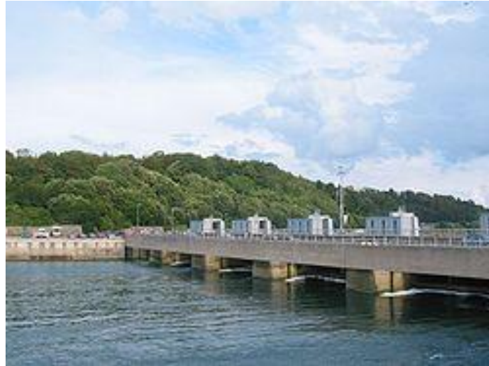
Central eléctrica mareomotriz en Francia.
