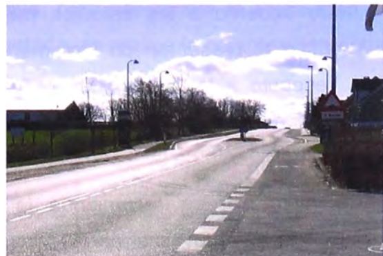
Figura 3.37 Tramo de una vía realineada, Dinamarca. Fuente : Report Vejdirektoratet, 2007.
