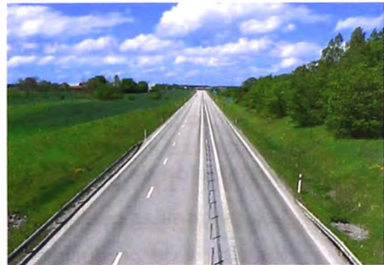
Figura 3.35 Tramo de una vía 2+1, Linköping-Suecia.
