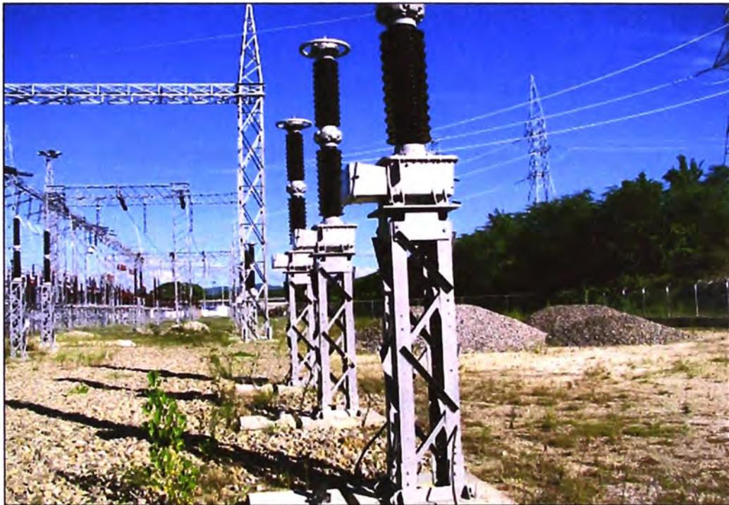
**Figura 2.4 Transformadores de tensión capacitivos (TT).**
