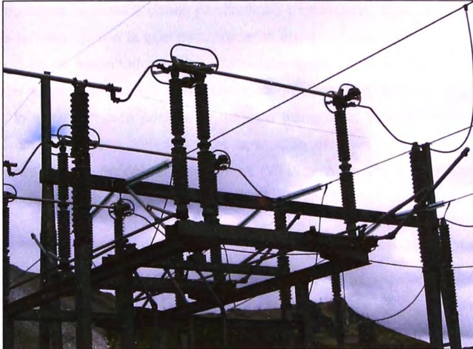
**Figura 2.2 Seccionador SWH-001 - Subestación Vizcarra.**
