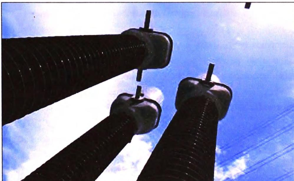
**Figura 2.3 Transformadores de corriente.**
