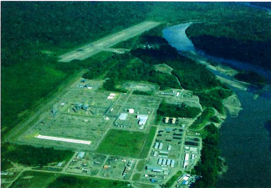
Foto N°7 Ubicación de la Planta de Gas Mayo 2004
