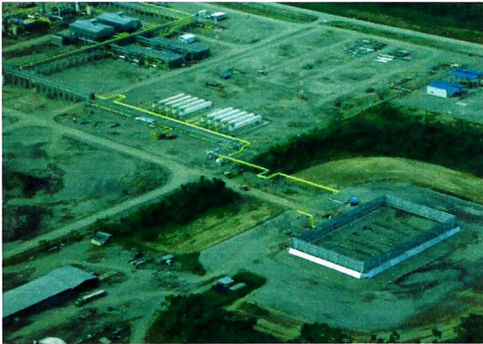
FotoN° 1 Ground Flare al sur de la Planta de Gas de Camisea
