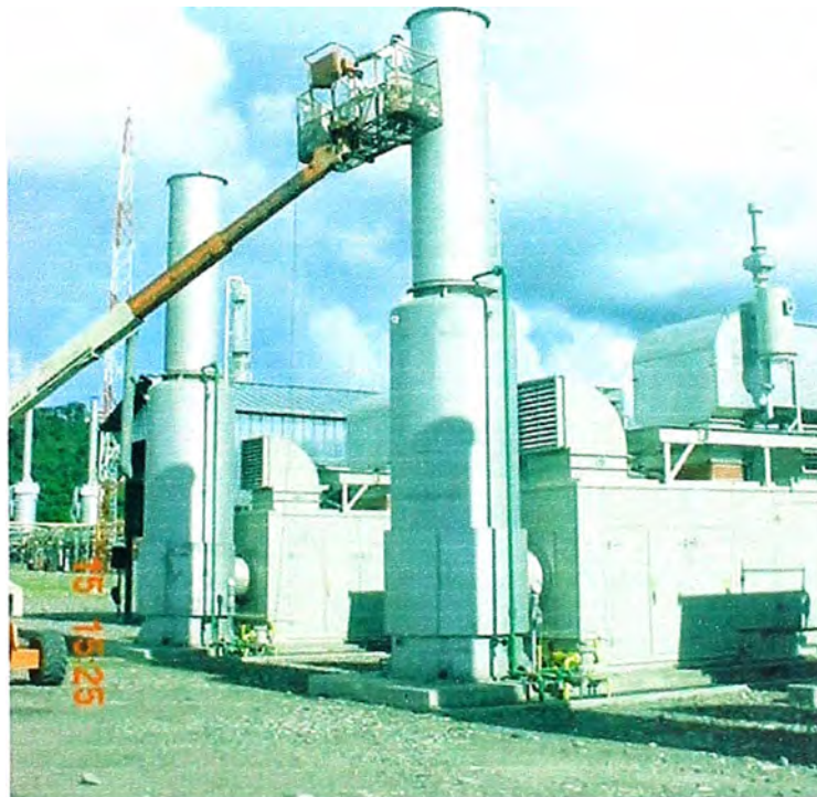
Foto N°2 Monitoreo de emisiones gaseosas de un Turbogenerador
