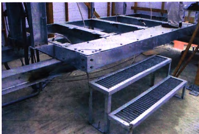
Fig. 4.19. Plataforma de Equipos instalada
