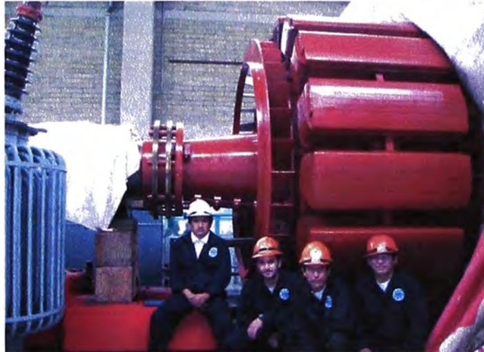
Fig. 2.1 Rotor del Generador
