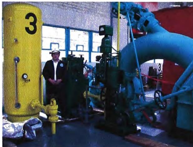
**Fig. 2.4 Regulador de Velocidad de los Generadores de la CHE Yaupi**
