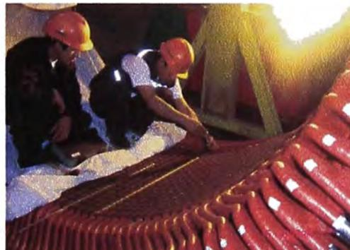
Fig. 5.21 Cuñado de bobinas
