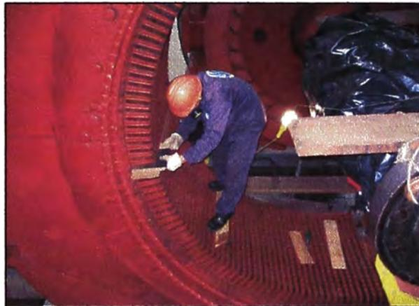
Fig. 5.11 Limpieza de núcleo del estator
