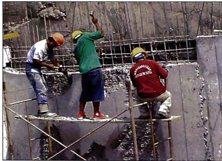
Fig. 9.10 Unidad de producción corrigiendo una actividad (Trabajo Rehecho)
