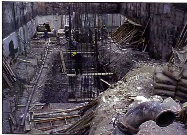
Fig. 8.8 Estudio de caso: Edificio multifamiliar Inclán IV
