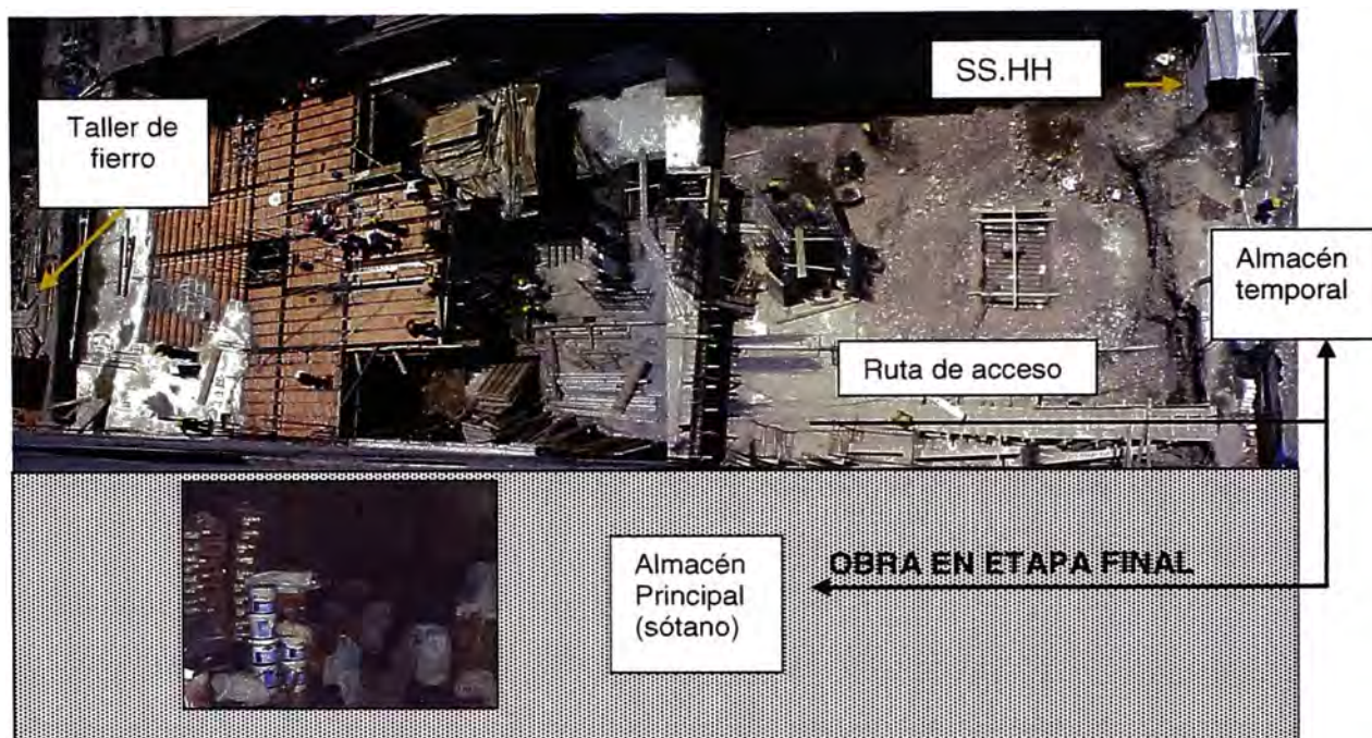
Fig. 8.11 Área de construcción y distribución de instalaciones auxiliares
