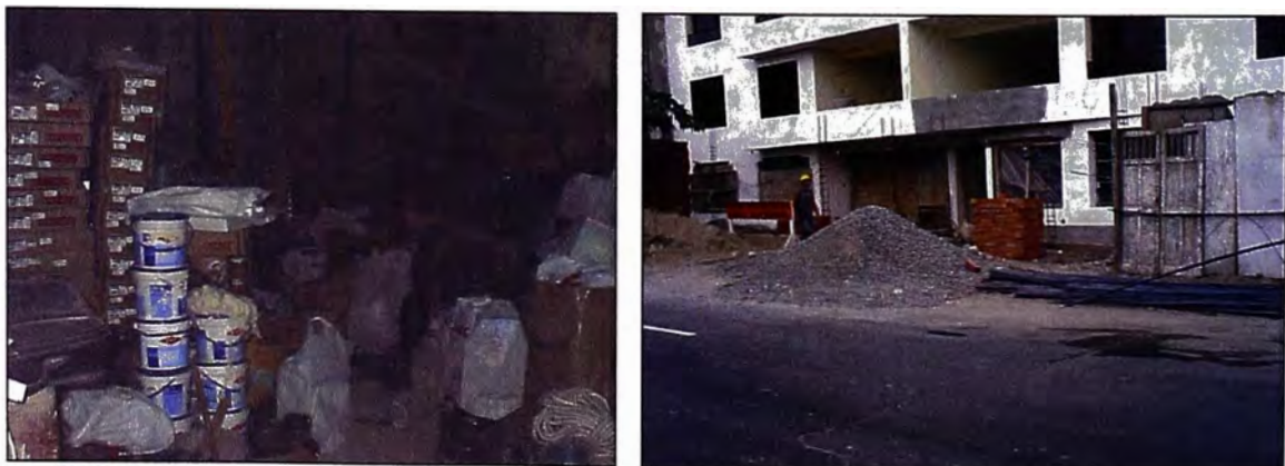
Fig. 8.10 Almacenes de la obra: Edificio Multifamiliar Inclán IV
