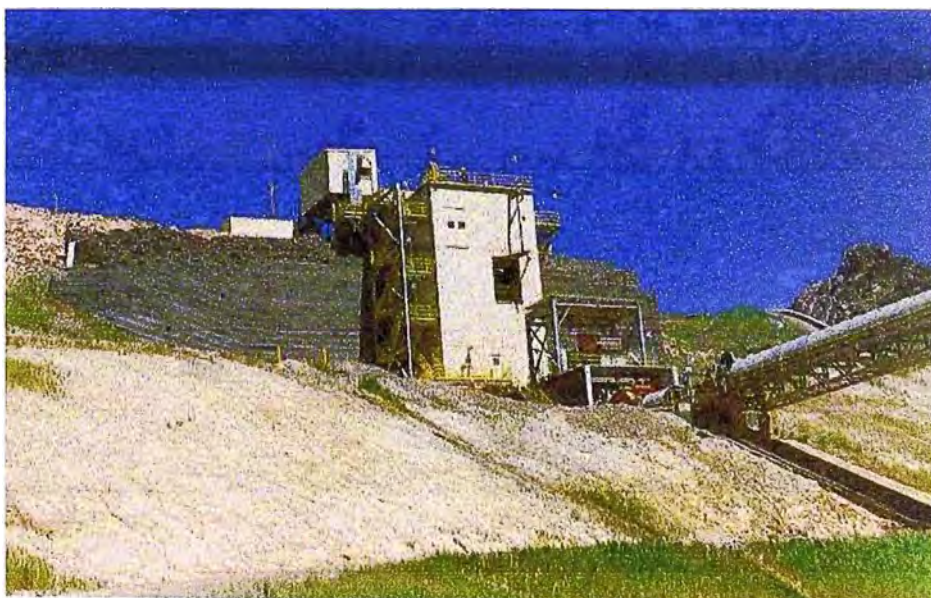
Figura N° 1: Planta de Chancado Primario
