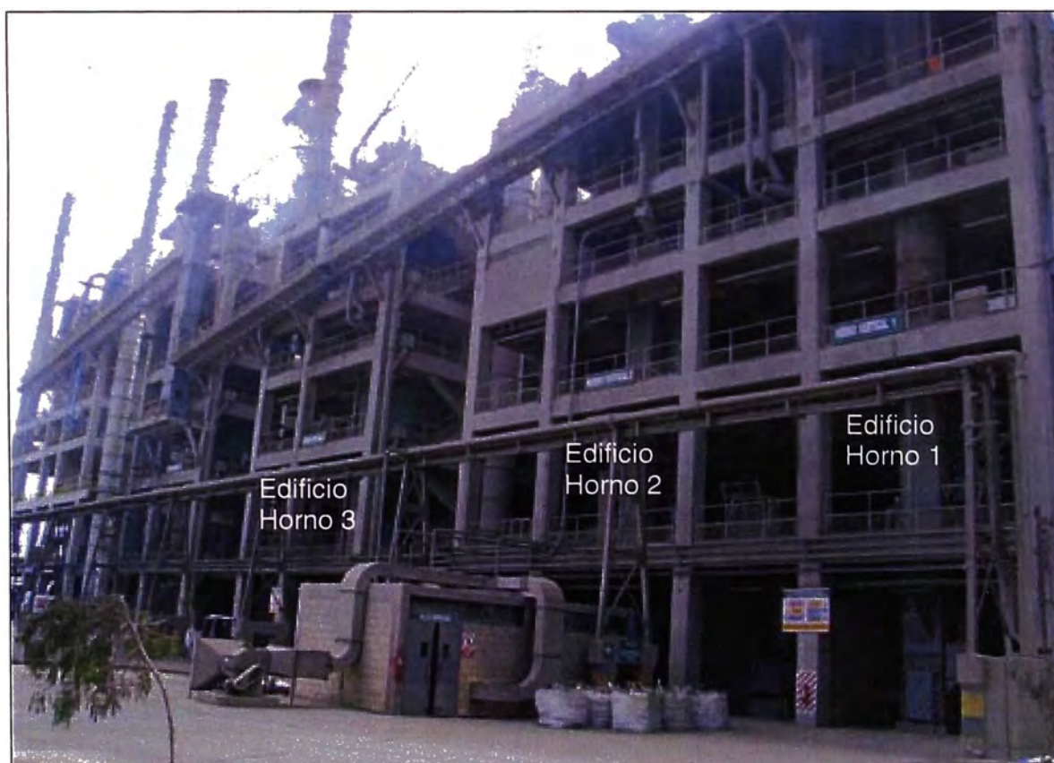
Figura 1.25 Hornos verticales (Fuente: Cementos Pacasmayo)
