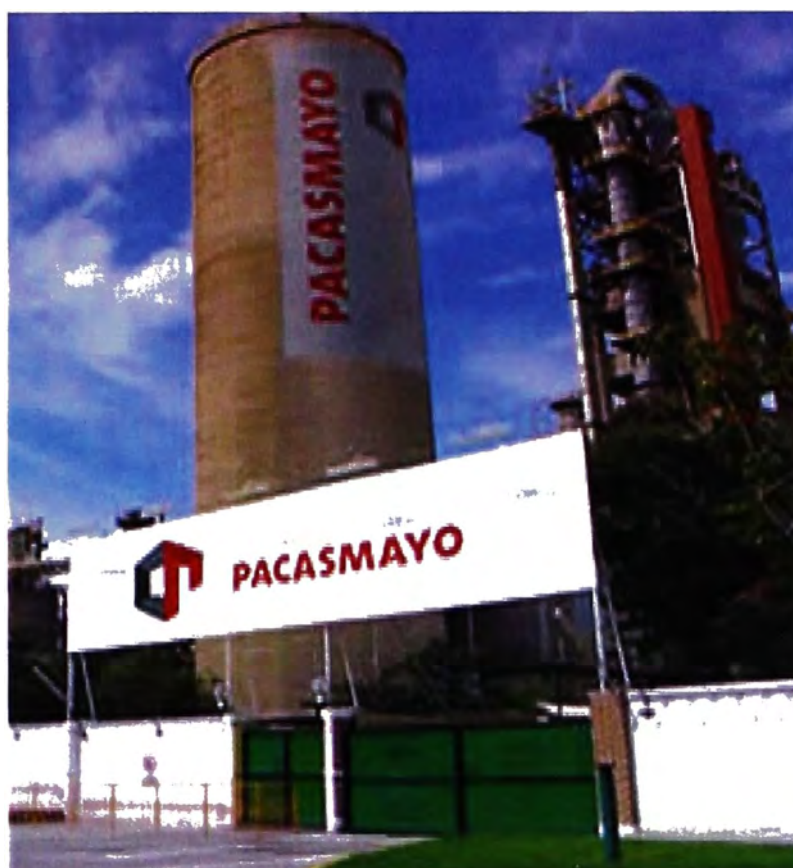
Figura 1.22 Silo Homogenización (Fuente: Cementos Pacasmayo)
