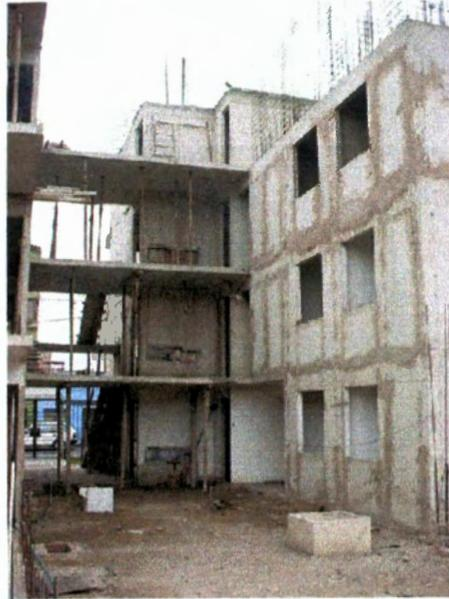
El proyecto se encuentra en pleno proceso de construcción, el sistema constructivo son las placas de concreto de espesor de pared de 10cm.
