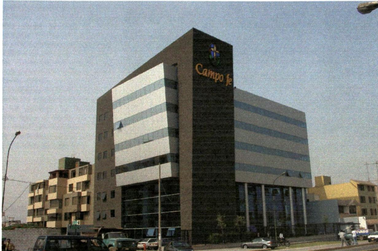
Tal como se ve en las imágenes el edificio se encuentra emplazado en una esquina, presentando volumétricamente un bloque inclinado que nace a partir de un cuarto nivel, atravesando otro bloque. En este sentido el arquitecto Daniel Herrera quiso además, resaltar estos diversos bloques aplicando el uso de diversos materiales, como fueron el cristal, el aluminio y revestimientos de enchapes de piedra gris oscuro.
