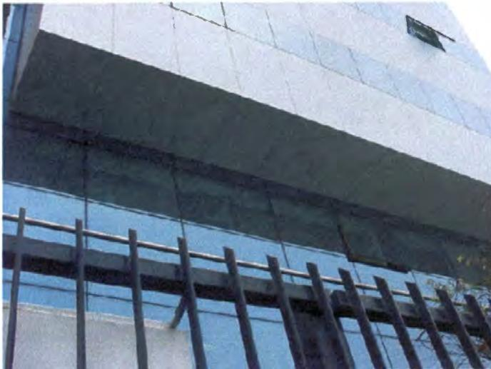
Tal como se observa en ambas vistas, el volumen superior se revistió con cintas horizontales de cristal y reynobond, teniendo que revestir las partes inferiores de dichos volúmenes, para lo que tuvimos que usar en esas zonas cintas de doble contacto fijadas a platinas de aluminio y a su vez el reynobond fijada a esta.
