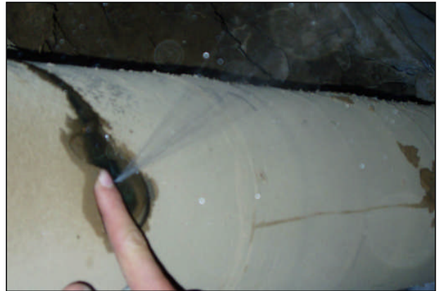
Fig. 19.- Tubería picada
