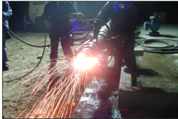
Fig. 18.- Proceso de Soldadura
