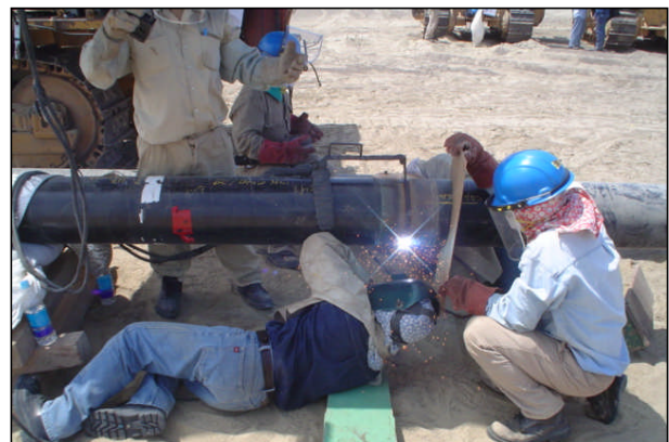
Fig. 17.- Soldadura de tubería
