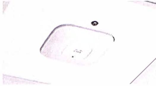
**Fig. 3.3** Posición correcta del punto de acceso inalámbrico para aprovechar su patrón de radiación al máximo
