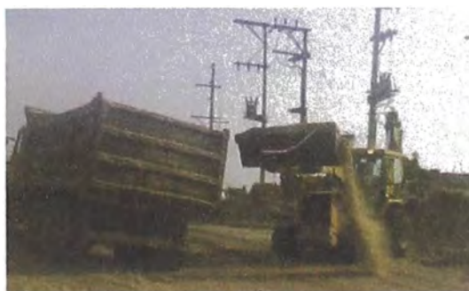
Fig. 4.21: Remoción de escombros de la zona de trabajo
