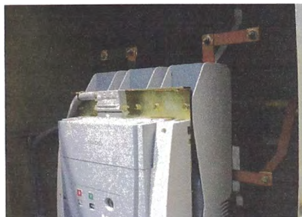
Fig. 4.19: Montaje del interruptor y dimensionamiento de las nuevas pletinas
