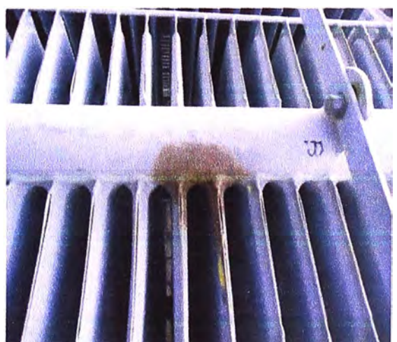
Figura 4.19 otra vista de fuga de aceite
