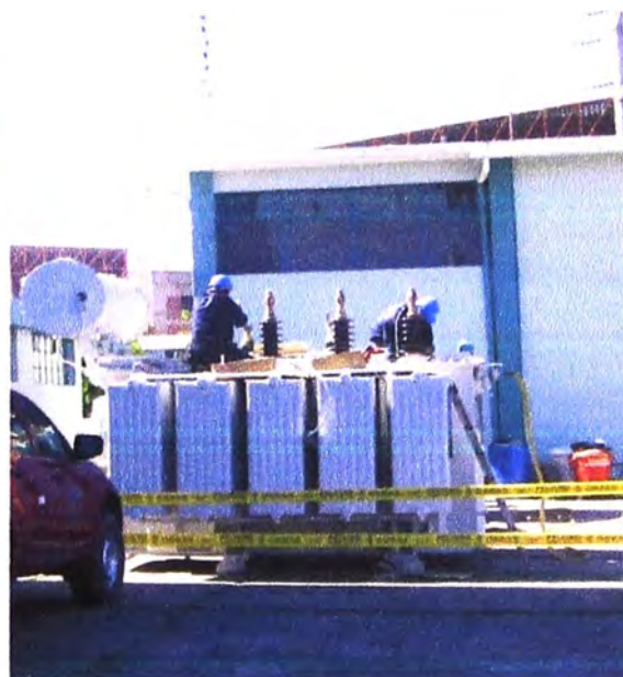
Figura 4.15 Corrigiendo el tubo de acople y las aletas
