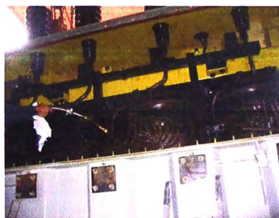
Figura 4.2 Lavado con chorros de aceite
