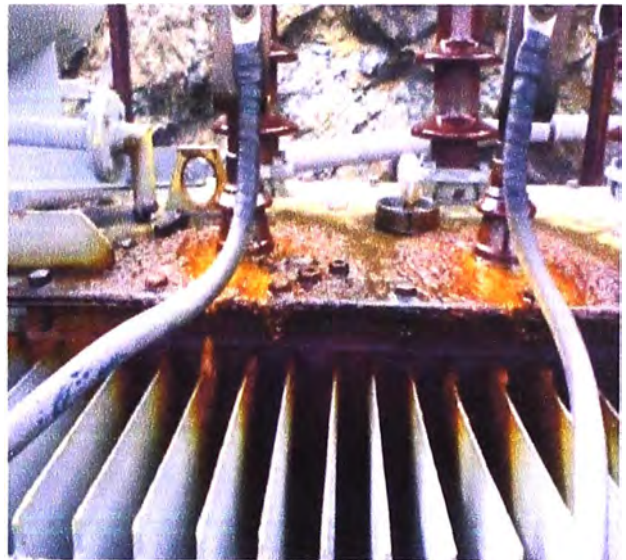
Figura 2.2 Corrosión ambiental
