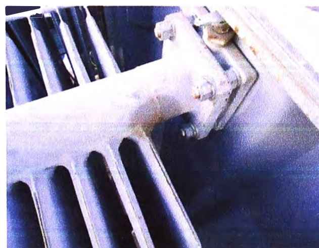
Figura 4.18 El radiador N° 08 presentaba fuga de aceite
