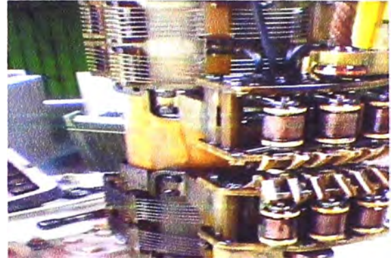
Figura 4.6 Limpieza y lijado de contactos móviles
