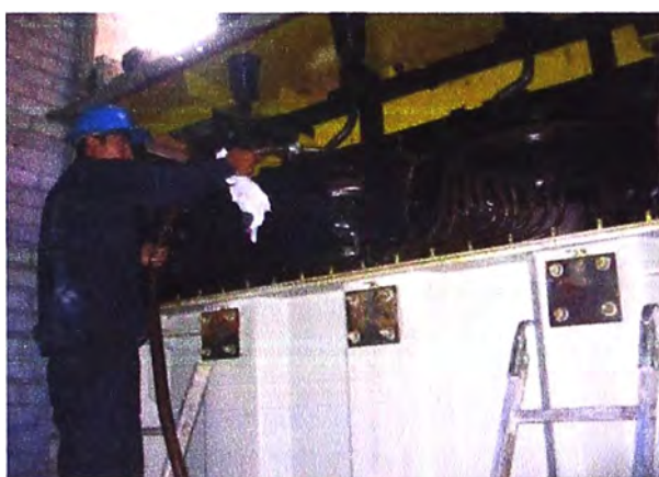
Figura 4.1 Lavado de bobinas
