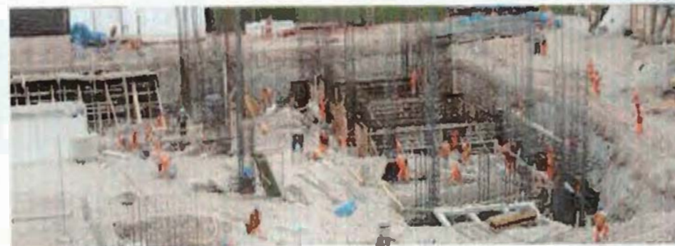
TRABAJOS DE CIMENTACION - SEPTIEMBRE 2006
