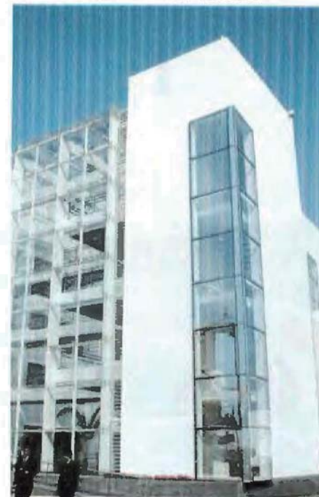
DETALLE DE FACHADA
