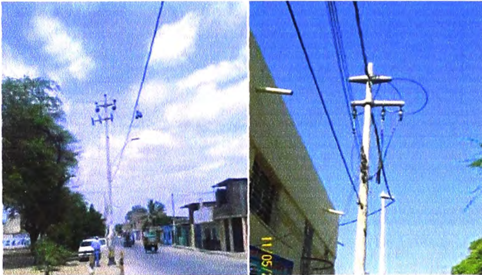
Figura 1.7 Recloser R10 y R2A(Fuente: Elaboración Propia)
