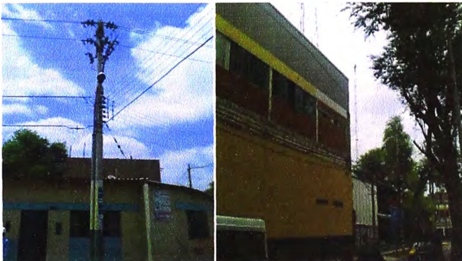
Figura 1.8 Recloser R13 y R5(Fuente: Elaboración Propia)
