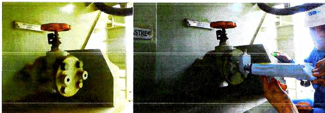
Fig. 5.7b Válvula de filtrado inferior del transformador donde se montará el DGA 150
