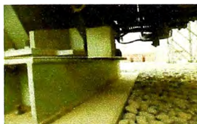
Fig. 5.7e,f,g,h,i Muestran el recorrido del cable RS-485 que conectara el DGA con el Qualitrol, esto se dará por un tubo conduit que bordea al transformador.
